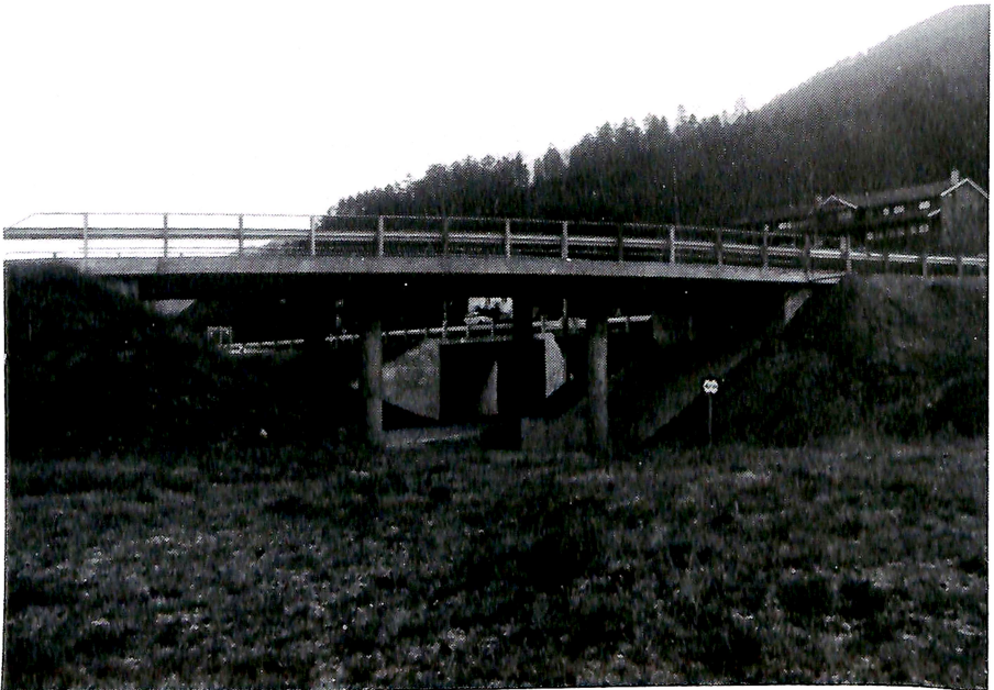
Brua over ny kommunal veg og undergang for felles boligveg.
