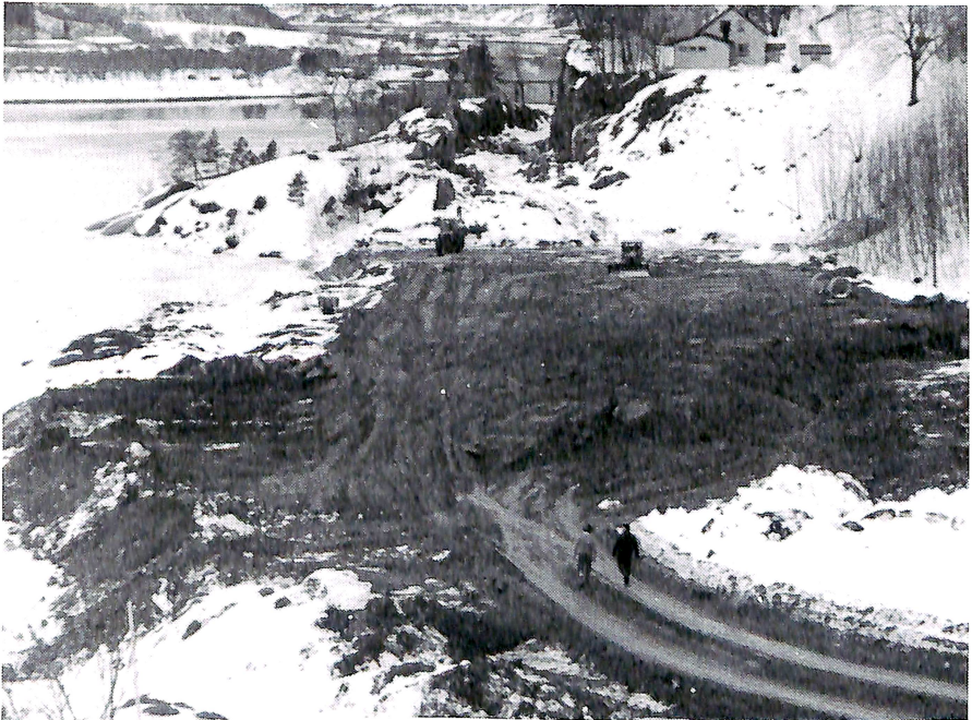
Utlegging av det første laget av sandputa i botnen av fyllinga.
