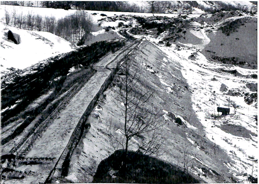
Ferdig utlagt fylling. Overbygningen på ca. 70 cm manglar enno.
