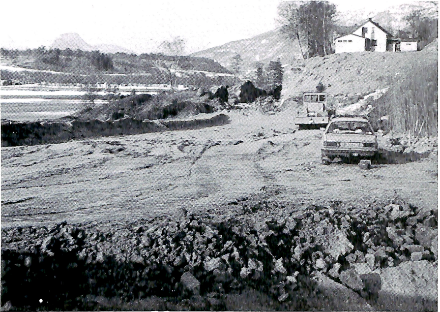
Klar til utlegging av den siste lagpakken med leire. Transportveg av sand i venstre del av profilet.
