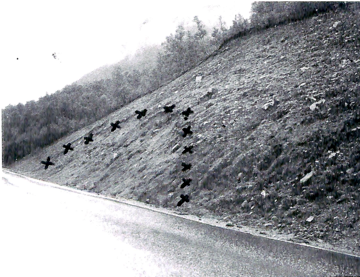
Et eksempel på tilstanden for mange vegskråninger. Graset er helt avsvidd og torvlaget har etterhvert begynt å rase ut.
