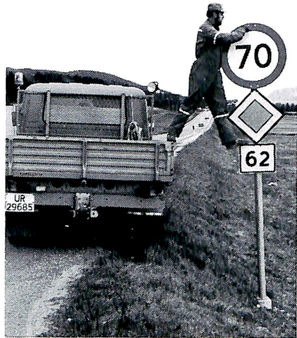
Skifting av fartsgrenseskilt ved Årø.
