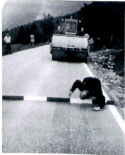
Vegmester Sæter måler spordybde på E69 ved Hovde.
