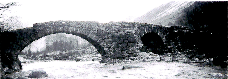
Kvistad bru (oppstraums) sett frå riksvegsida.
