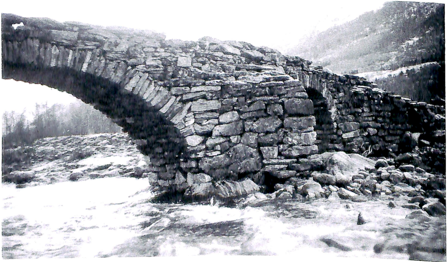
Kvistad bru med isbrytar på steinkar sett frå riksvegsida.
