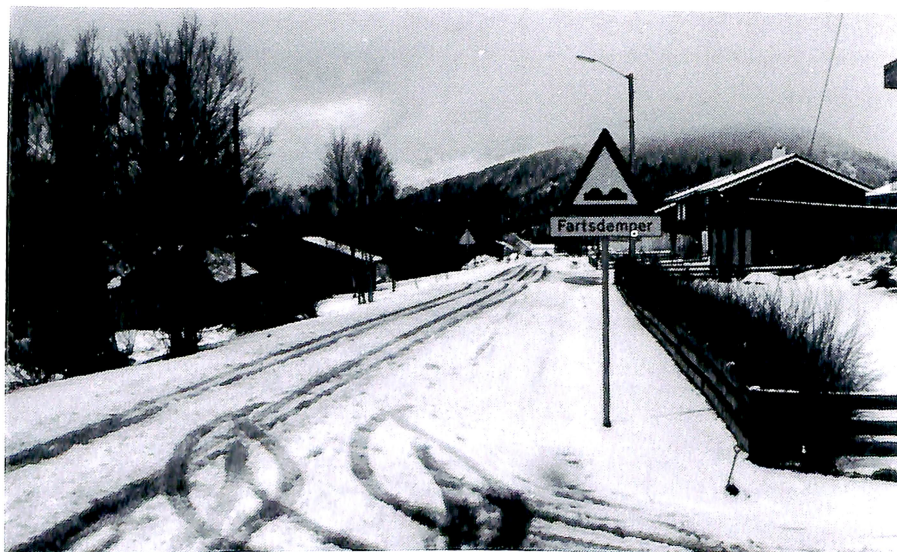
Denne fartsdemperen på en boligveg i Fræna, har ligget i flere år nå. Farestreknings lengde og «Maks. 30 km/t» bør angis på underskilt.
