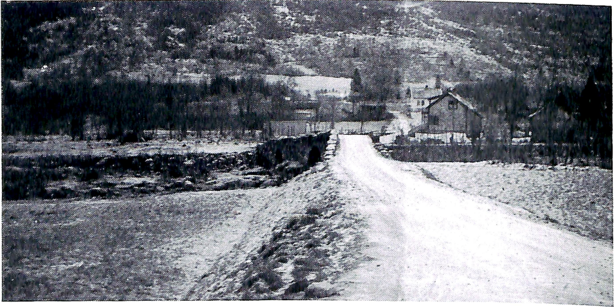
Kvistad bru sett frå riksvegkrysset mot Kvistad.
