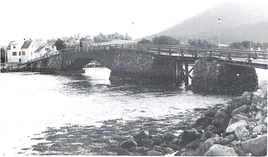
Vestnesbrua sett mot sørvest.
