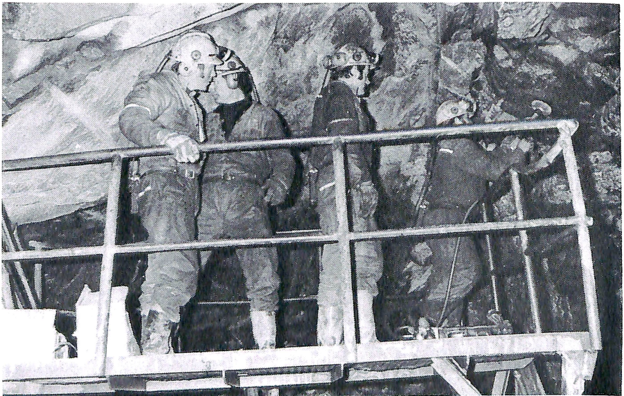
En av tunnelgjengene i gang med å boltesikre et parti i tunnelen.
