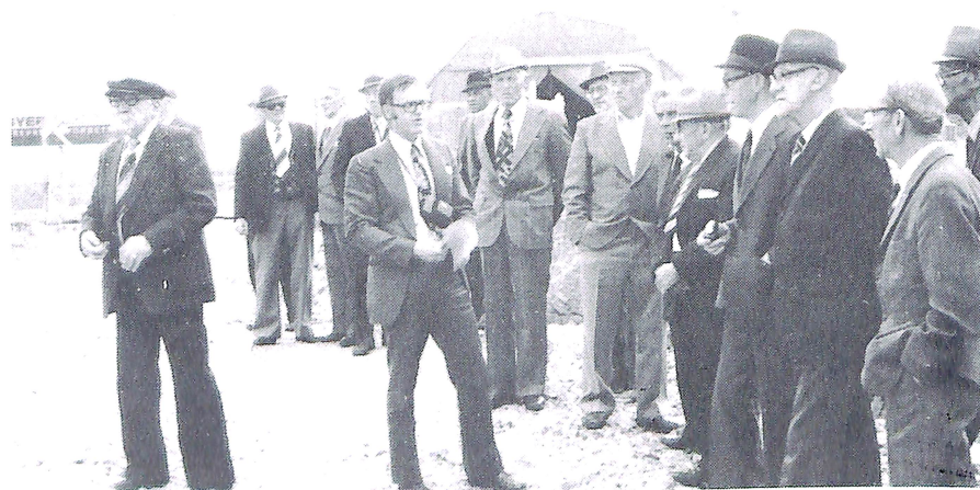
Overing. Kjell Loen i midten orienterer om byggingen av Nordsund bru.
