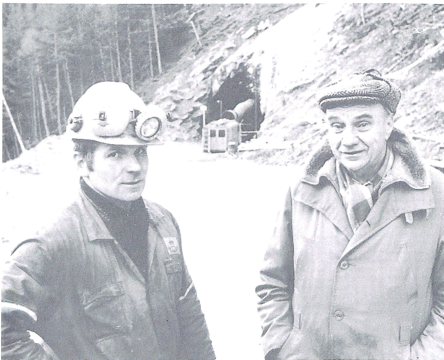
Anleggsleder Samdal i samtale med tunnelreparatør Hanestadhaugen ved den 590 m lange Ringset-tunnelen.
