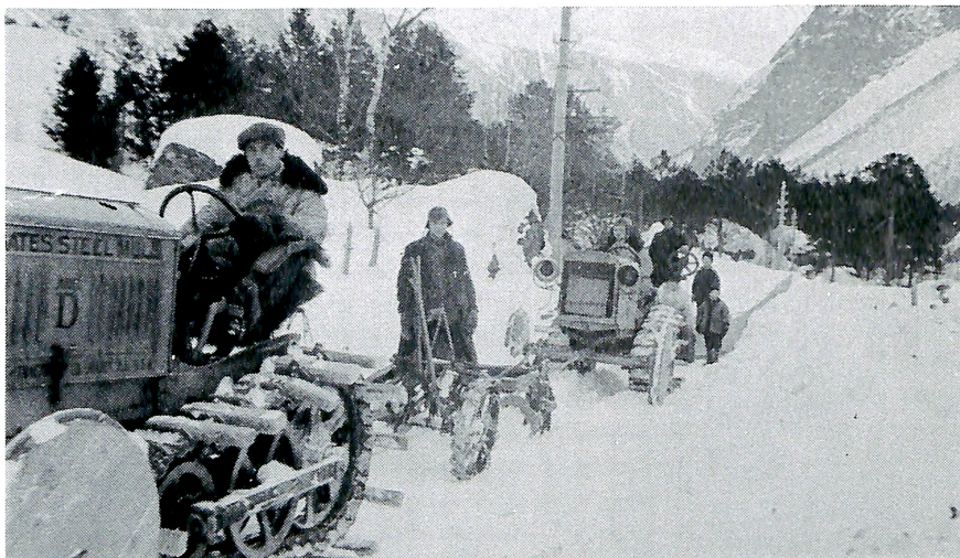
Traktorar med høvel og plog på Romsdalsvegen i 1922.
