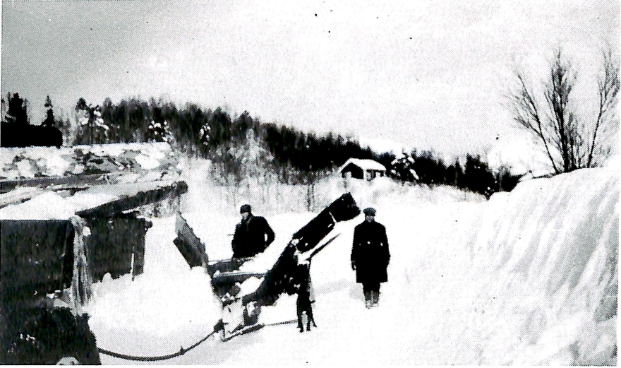
Frå opprømmingsarbeid på Batnfjordsfjellet.
