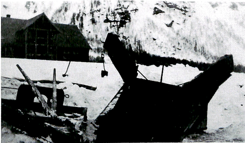
Ispløgg og snøpløgg bruka på Romsdalsvegen i 1922.
