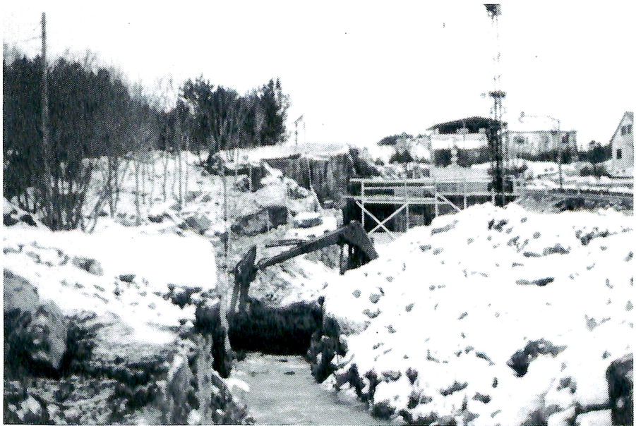
Sprengning av grøft for hovedvannledning, hovedkloakk m.m på Gomalandet.
