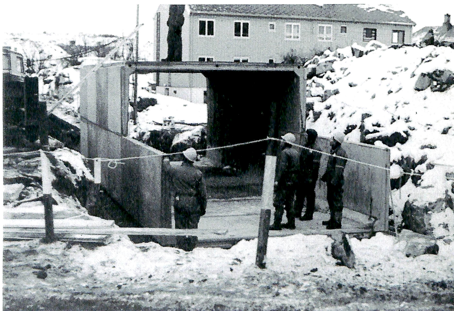
Montering av prefabrikkert betongkulvert på Gomalandet.
