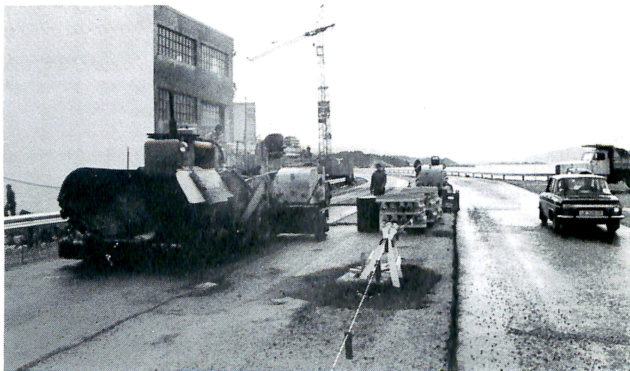
Dekkelegging, kantsteinmontering, massetransport og rekkverksoppsetting midt i trafikken gikk ikke alltid så velordnet som her.
