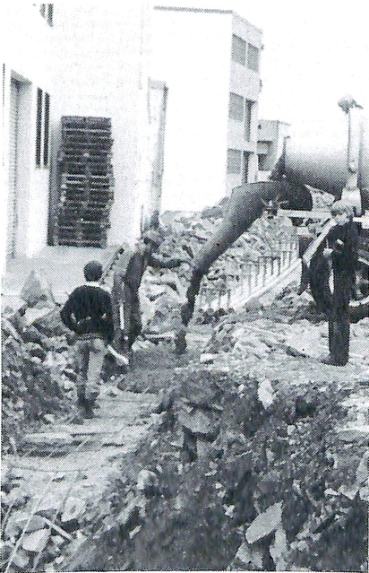
Kabler og rør kryr det av i den nye veg- gen. Her er det televerket som stø- per inn sine varerør før vegvesenet får slippe til med videre arbeid.
