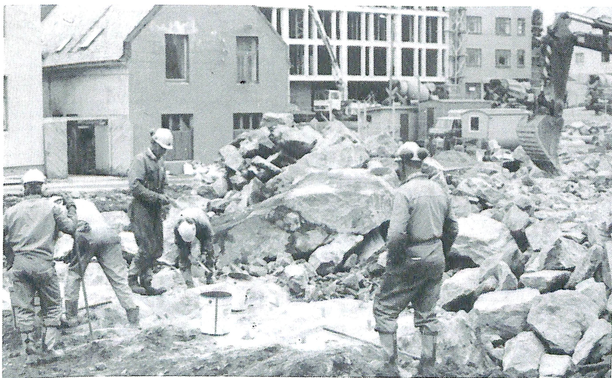
Det ble et omfattende flåspregingsarbeid midt i det trafikkerte Ålesund sentrum.
