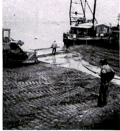
Vanning av fylling
