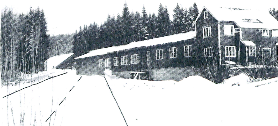
Den gamle vegsentralen som ble bygget ca. 1925, vil bli revet.
