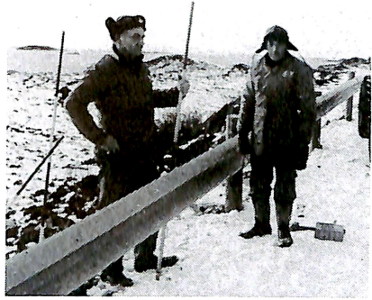
Andreas (fra anlegg) og Kristian Myrvang samarbeider om rekkverkoppsetting på Aukra langs lite tilfrosne februar-veger.
