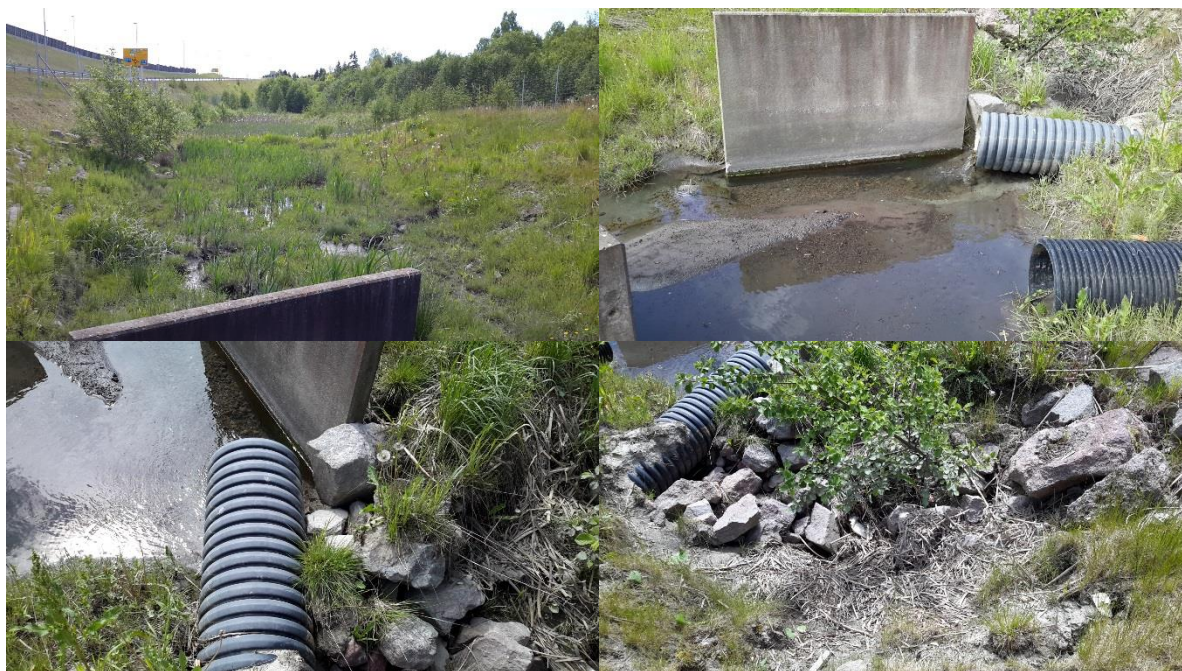
Figur 9: Bilder fra Steinbjørnrød rensebasseng sommeren 2015. Øverst til venstre: oversiktsbilde. Øverst til høyre: Innløp forbasseng. Nederst: innløp forbasseng to perspektiv. (Foto: Espen Rise Gregersen 2015)
