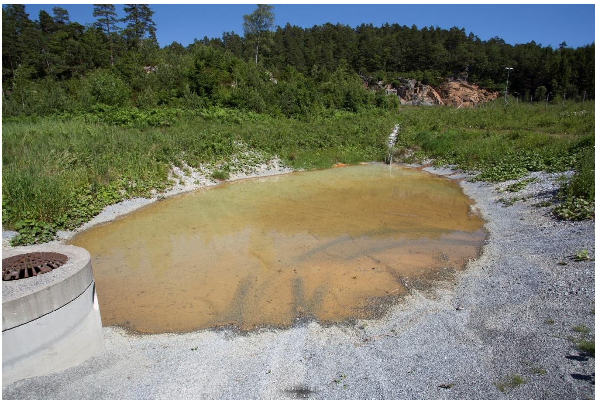
Figur 11: Renseanlegget Urevann. Behandling av aluminiumholdig vann fra sulfiddeponi. (Foto: Espen Rise Gregersen 2015)
