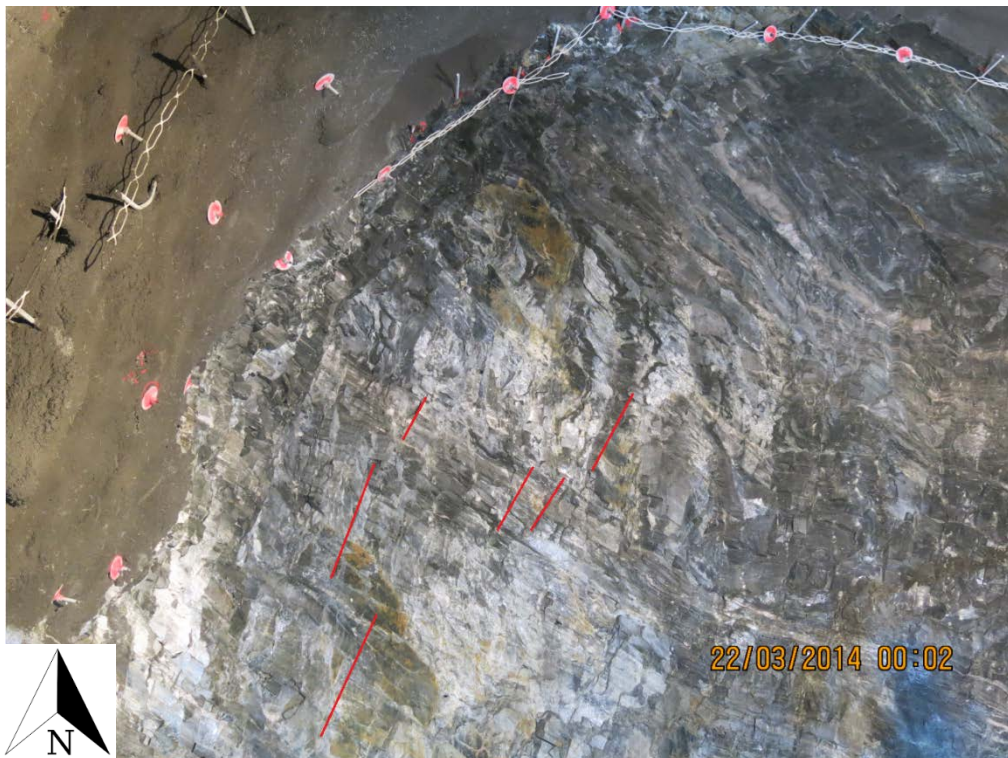
Figur 9 Sprekkesett 3 var mer sporadisk tilstede under drivingen, og kan ses som mindre «stikk» i stuffen. Se stiplede linjer. Bildet er tatt fra søndre stuff.
