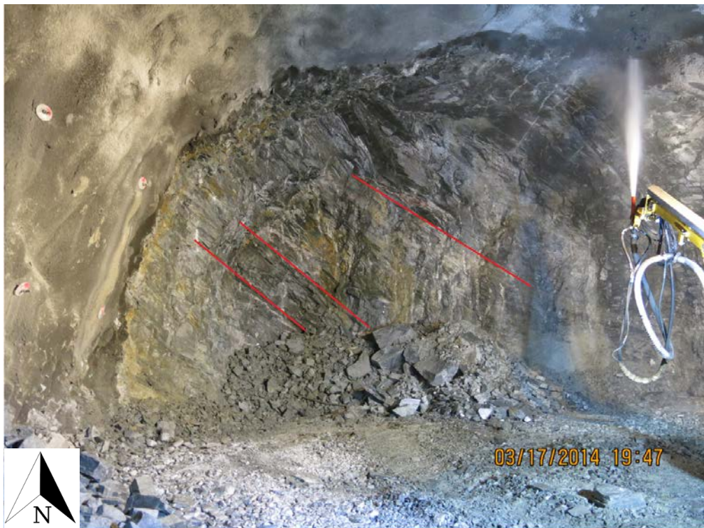
Figur 7 De røde stiplede linjene viser hvordan orienteringen til sprekkesett 1 så ut fra stoff. Dette er lagdelingen. Bildet er tatt fra søndre stoff.
