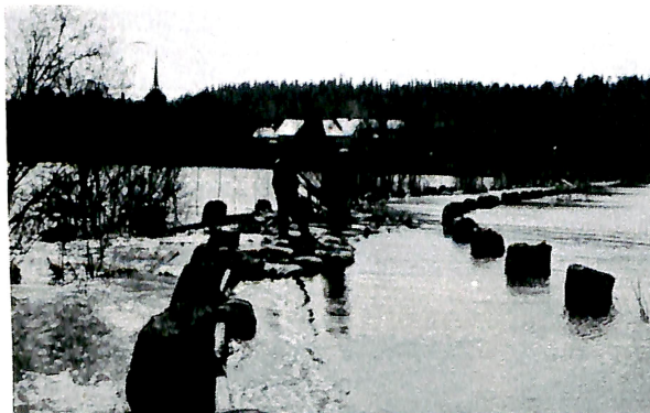
Utlegging av sandsekker
