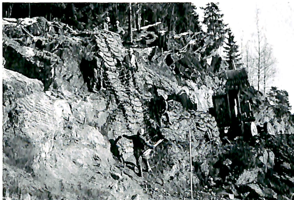
Omleggingsarbeid ved Stein gård på E-6 i Ringsaker.
