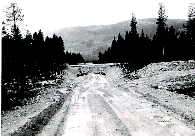
Fra arbeidet med jernbaneundergangen nord for Atna
