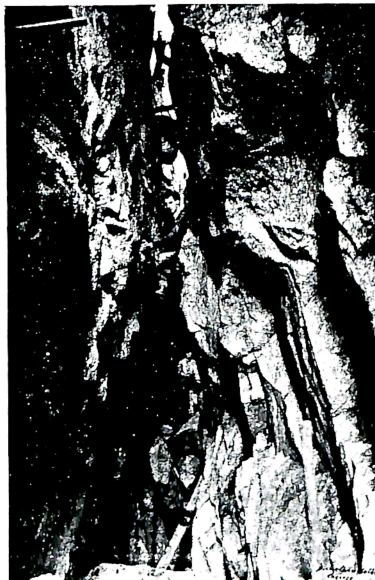
Sprekk i Kløvhaugen.
