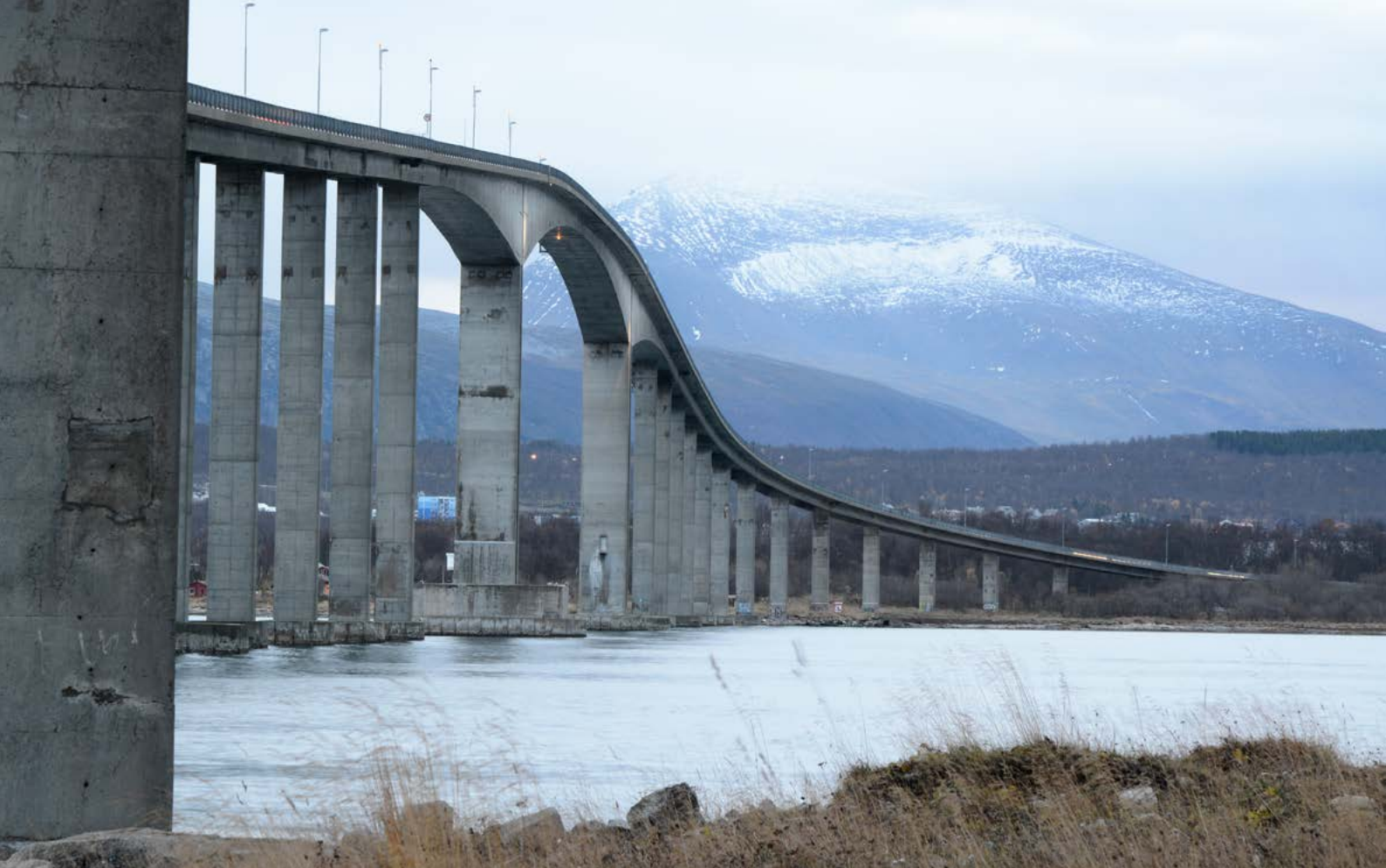
Figur 30: Sandnessundbrua – dagens forbindelse til Kvaløya (Foto: Knut Opeide, SVV).
