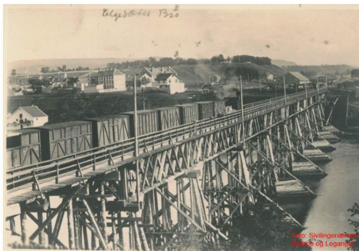
Figur 3.2: Kongsgårds bru fra 1863 (mot Gløshaugen) [25]
