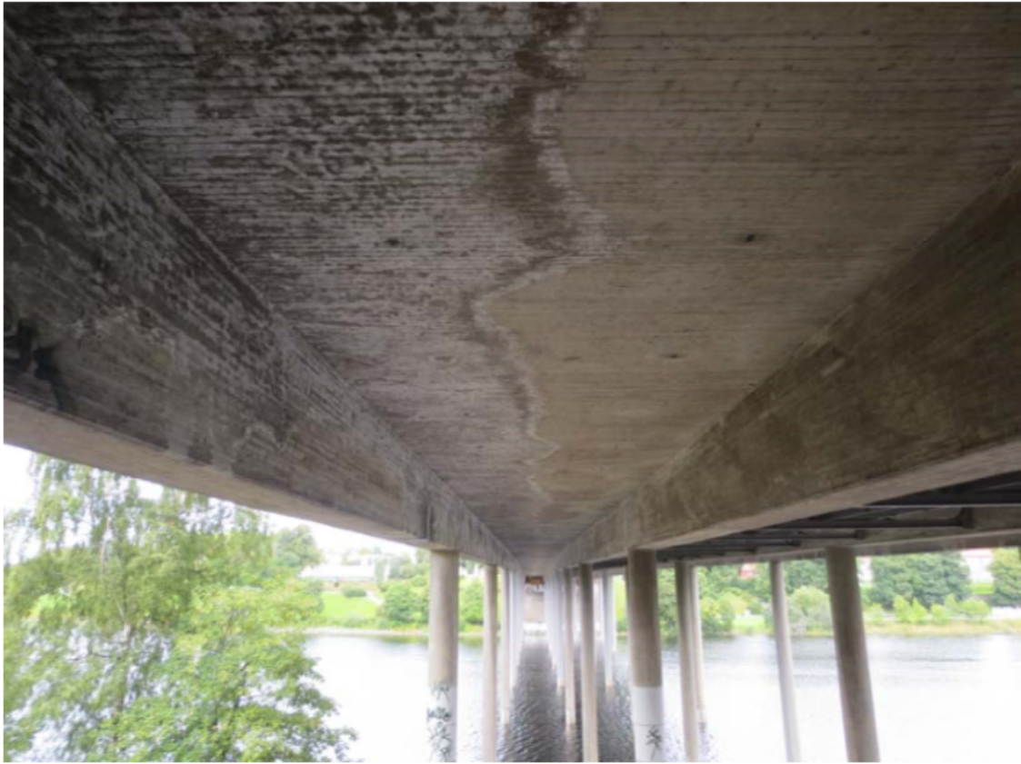
Figur 3.18: Underside av brudekket [16]
