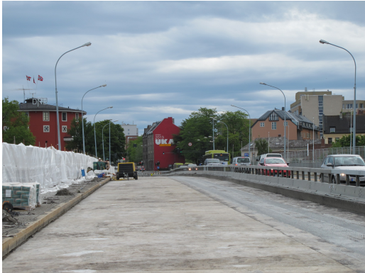
Figur 3.10: Østlig side av brua etter fjerning av asfalt og membraner under rehabiliteringen av brua i 2014-2015 [3]
