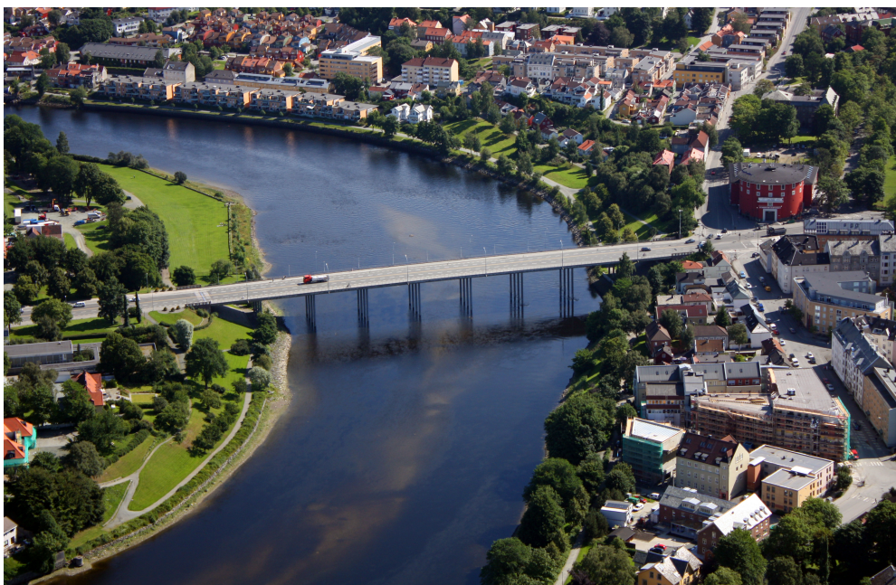
Figur 3.1: Elgeseter bru sett fra vest
