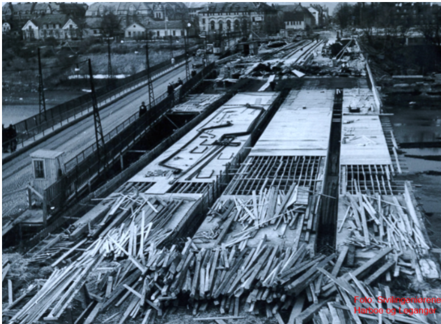
Figur 4.3: Bilde av forskaling under bygging
