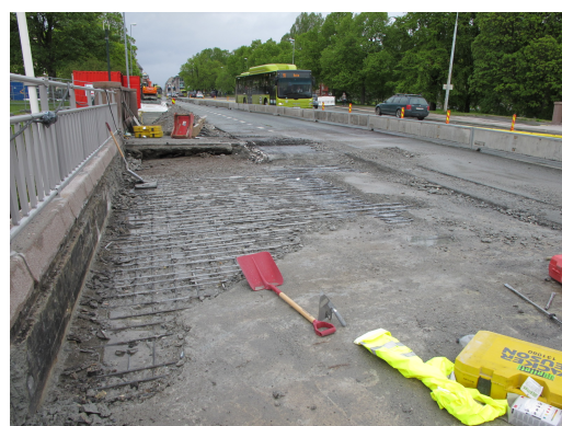
Figur 3.9: Vestre enden av brua etter fjerning av delaminert betong [3]
