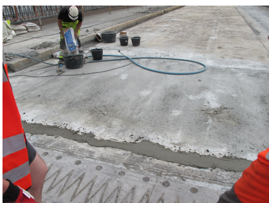
Figur 3.8: Brudekket ved fugen etter reparasjon [3]
