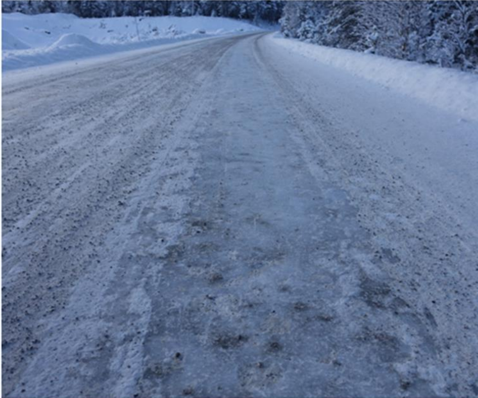
Figur 7-12 Varighet av tørrsandtiltak. Her har ca. 100 personbiler passert etter strøtiltaket. Det er mye sand som ligger mellom hjulsporene, men i hjulspor er det lite igjen. (Foto: Bård Nonstad, Statens vegvesen)
