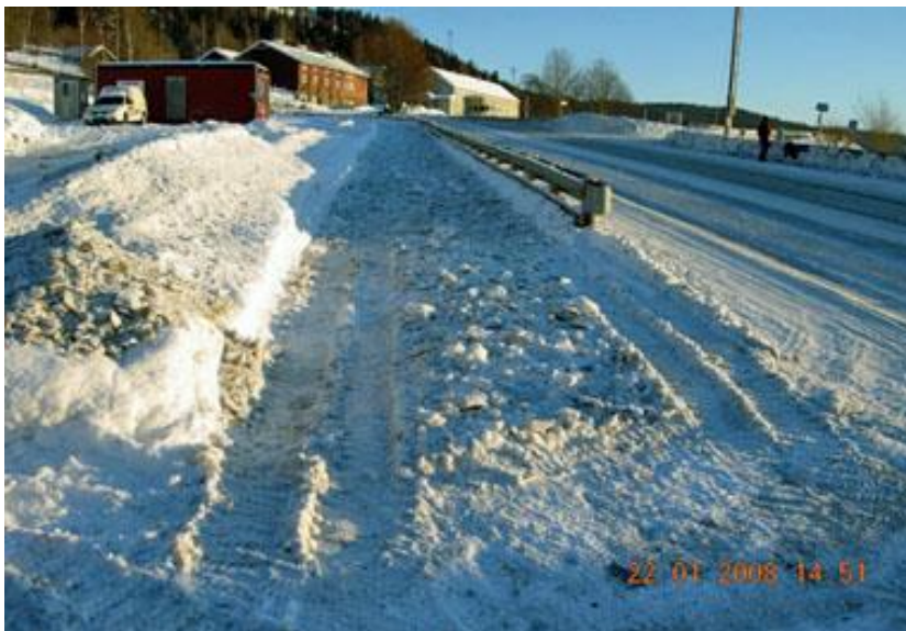
Figur 2-46 Brøyting av kjørebane etter gs-vegen (Foto: Statens vegvesen)
