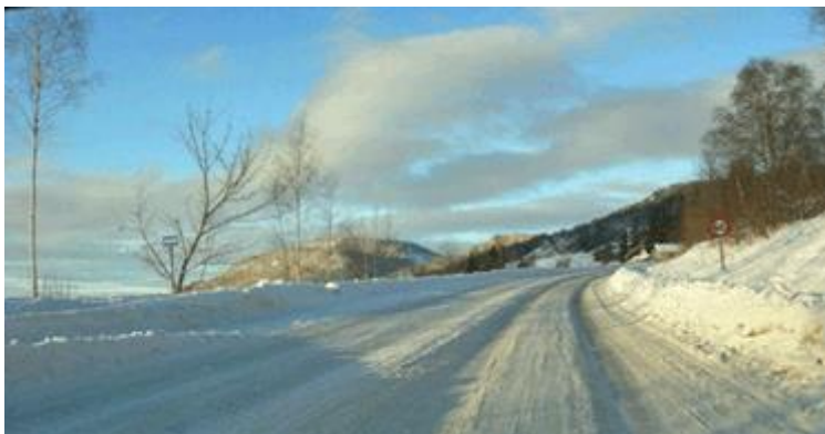
Figur 2-31 Sporete vegbane (Foto: Statens vegvesen)
