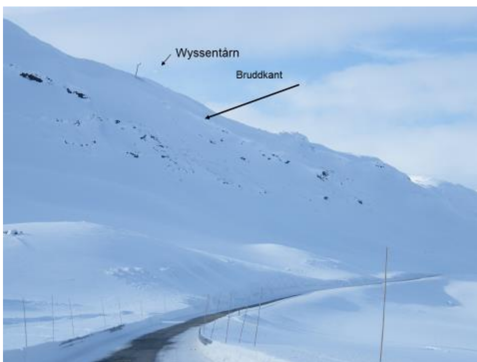
Figur 4-96 Wysstårn brukt til nedsprengring av snøskred på fv. 53 Årdal-Tyin. Tårnet har flere sprengladninger som kan avfyres trådløst etter behov. (Foto: Njål Farestveit, Statens vegvesen)
