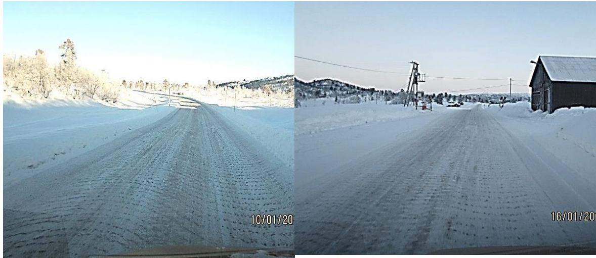
Figur 7-9 Varighet av fastsandmetoden på lavtrafikkert veg og under stabile værforhold. Bilde er tatt rett etter utlegging, friksjon 0,49 i gjennomsnitt. (Foto: Stein Åsheim, Statens vegvesen)
