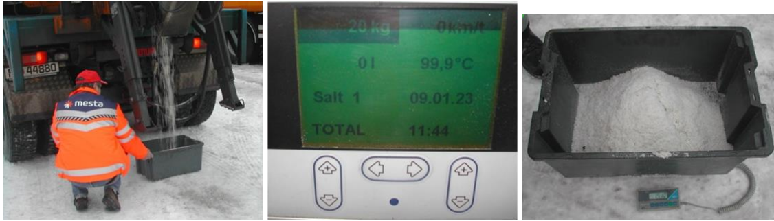
Figur 6-24 Kontroll/kalibrering av spredder med oppsamling og veiing
