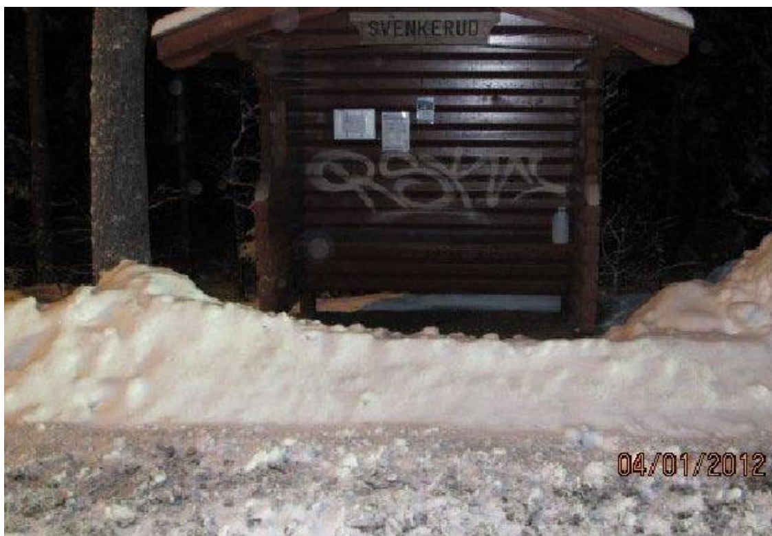
Figur 4-72 Mangelfull rydding foran leskur (Foto: Kjetil A. Bø, Statens vegvesen)
