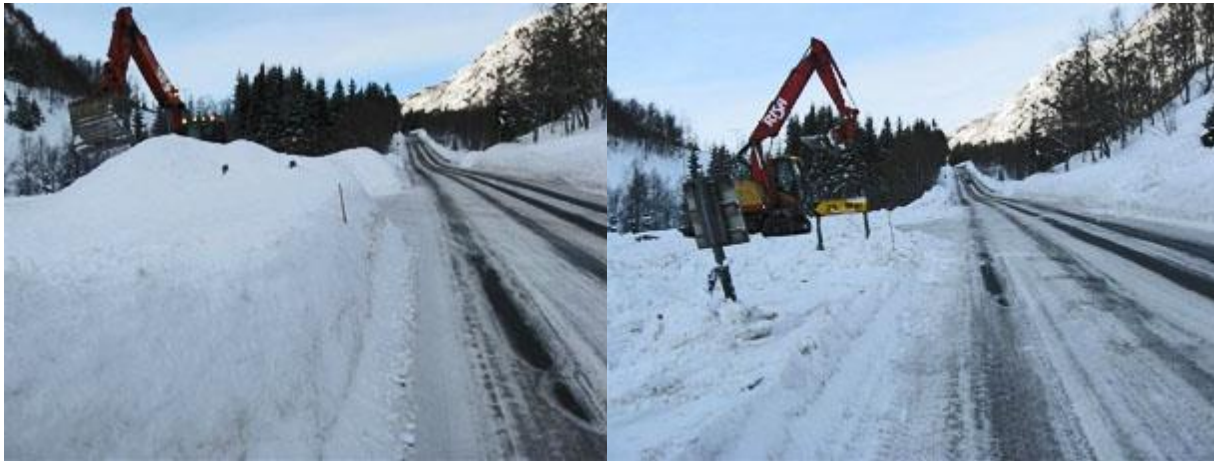
Figur 2-58 Siktrydding med hjulgående gravemaskin (Begge foto: Risa)
