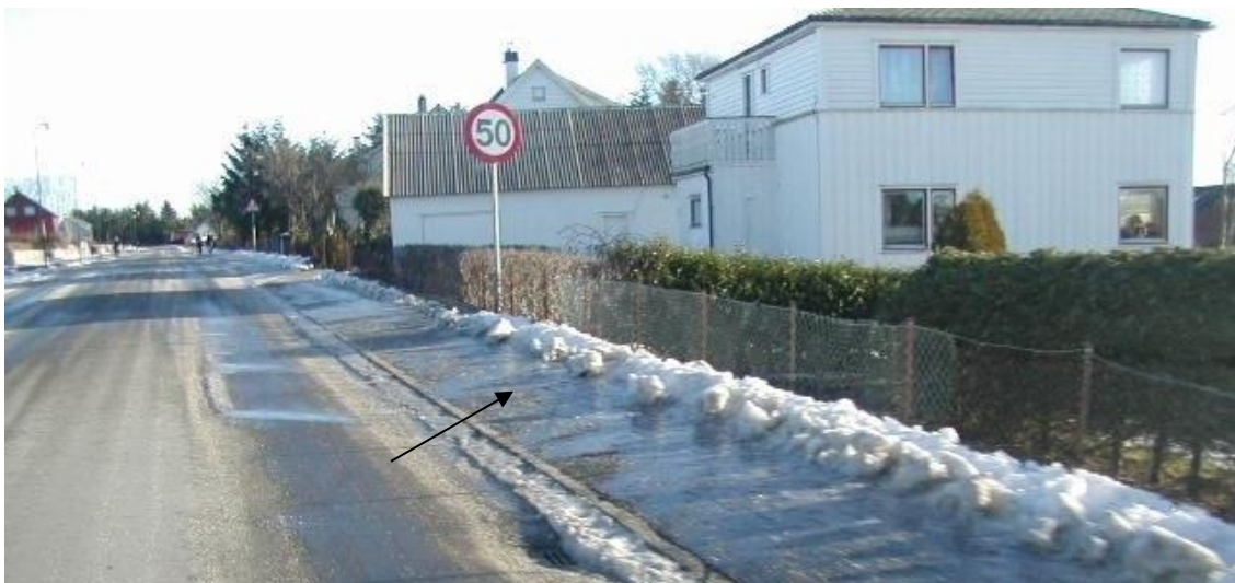
Figur 4-67 Eksempel på uheldig utførelse av brøyting av fortau
