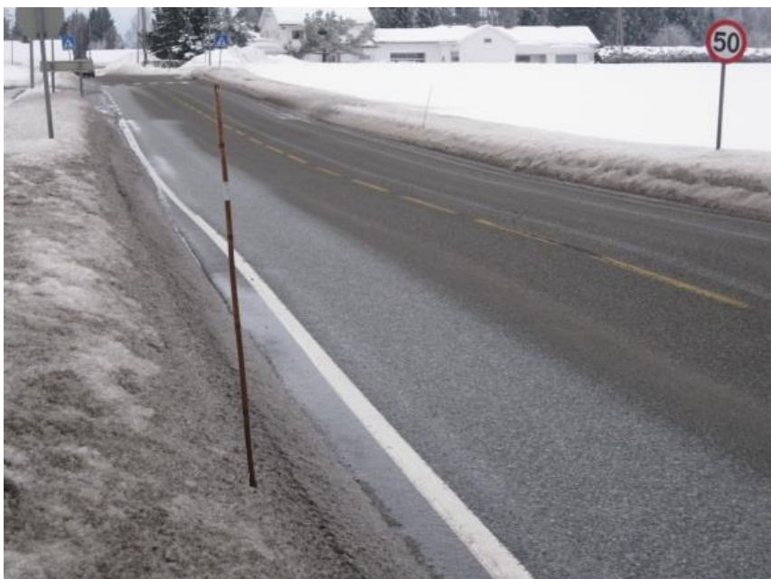
Figur 9-11 Riktig utsetting av brøytestikk er viktig for gjennomføring av vinterdrift (Foto: Statens vegvesen)
