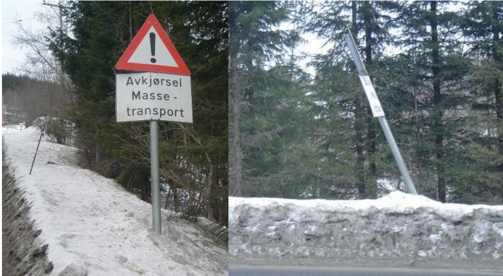
Figur 9-25 Skade på skilt (Foto: Statens vegvesen)
