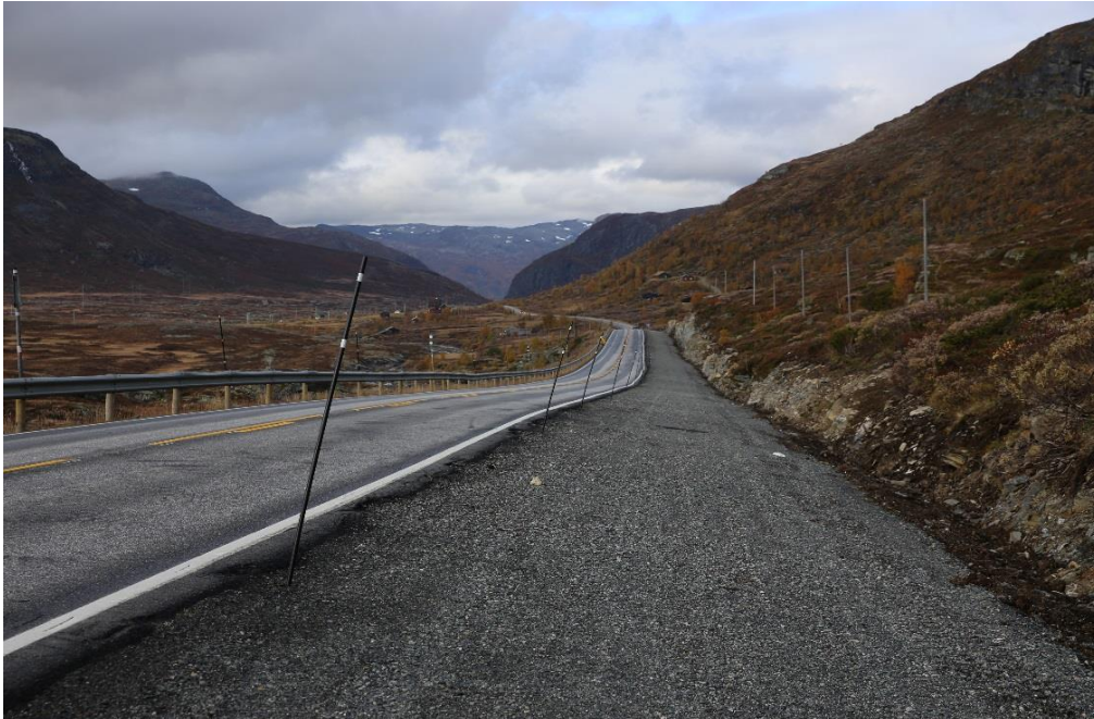
Figur 4-99 Opparbeidet fresegate i skjæring på rv. 52 Hemsedalsfjellet (Foto: Åsmund Espe, Statens vegvesen)
