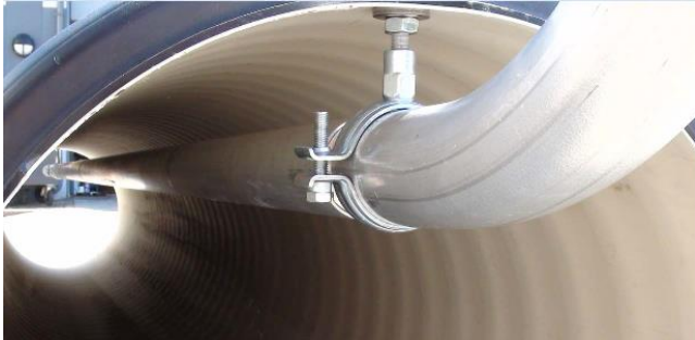
Figur 9-33 HeatWork. Tinerør montert inni stikkrenne (Foto: HeatWork)
