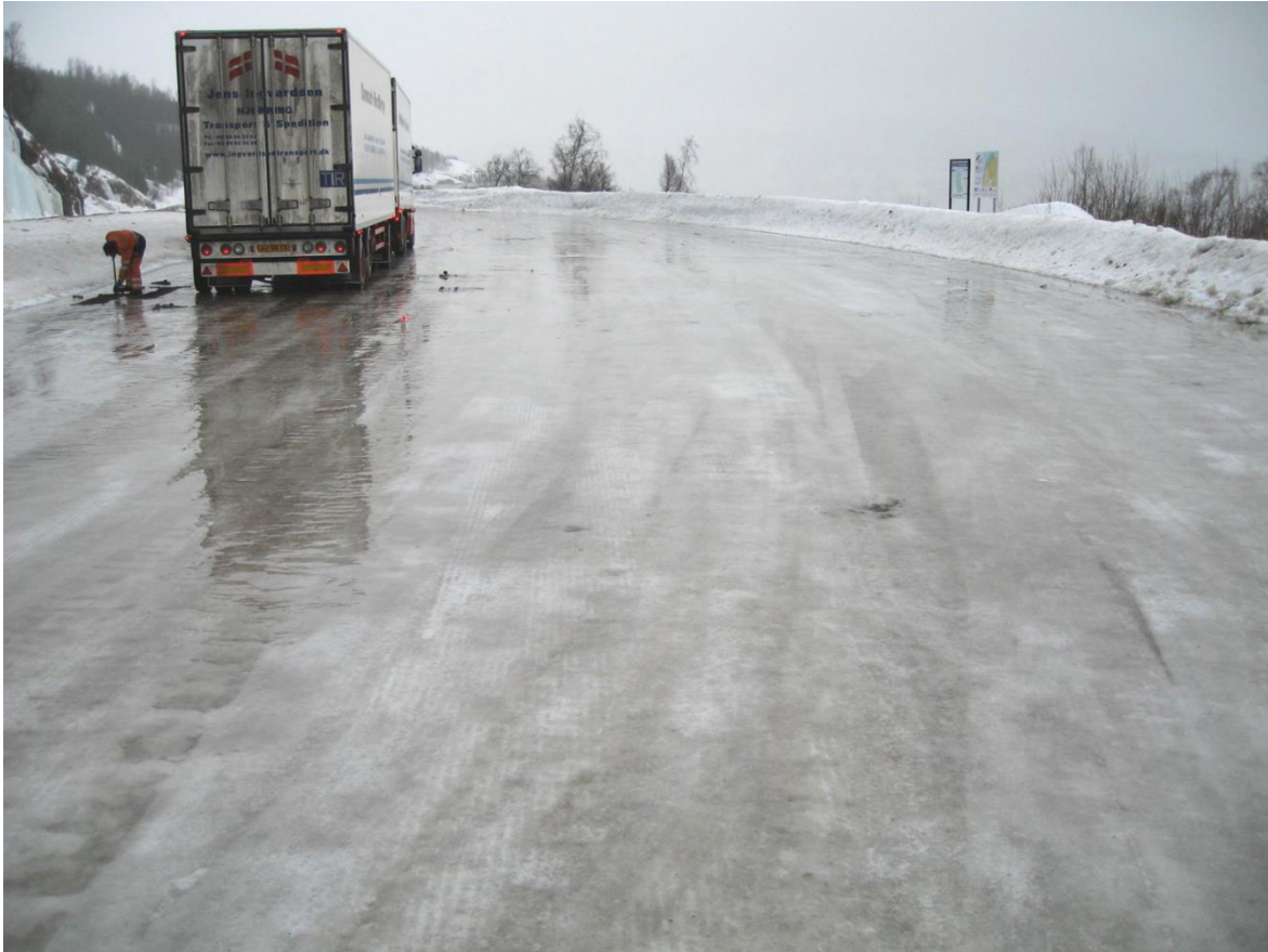
Figur 7-16 Våt is på sideanlegg med behov for tiltak (Foto: Statens vegvesen)
