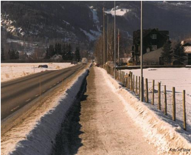
Figur 7-14 Gang- og sykkelveg hvor den ene halvdel er strødd og den andre ikke. Såkalt «sparkstandard» (Foto: Alf Støle, Statens vegvesen)
