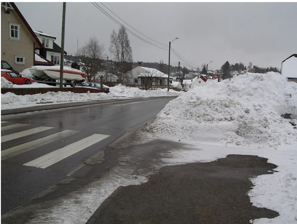
Figur 2-51 Plassering av snø i siktsonen etter at fortauet er brøytet (Foto: Arild Nærum)
