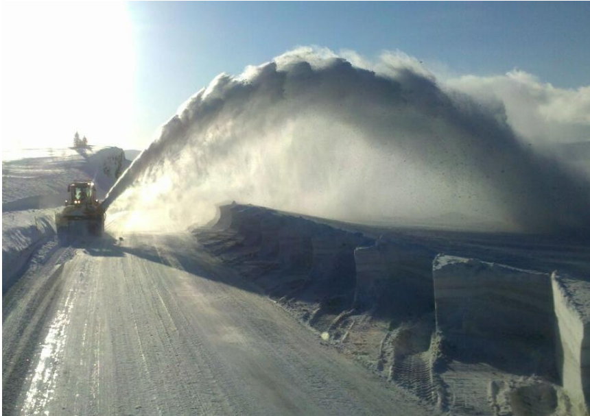
Figur 4-80 Fresing av brøytekanter, Ev6 Gratangsfjellet 2013 (Foto: Jan Lind, Statens vegvesen)
