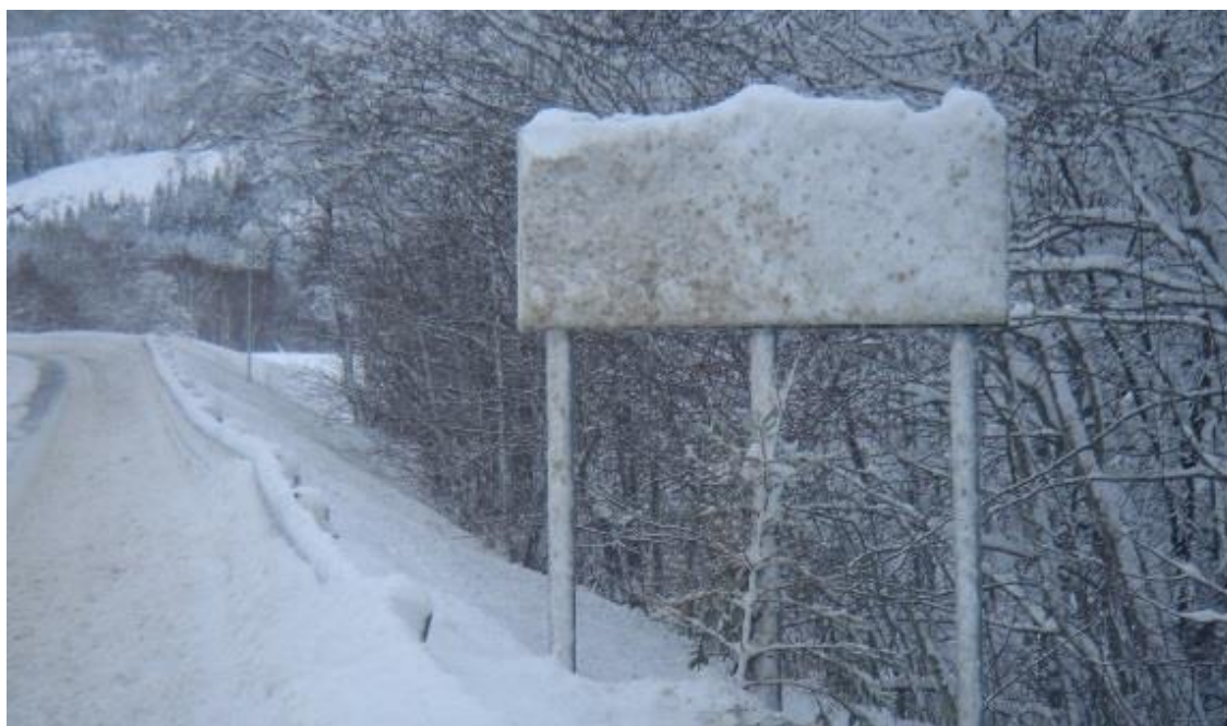
Figur 9-17 Snø på skilt som følge av sprut etter brøyting
