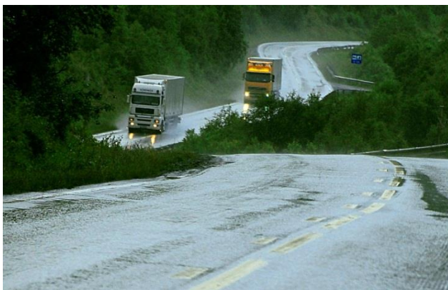
Figur 5-7 Friksjon på våt veg, \mu=0,40-0,90 (Foto: Knut Opeide, Statens vegvesen.)
