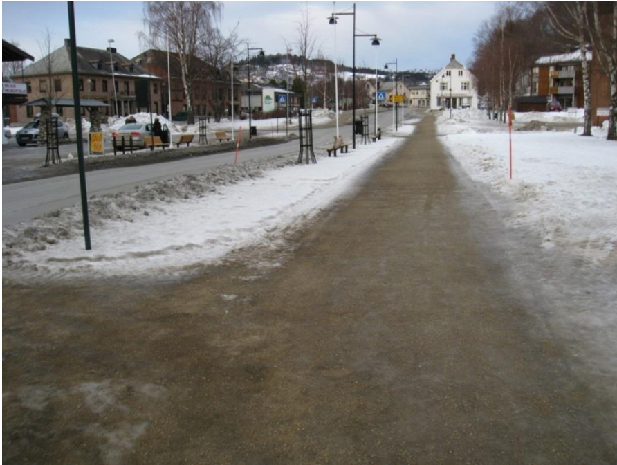
Figur 7-15 Eksempel på strøing av G/S-veg, vinterdriftsklasse GsB (Foto: Øystein Larsen, Statens vegvesen)
