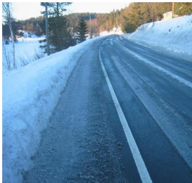
Figur 9-12 Feilaktig plasserte og manglende brøytestikk kan føre til ulykker (Foto: Statens vegvesen)
