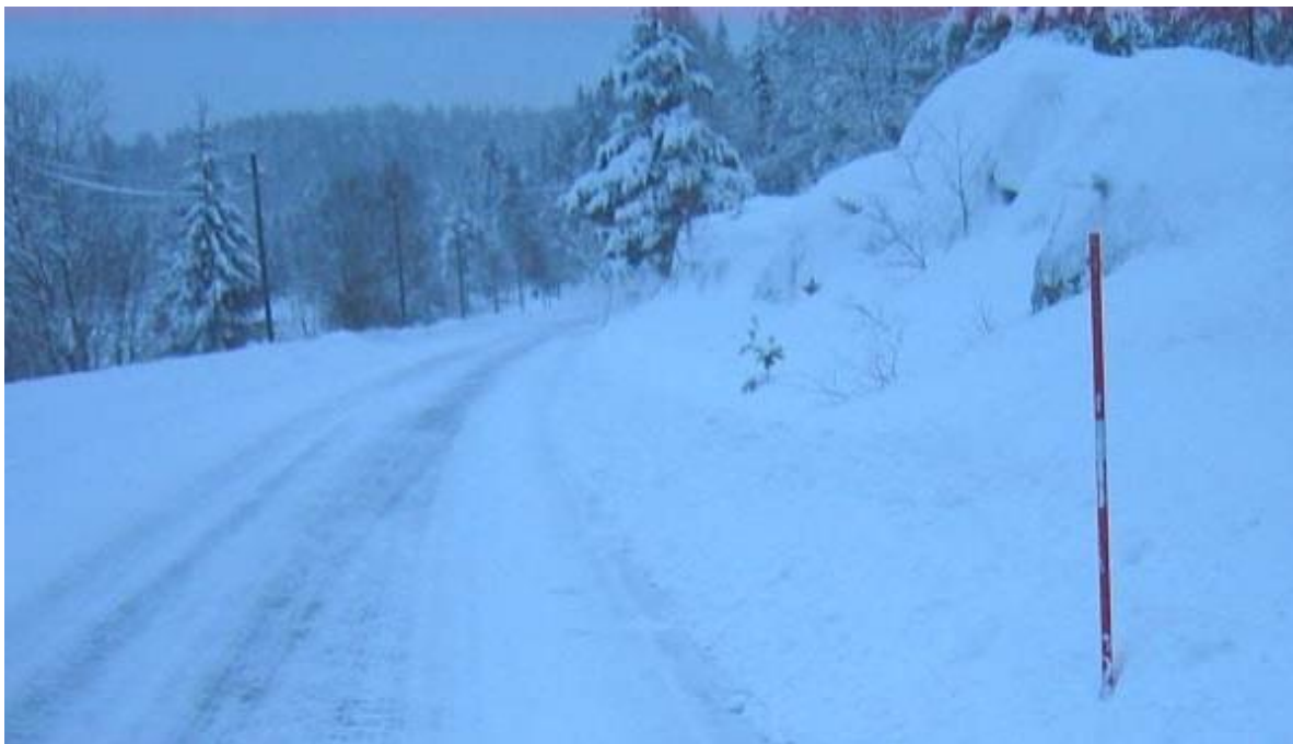
Figur 9-10 Brøytestikk angir ytterkant for brøyting (Foto: Statens vegvesen)
