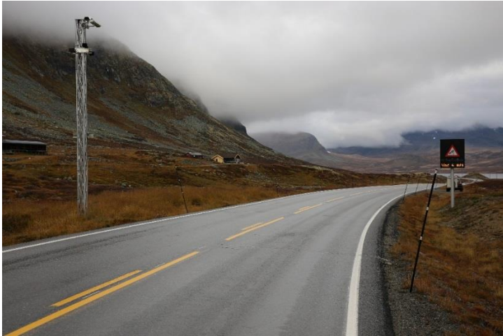
Figur 4-102 Værstasjon og vindtavle (Foto: Åsmund Espe)
