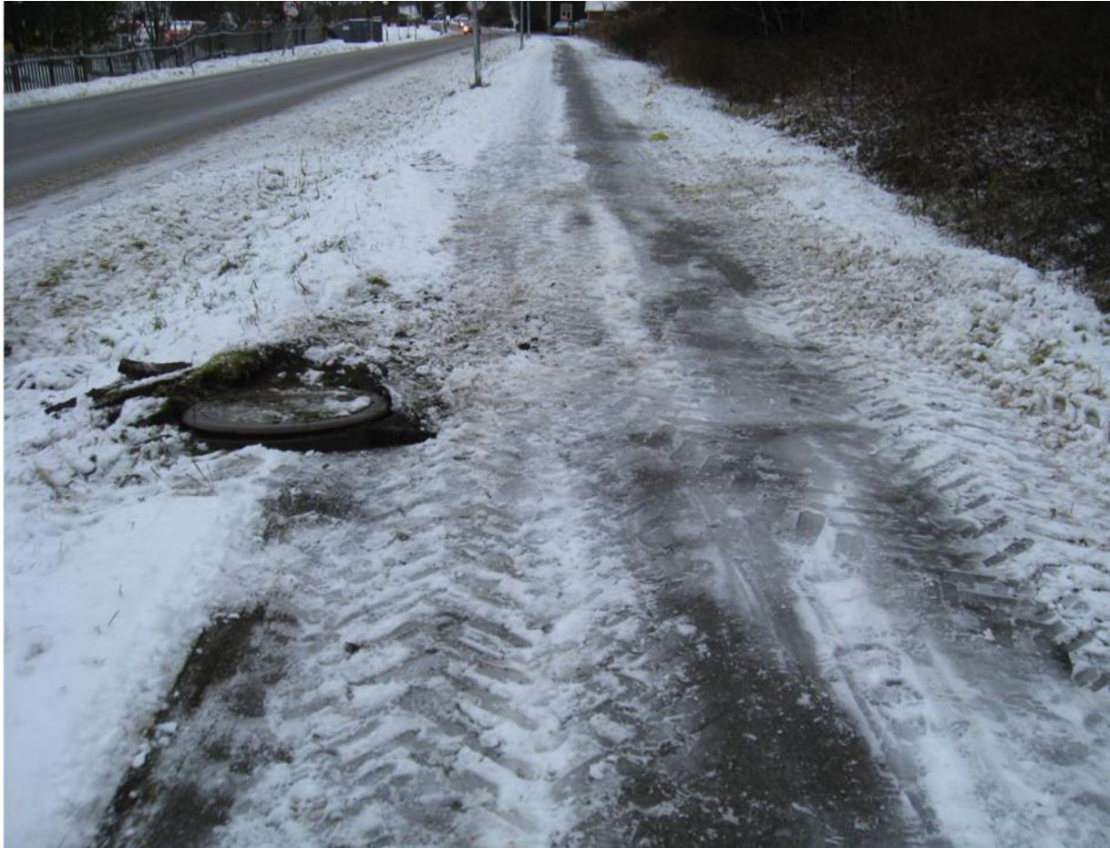
Figur 9-27 Skade på kummer/sluk (Foto: Øystein Larsen)
