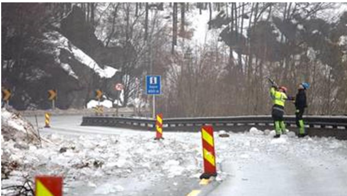
Figur 9-7 Nedtaking av is ved hjelp av skytter (Foto: fvn.no)
