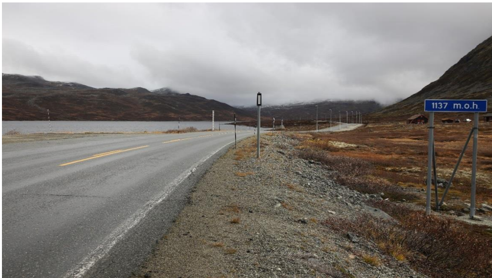
Figur 4-93 Eksempel på permanent brøytstikk (Foto: Åsmund Espe)
