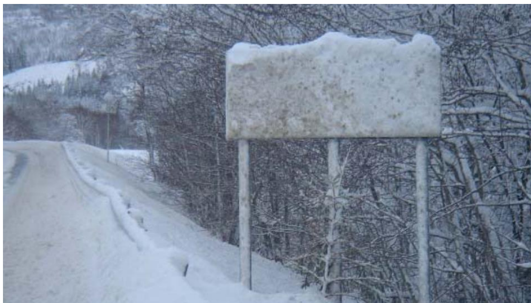
Figur 4-84 Nedsprutet trafikkskilt (Foto: SINTEF). Brøytefart over 40 km/t øker problemet med snø- og slapsesprut som dekker til skilt, og skader skilt, kantstolper, brøytestikk og andre installasjoner langs vegen.
