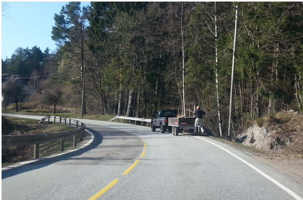
Figur 2-85 Bildet viser opptak av brøytestikker langs en riksveg med fartsgrense 80 km/t. Operatør er noe sparsomt utstyrt med vernetøy. Kjøretøyet er anonymt og kan forårsake farlige trafikksituasjoner. (Foto: Dag Øystein Løyning)
