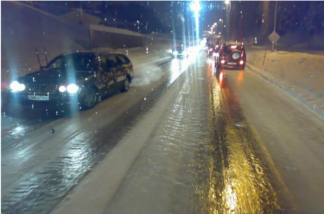
Figur 7-1 Veg med behov for sand (Foto: Terje Lindland)
