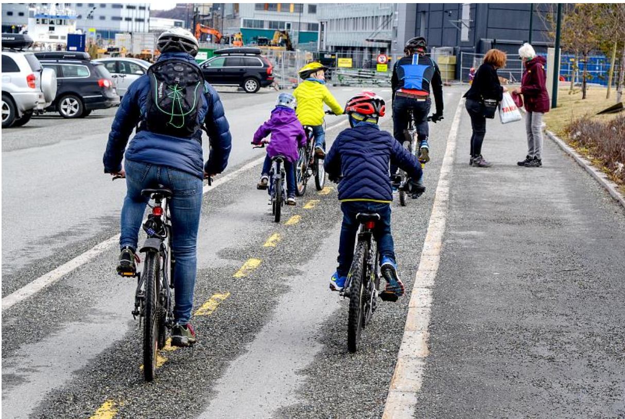
Figur 7-18 Eksempel på sykkelfelt som behøver renhold (Foto: Knut Opeide, Statens vegvesen)
