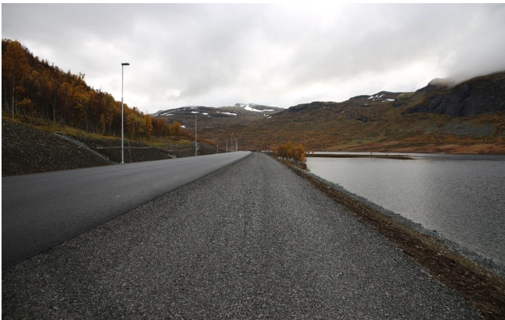
Figur 4-100 Opparbeidet fresegate på fylling på E16 Filefjell (Foto: Åsmund Espe, Statens vegvesen)
