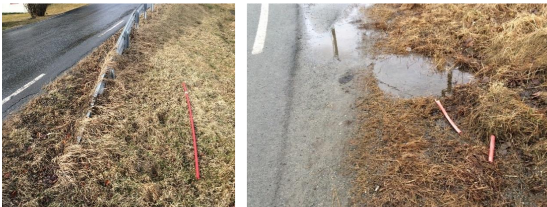
Figur 9-16 Rester av brøytestikk må også samles inn etter vinteren (Foto: Øystein Larsen)
