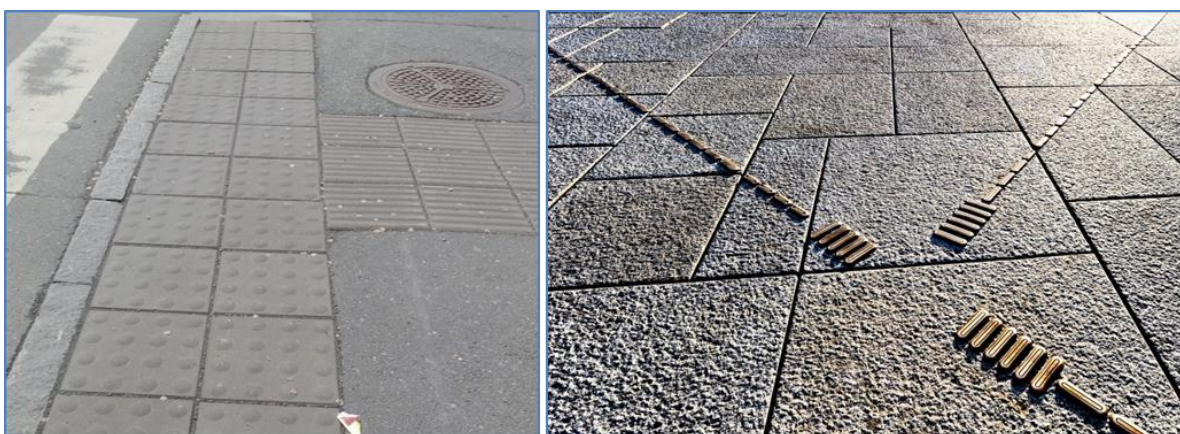
Figur 4-5 Indikatorer og taktile element må tas hensyn til (Foto: Mats Erik Vatne og Knut Opeide)
