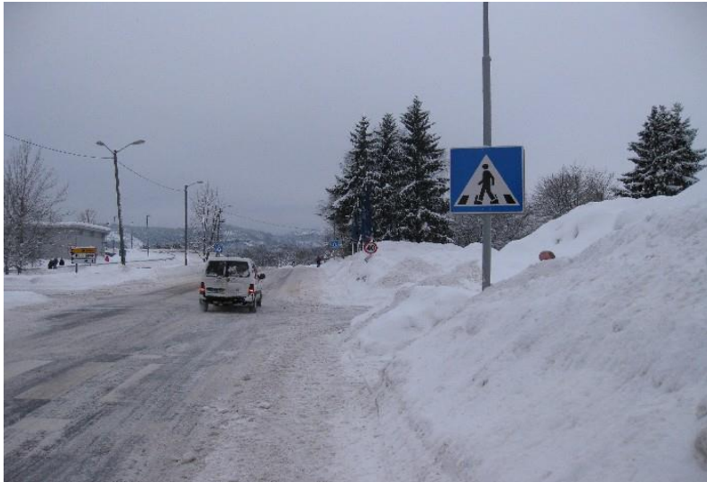
Figur 2-54 Manglende siktrydding til kryssingspunkt over hovedveg (Foto: Pål H. Paulsen)
