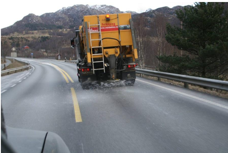
Figur 8-1 Salting på bar vegbane for å unngå rimfrost (Foto: Statens vegvesen)
