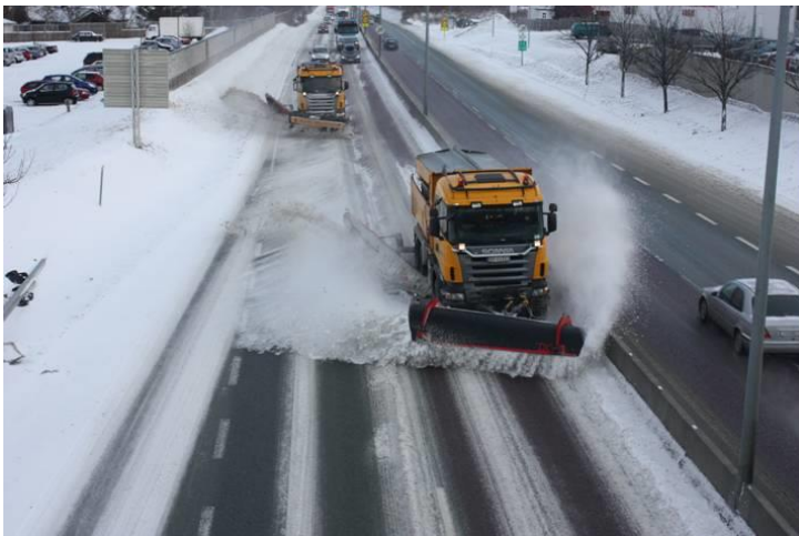
Figur 4-57 Eksempel på tandemkjøring (vær obs på snøsprut på motgående trafikk) (Foto: Statens vegvesen)
