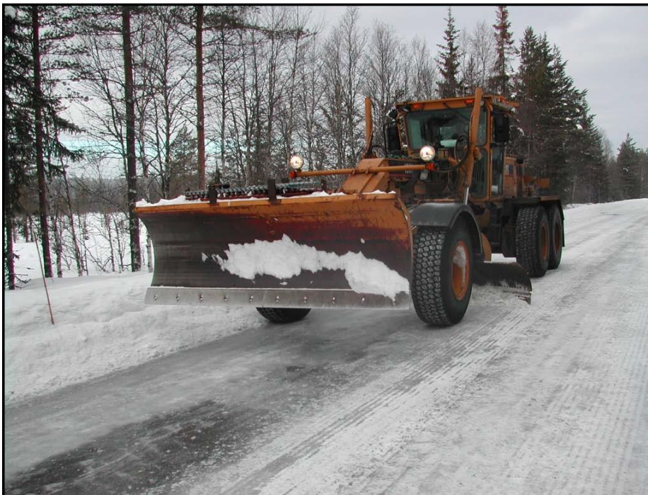
Figur 4-73 Veghøvel i arbeid
