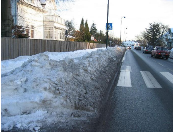
Figur 2-49 Manglende sikt og åpning i brøyttekanten
