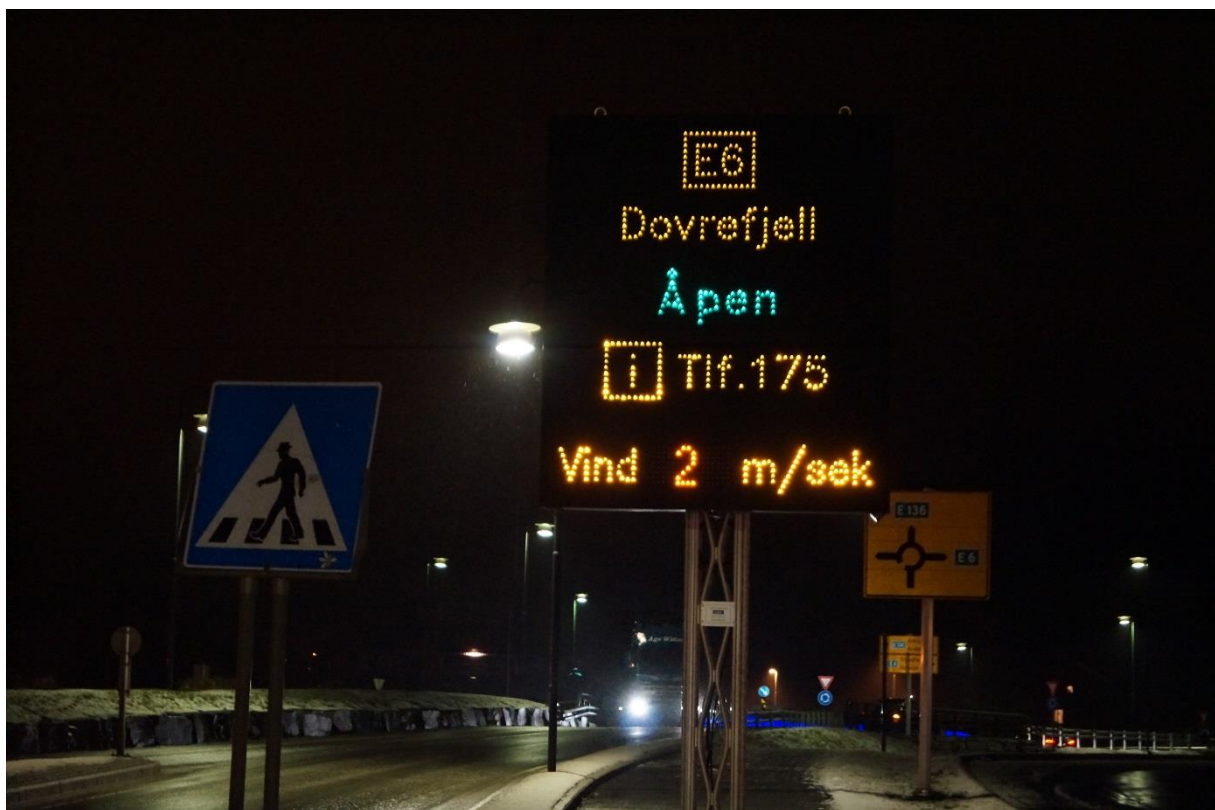
Figur 4-97 Vindvarslingsskilt plassert på E6 i Dombås før Dovrefjell (Foto: Bård Nonstad, Statens vegvesen)
