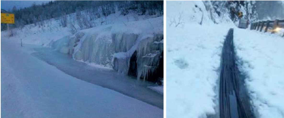
Figur 9-35 Problemer med is i grøfter og bruk av slanger for tining (Foto: Håkon Svendsen og Karl Olav Dahlberg, Mesta)
