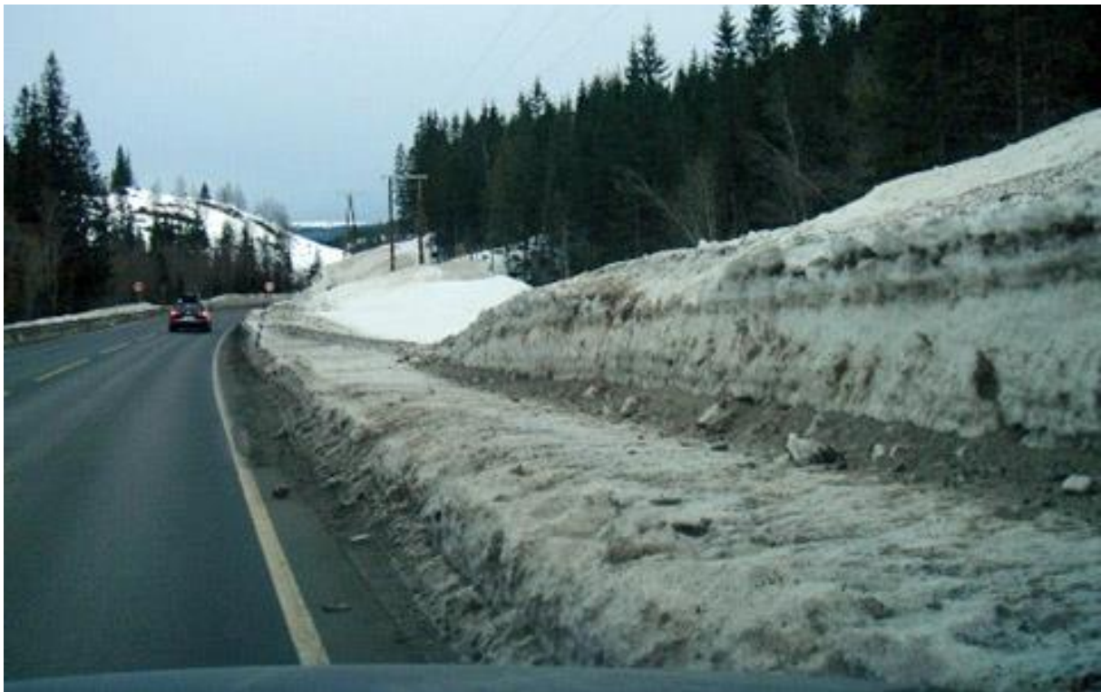
Figur 2-64 Fjerning av høye brøytekanter Foto: Statens vegvesen)
