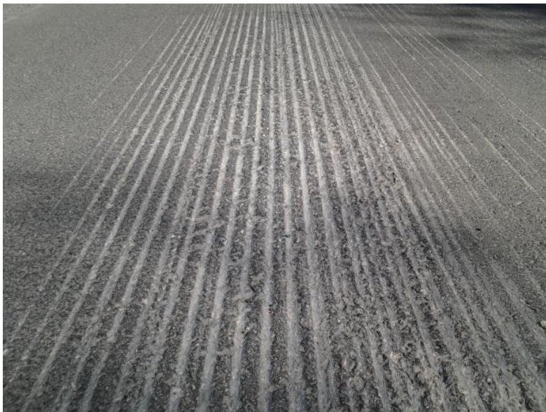
Figur 4-79 Dekkeskade grunnet uforsiktig høvling (Foto: Håkon Svendsen)
