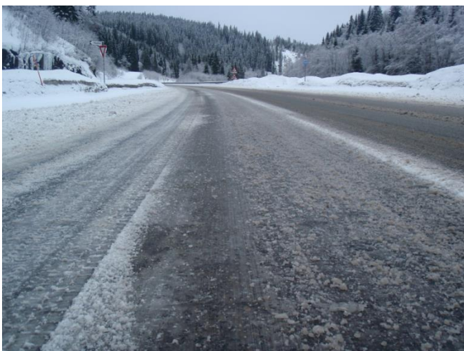
Figur 8-12 Dårlig brøyting vil gi dårlige kjøreforhold og høyt saltforbruk (Foto: Bård Nonstad, Statens vegvesen)
