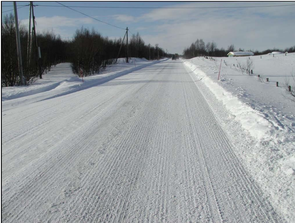
Figur 4-76 Snø- og isdekke etter høvling. Merk manglende utkast av ranke. Dette må gjøres for å hindre nedkjøring og dermed etablering av iskant på skulder. I tillegg bidrar manglende utkast til smalere veg.
