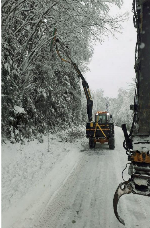
Figur 2-84 Maskinell vegetasjonsrydding etter snøfall. Traktor med løftearm påmontert sag. (Foto: Øyvind Svihus, Mesta)
