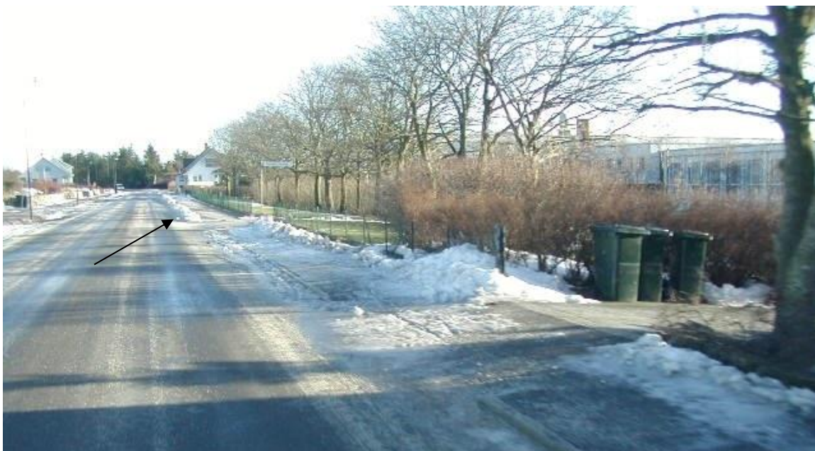
Figur 4-68 Lengst bort i bildet ser vi eksempel på riktig utførelse av brøyting av fortau
