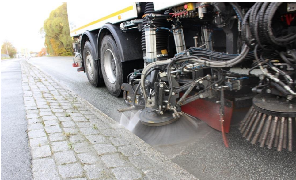
Figur 9-29 Spyling/vasking av vegbane – effektivt renhold inntil kantstein er utfordrende (Foto: Imre Aleksandersen)
