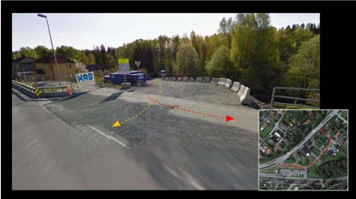
Figur 8: Hovedbildet over viser avkjørselen til et anleggsområde. I anleggsfasen ble gående/syklende langs hovedvegen ledet via denne anleggsavkjørselen og en bakenforliggende boliggate (lite bilde). En fotgjenger (rød pil) ble påkjørt av en lastebil (gul pil) da vedkommende var i ferd med å krysse anleggsavkjørselen. Det var ingen separering mellom gående/syklende og anleggstrafikken og anleggsavkjørselen hadde en uheldig utforming.
