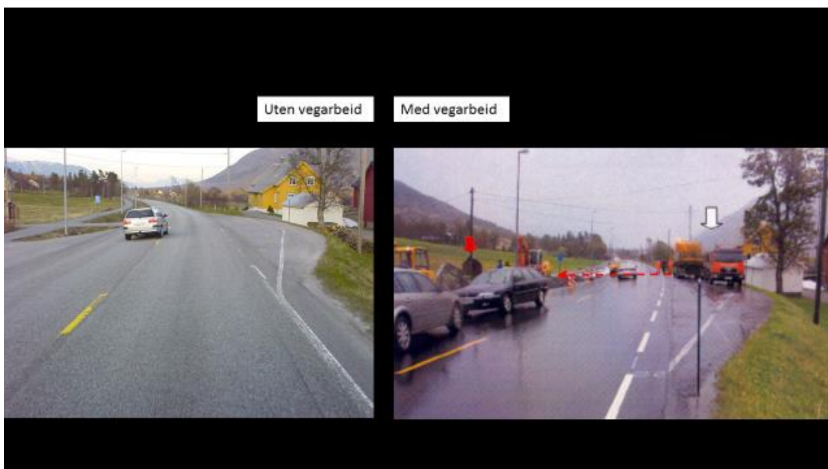
Figur 16: Bildet viser den samme vegstrekningen, før og under vegarbeid på stedet. Mens det pågikk vegarbeid ble en fotgjenger påkjørt av to passerende personbiler da vedkommende var i ferd med å krysse hovedvegen (rød pil). Hildermarkeringer og anleggsmaskiner bidro sannsynligvis til at det var vanskelig å oppdage kryssende fotgjengere/syklister. Fartsgrensen var 80 km/t.
