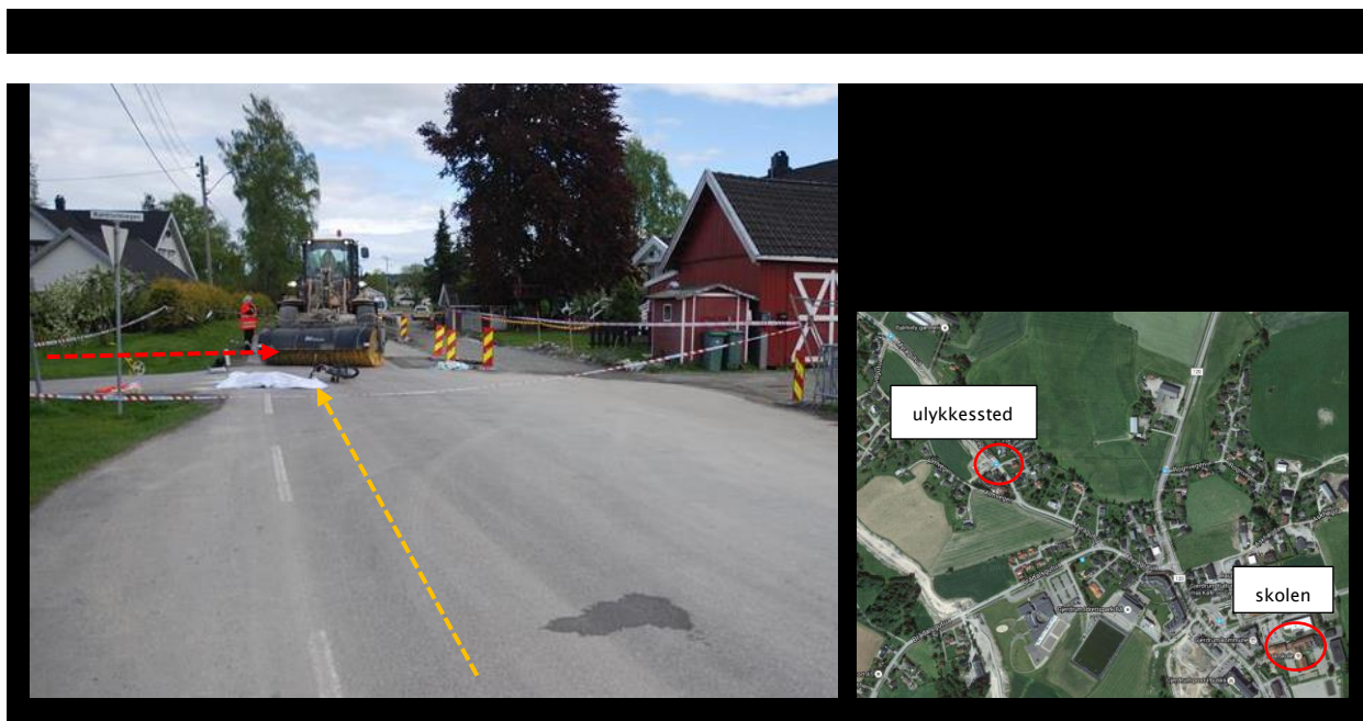
Figur 17: Bildet viser et kryssområde hvor en gutt på sykkel (rød pil) ble påkjørt av en ryggende feiemaskin (gul pil). Feiemaskin var i ferd med å rydde gata siden det pågående vegarbeidet (bygging av ny gs-veg) hadde medført mye grus og søl i vegbanen. Det nye anlegget ville sørge for sammenhengende gs-veg herfra og fram til barneskolen. Ulykken skjedde kl 15.00 i et område hvor det ferdes mange skolebarn.
