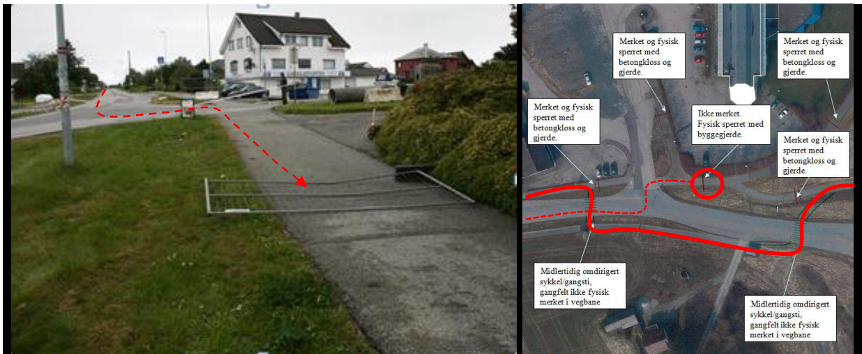
Figur 12: Bildet til venstre viser et sperregjerde som ble påkjørt av en syklist (rød pil). Sperregjerdet stod på tvers av gs-vegen, men var dårlig synlig i mørket og i regnvær/tåke. Bildet til høyre viser plasseringen av det sperregjerdet syklisten kjørte på (rød ring) og hvilke tiltak som var etablert for å lede gående og syklende utenom anleggsområdet. Rød linje viser hvordan man hadde planlagt at gs-trafikken skulle bevege seg forbi anleggsområdet. Syklisten kom i dette tilfellet langs den stipla røde linja.
