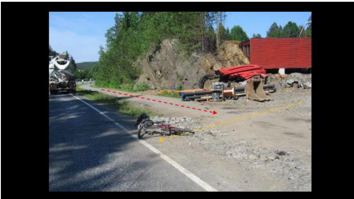
Figur 9: Bildet viser en anleggsavkjørsel som krysser en gs-veg. En gutt som kom syklende (rød pil) ble påkjørt av en lastebil på veg ut av anleggsavkjørselen. Forholdene på stedet gjorde det umulig å plassere kjøretøyet vinkelrett og syklisten befant seg derfor innenfor kjøretøyenes blindsoner. Lagret materiell i kryssområdet forverret siktforholdene mot gs-vegen.
