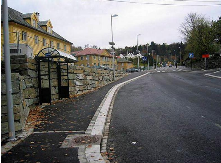
Figur 6.25: Foto av busslomme med kantstein og kombinert ristluk på fortau og kjeftsluk i tilknytning til kantsteinen. Nestun, Bergen (Foto: T. Engevik).
