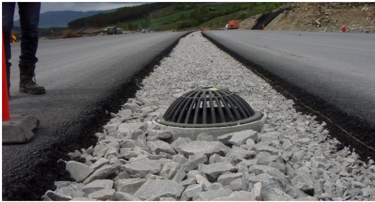
Figur 6.7: Eksempel på bygging av firefelts veg med grøft og lukket drenering i midtdeleeren, E6 Hundorp. (Foto: H. Norem).
