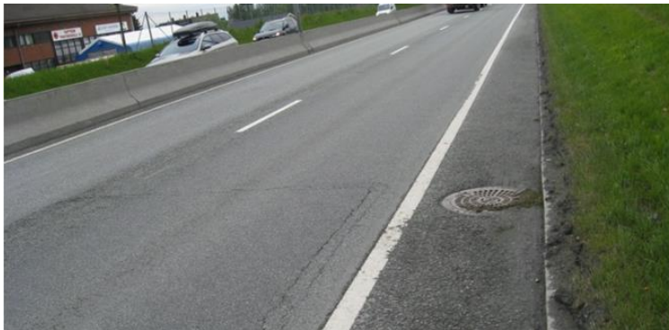
Figur 6.126: Eksempel på ristluk i tiknytning til hovedveg. (Foto: H.Norem).
