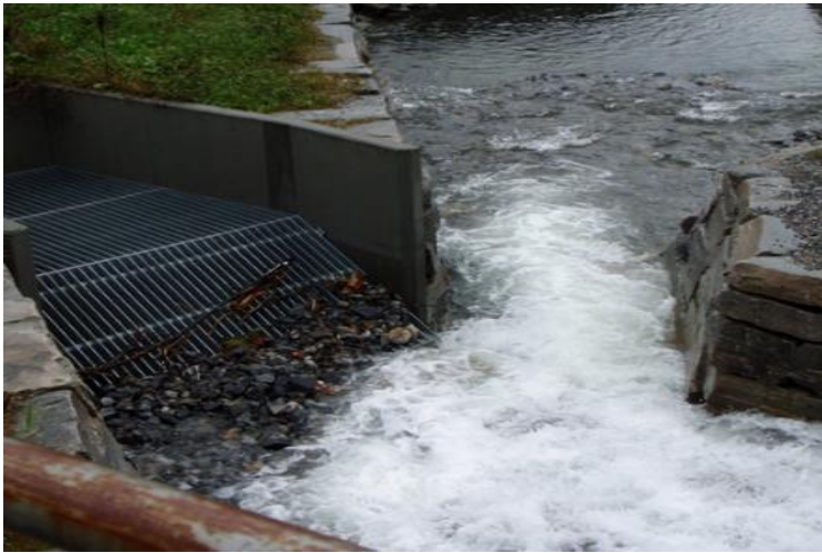
Figur 2.16: Eksempel på vannveg dimensjonert for både normalsituasjonen og flomsituasjonen, Skytjeåa, Ørsta. (Foto: H. Norem).
