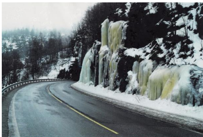
Figur 2.7: Iskjøving i fjellskjæring, Rv. 7, Tokagjelet. (Foto: H. Norem).
