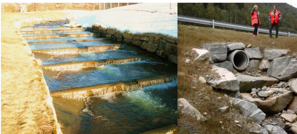
Figur 4.14: Eksempler på renner bygget med trappetrinn. Det venstre er fra Ilabekken i Trondheim og bygget i forbindelse med Nordre avlastningsveg. Det høyre er fra E39 ved Batnfjordsøra. (Foto: H. Norem).
