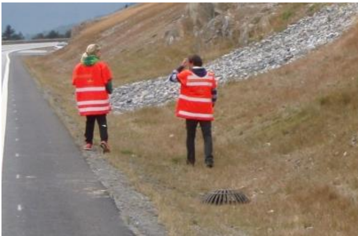
Figur 6.23: Eksempel på kuppelrist for å fange opp vann fra grunne sidegrøfter, E39, Gjemnes, Møre og Romsdal. (Foto: Harald Norem).
