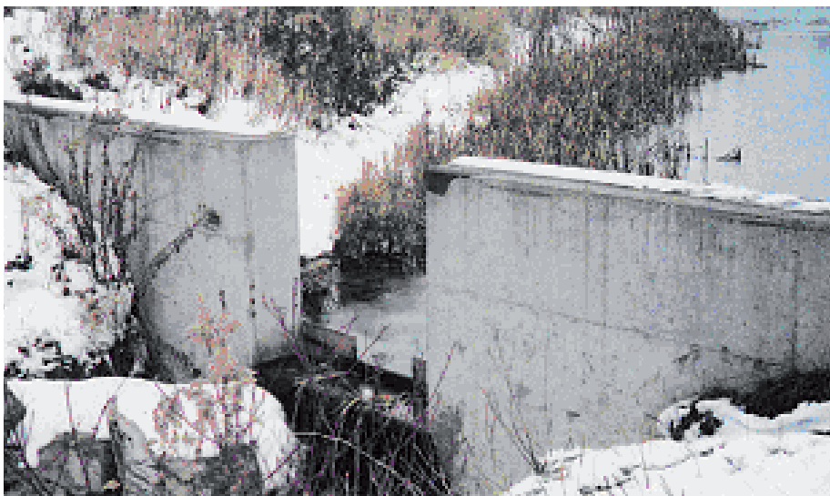
Figur 4.27: Eksempel på utforming av utløp i overvannsdammer. Vannføringen ut er begrenset ved lav vannstand og dammene har et bredt overløp dersom disse blir fylt helt opp. (Foto: S. Endresen 2006).
