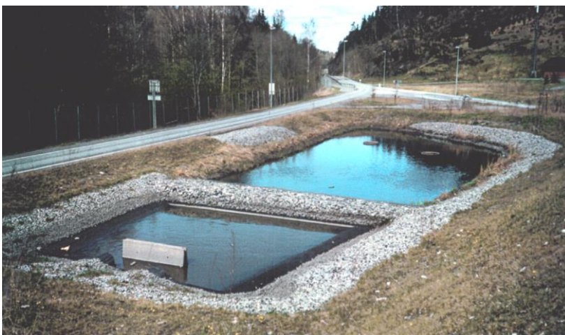
Figur 4.29: Overvannsdam som rensiltak. Dammen er bygget med kamre, og i forbindelse med innløpet er det bygget en betongvegg som energidreper. E6 Hvattum (Foto: S. Endresen 2006).
