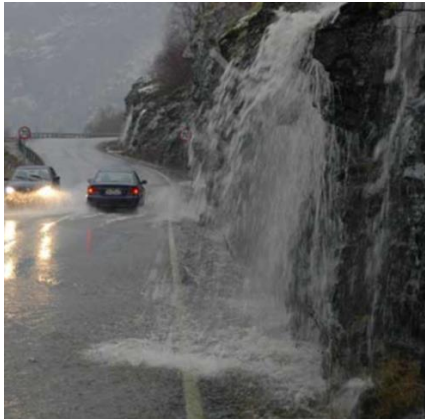
Figur 4.30: Bekker som føres fram til en høy bergskjæring kan føre til vannsprut og nedfall av grus og stein på vegen i flomperioder. Venstre bilde: Rv. 706 Trolla, Sør-Trøndelag. (Foto: H. Norem). Høyre bilde: Rv. 13 Sandvinvatnet, Hordaland. (Foto: L Øyre).
