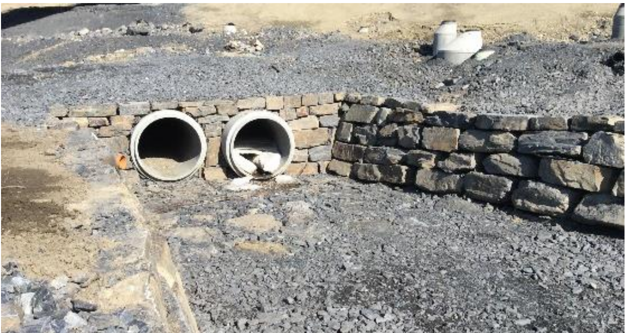
Figur 4.10: Isdannelse og blokkering av is i stikkrenner kan bli et alvorlig problem. Tendensen kan reduseres ved å skjerme innløp og utløp, eventuelt montere en ekstra stikkrenne som ligger tørr om vinteren, E6-prosjektet, Hundorp. (Foto: H. Norem).
