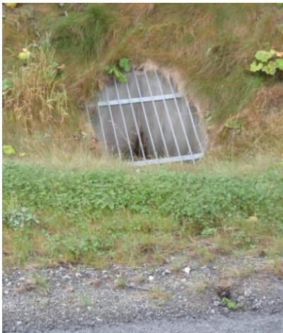
Figur 6.24: Eksempel på rist i skjæringssskråning. Foto: H. Norem. (Illustrasjon; Basal produktkatalog).
