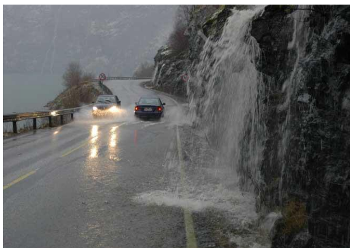
Figur 2.6: Vann fra bekk som renner over fjellskjæring, Fv. 706 ved Trolla. (Foto: H. Norem).
