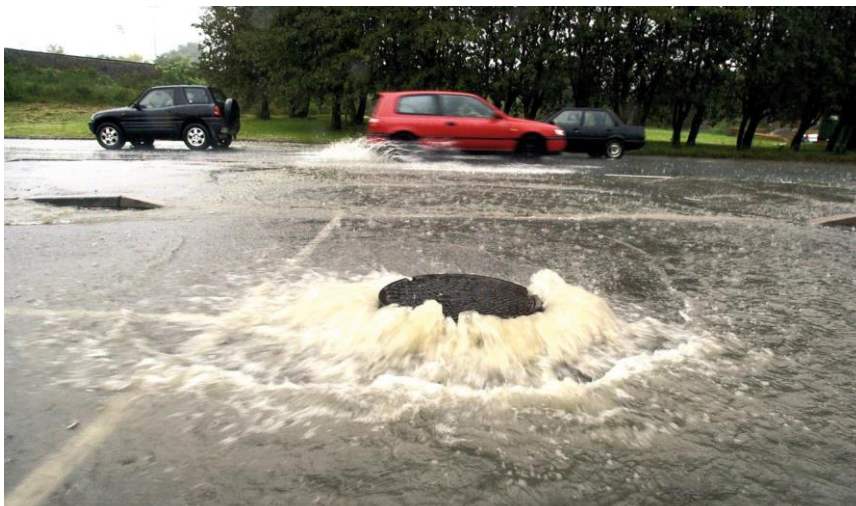
Figur 6.33: Ved underdimensjonerte overvannsledninger vil vannet flomme ut av kummene. (Foto: Terje Reiersen, Basal).
