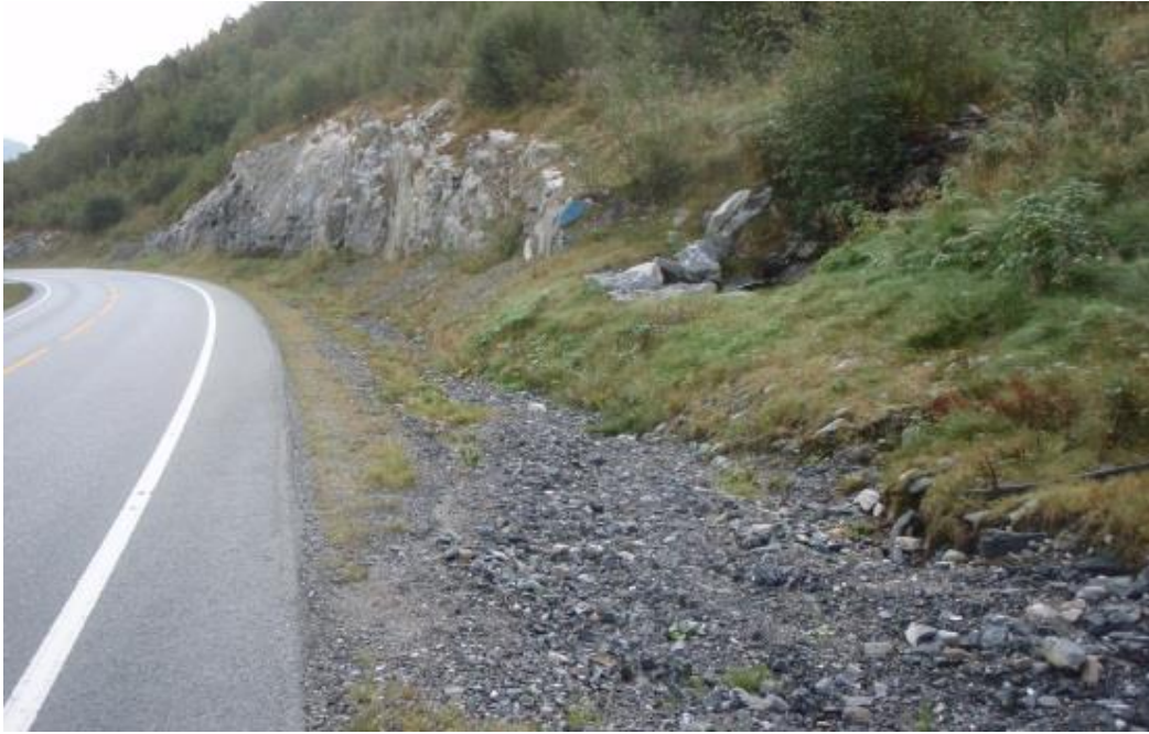
Figur 6.21: Eksempel på tilbakefylling i bergskjæring, E39 Rodalen. (Foto: H. Norem).
