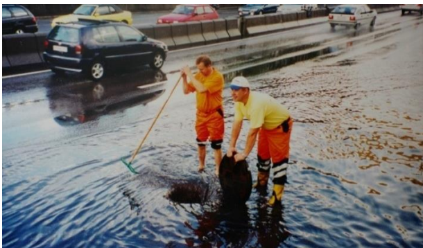
Figur 2.4: En hyppig årsak til overvann på veg er rister som har for dårlig kapasitet eller er tettet av sedimenter og drivgods. (Foto: C. Ræstad).
