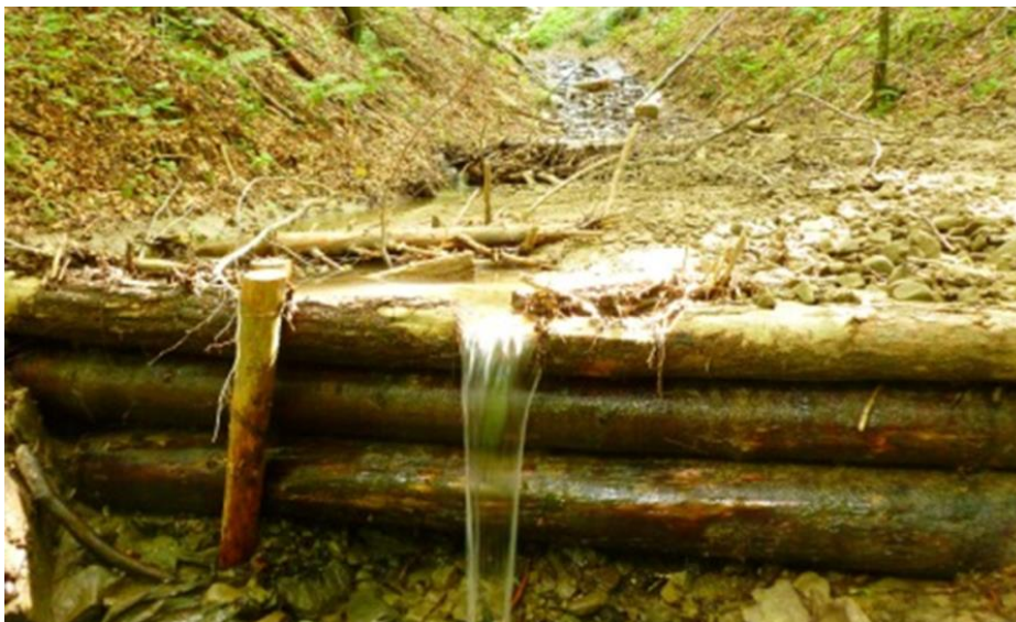
Figur 4.18: Eksempel på terskel bygget av trestokker. Etter hvert som dammen fylles opp av sedimenter er det spesielt dammens evne til å fange opp sedimenter og energireducerende effekt som er viktig. (Foto B. Braskerud).
