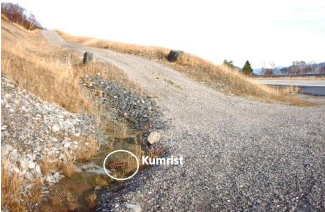
Figur 4.34: Driftsveger med åpen drenering ovenfor skjæringene fungerer som effektive terrenggrøfter, og dreneringstiltak nedstrøms må dimensjoneres for å ta unna vannet. E39 nær Gjemnes. (Foto: H Norem).
