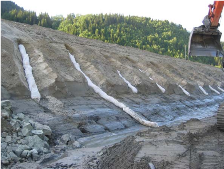
Figur 115: Utlegging av dreneringspølser, E6 Melhus
