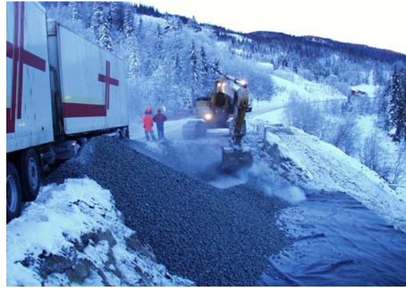
Figur 74: Utlegging av skumglass, rv 17
