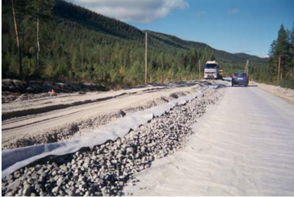
Figur 46: Utlegging av overbygning, rv 219
