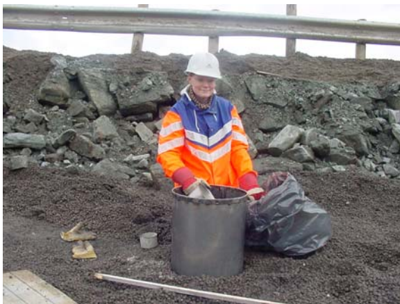
Figur 5: Utgraving av masse fra røret
