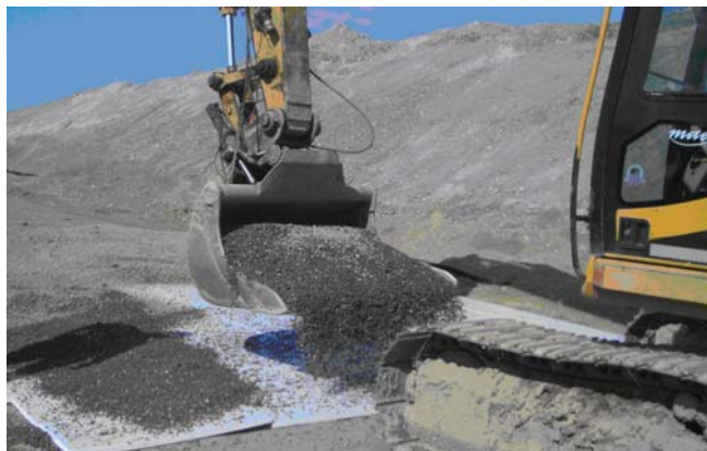
Figur 5 – Installasjon av XPS isolasjonsplater
