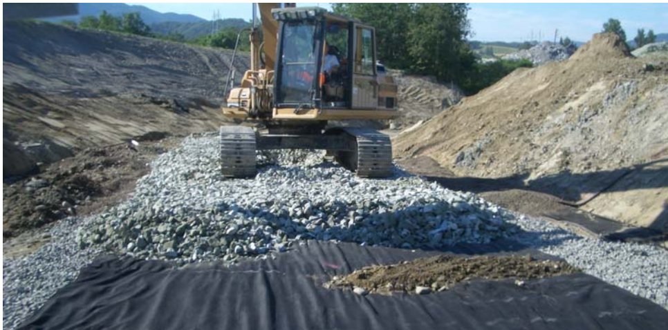
Figur 7 – Legging av separasjonsduk og tildekking med knust stein
