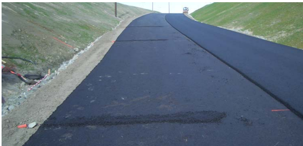
Figur 8 – Temperaturfølere lagt mellom asfaltlagene
