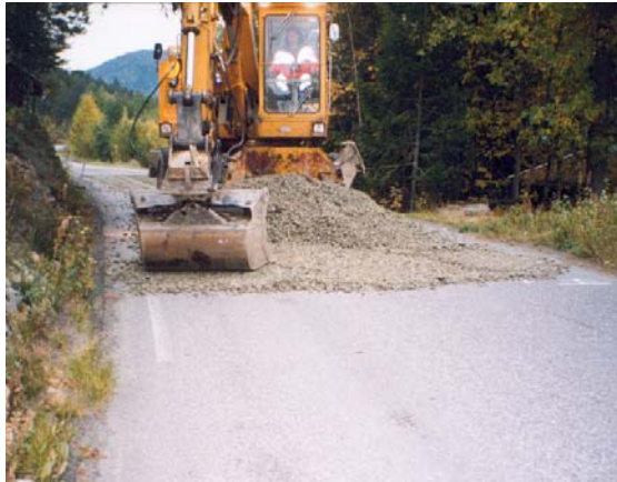
Figur 28: Utlekking av skumglass, fv 133
