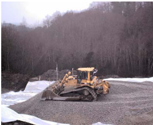
Figur 85: Utlegging av skumglassfylling, rv 120
