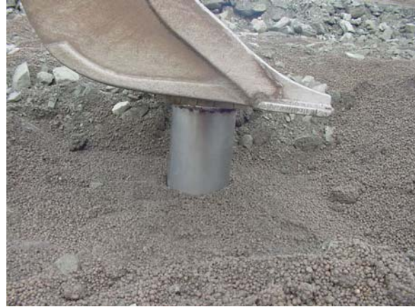
Figur 4: Nedpressing av prøvetakingsrør
