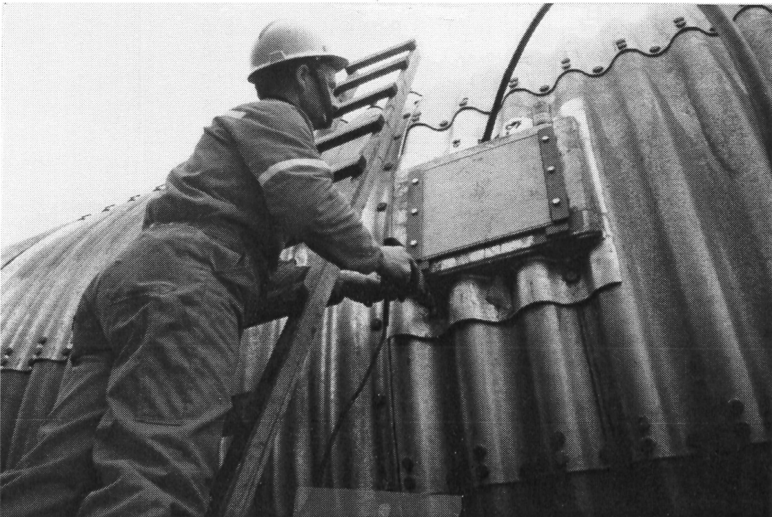
Figur 9. Bilde av montering av gløtzcelle med festebrakett i stålrør.
