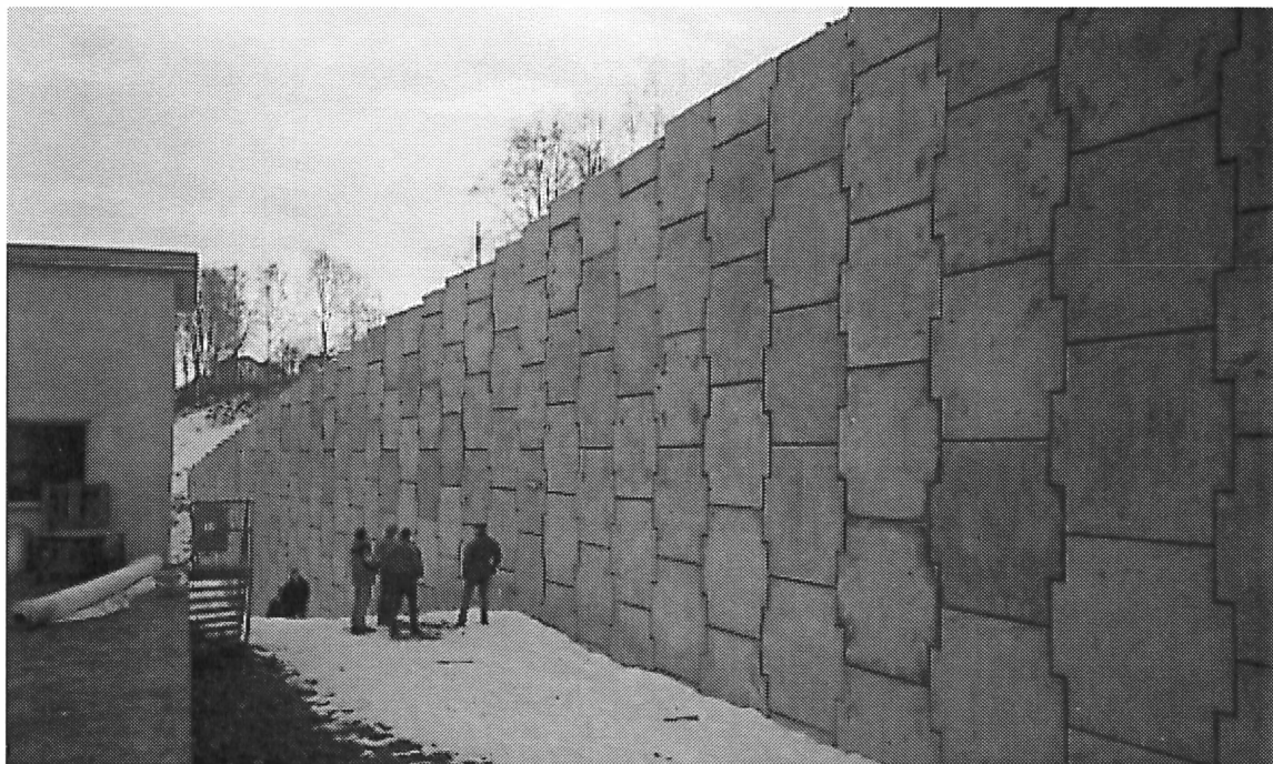
Figur 13. Bilde av ferdig konstruksjon.
