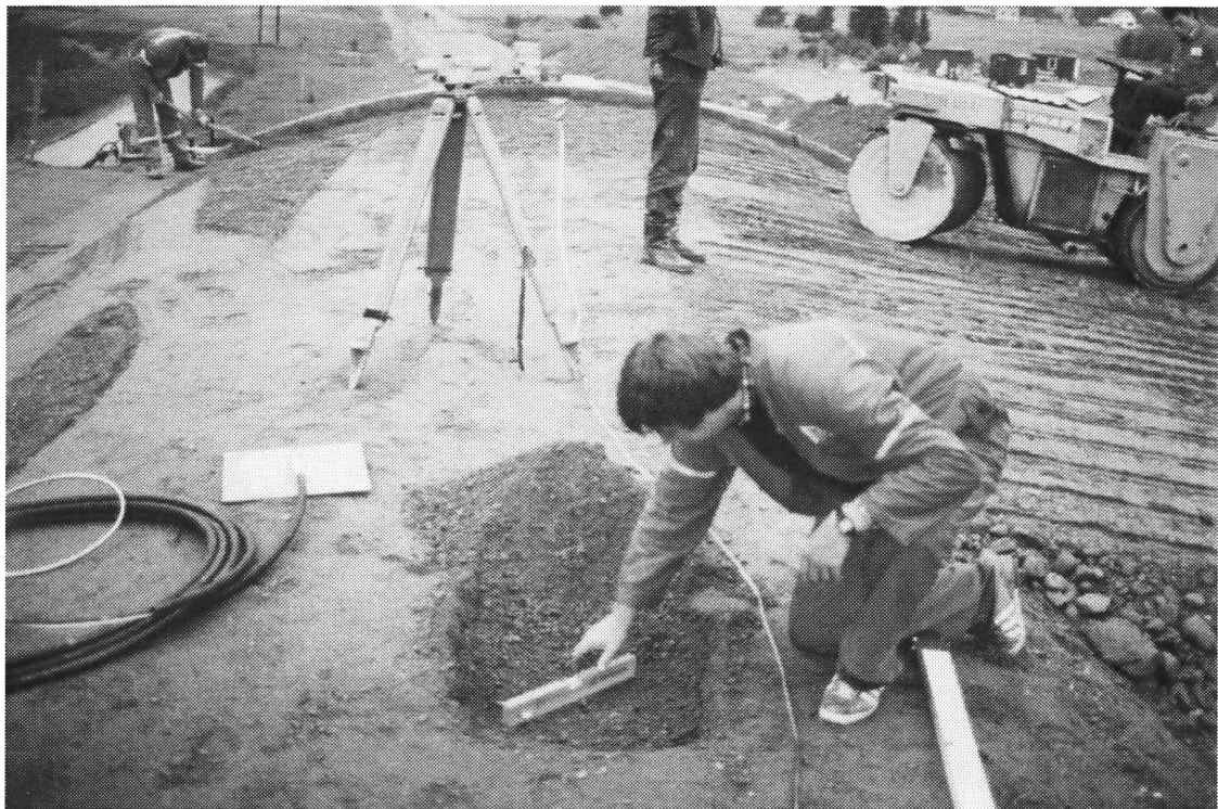
Figur 11. Bilde av montering av gløtzcelle i løsmasse over tak på stålrør
