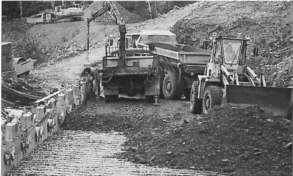
Figur 12. Bilde av montering av betongelementer og utlegging av tilbakefylling.
