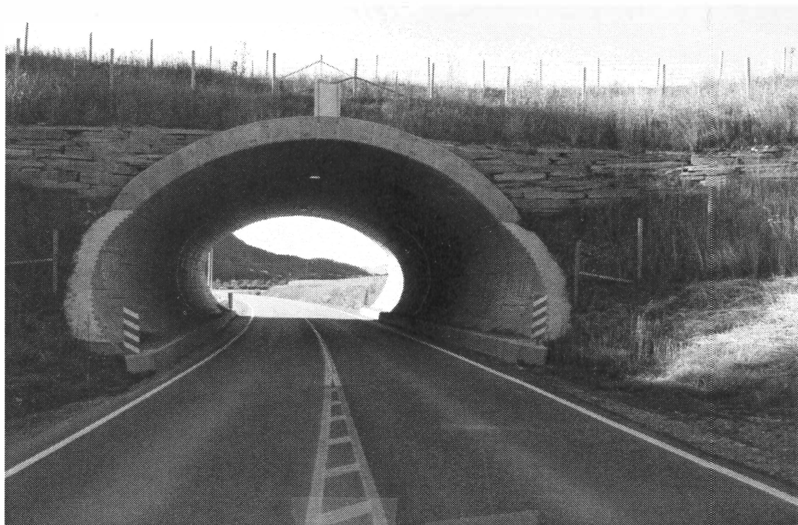
Figur 12. Bilde av ferdig konstruksjon
