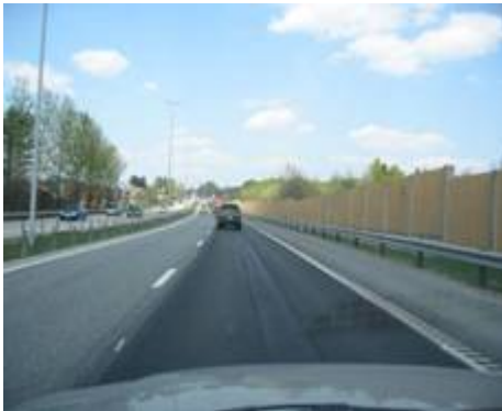
Figur 7.1. Ved å legge asfalt kun i sporene kan asfaltforbruket mer enn halveres (E6 mot Gardermoen, Romerike, asfaltet 2006)
