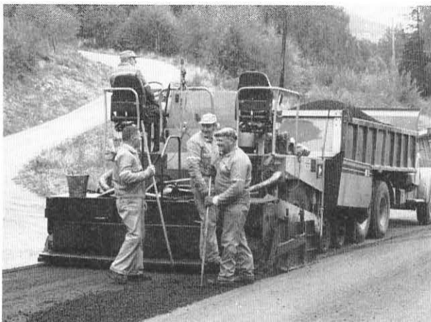
Det er fornyet faste dekker på 132 km riksveger i 1986.
