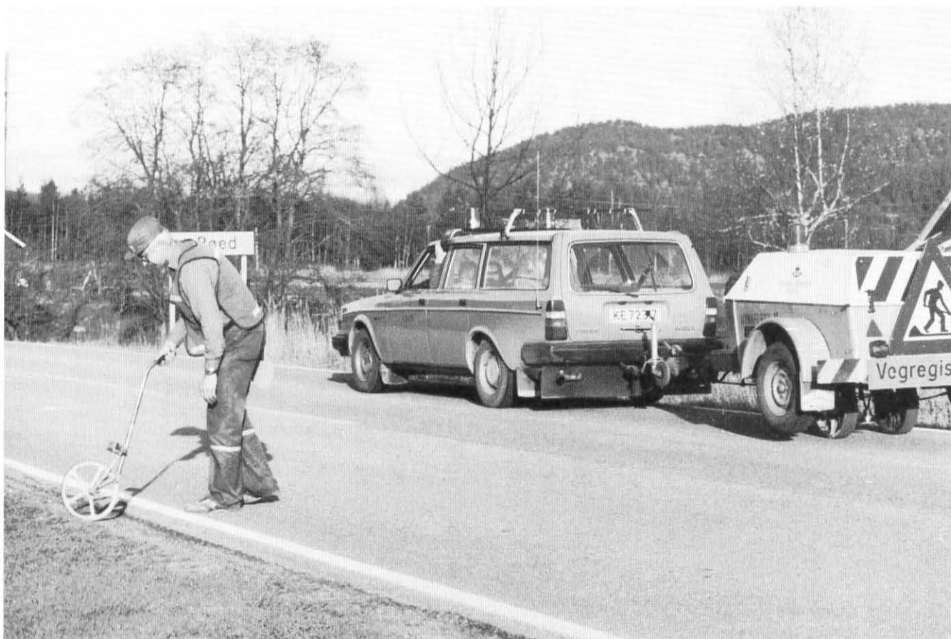
Ajourhold av bæreevne registret. Det ble målt 144 km riks- og fylkesveger i 1986.
