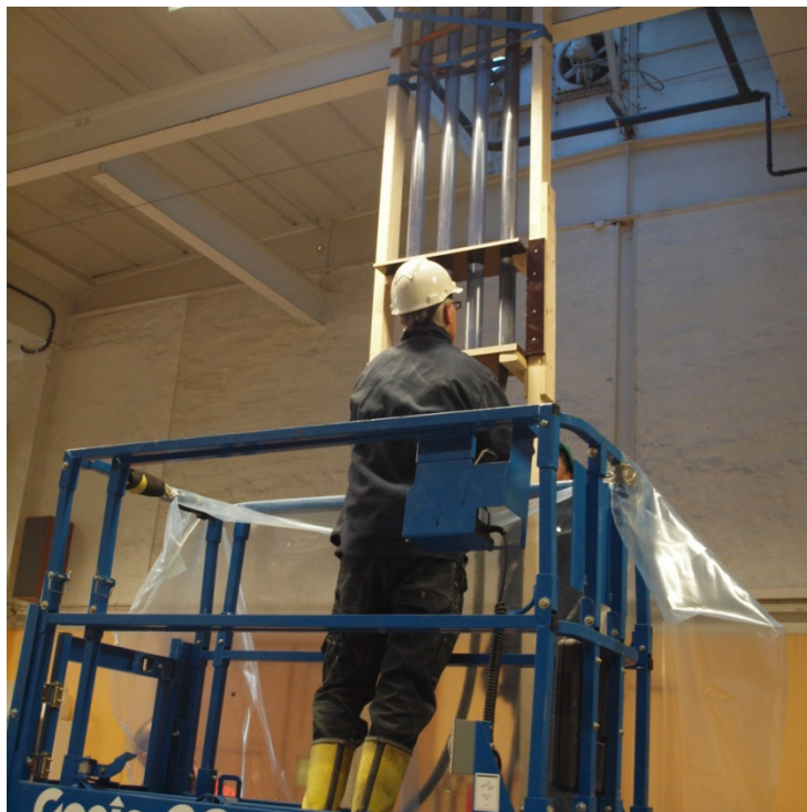
Foto 9 Gysing av rør før montering av kamstålbolt
