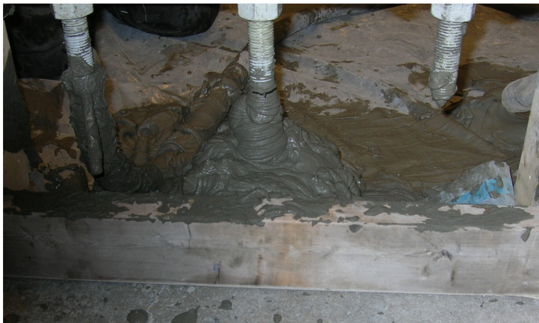
Foto 4 Mørtelen rant ut igjen fra plastrøret for ett 5 m langt vertikalt rør med rørbolt
