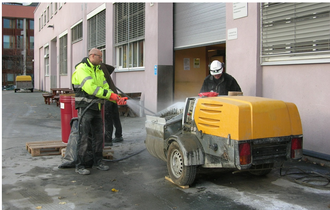
Foto 1 Putzmeister SP11 Beliso BBR blandemaskin og pumpe
