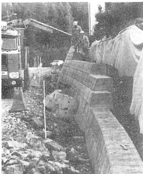
Trøndermur monteres ved riksveg 415
