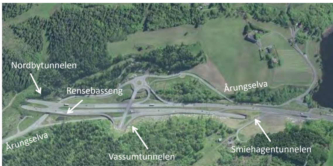
Figur 1. Oversiktsbilde over E6 (Frogn kommune, Akershus) med sedimenteringsbasseng og omkringliggende tunneler. Sedimenteringsbassenget mottar vaskevann fra tre tunneler (Nordby-, Vassum- og Smiehagentunnelen) samt avrenningsvann fra vegarealet i mellom tunnelene. Renset vaske- og avrenningsvann drenerer ut i Årungselsva. Innsjøen Årungen ligger til høyre i bildet.
