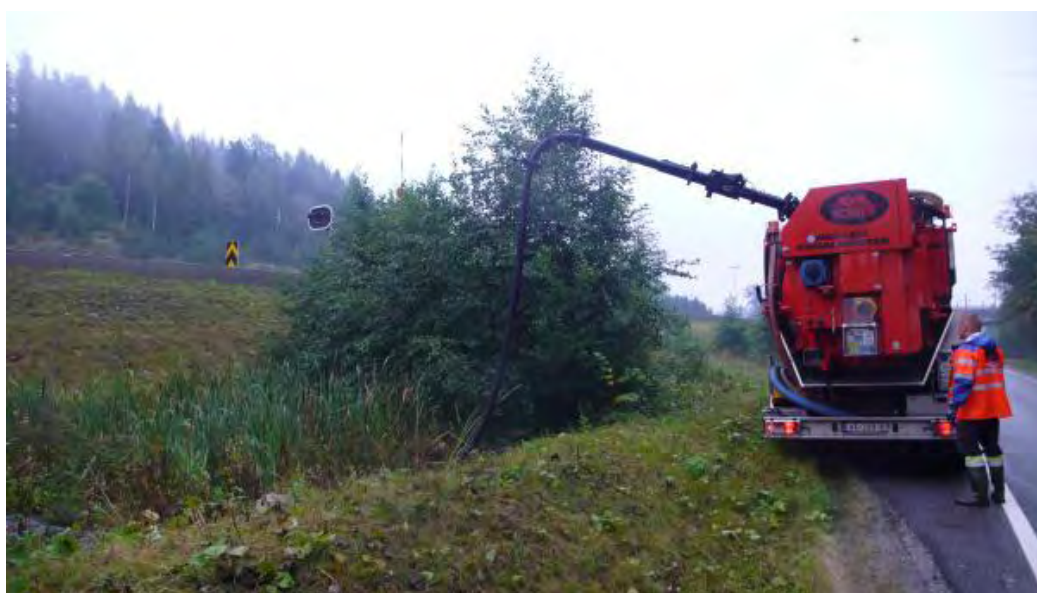
Figur 3. Det ble først forsøkt å tømme sedimenteringsbassenget for sediment ved bruk av slamsugebil. Imidlertid var slammet for kompakt og hardpakket slik at det ble besluttet å bruke gravemaskin. (Foto: Kjersti Wike Kronvall).
