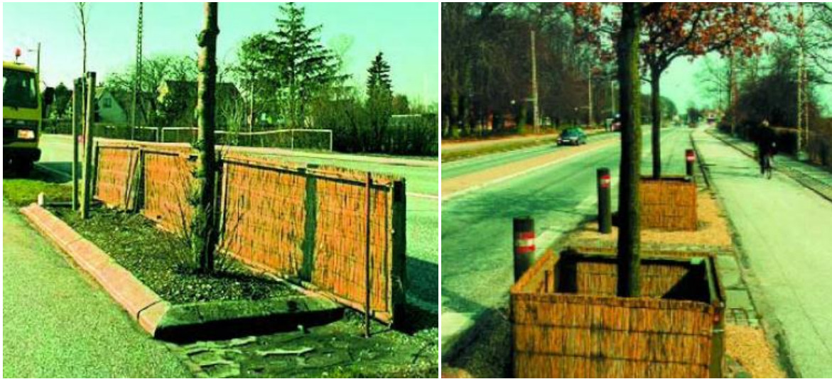
Figur 3.9 Beskyttelse av beplantning langs veg
