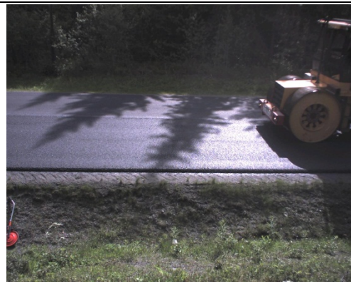
Kompaktering: 5. passering Statisk vals Posisjon C
