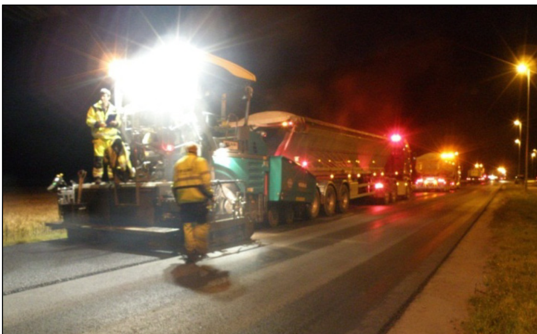
Figur 20: Lastebiler i kø foran utlegger på Orkanger
