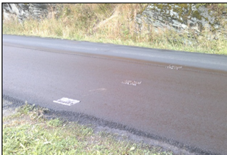
Figur 8: Måling av limmengde
