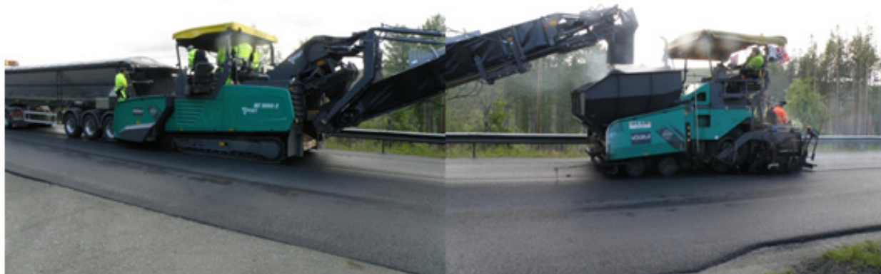
Figur 16: Bruk av feeder på Oppdal-prosjektet
