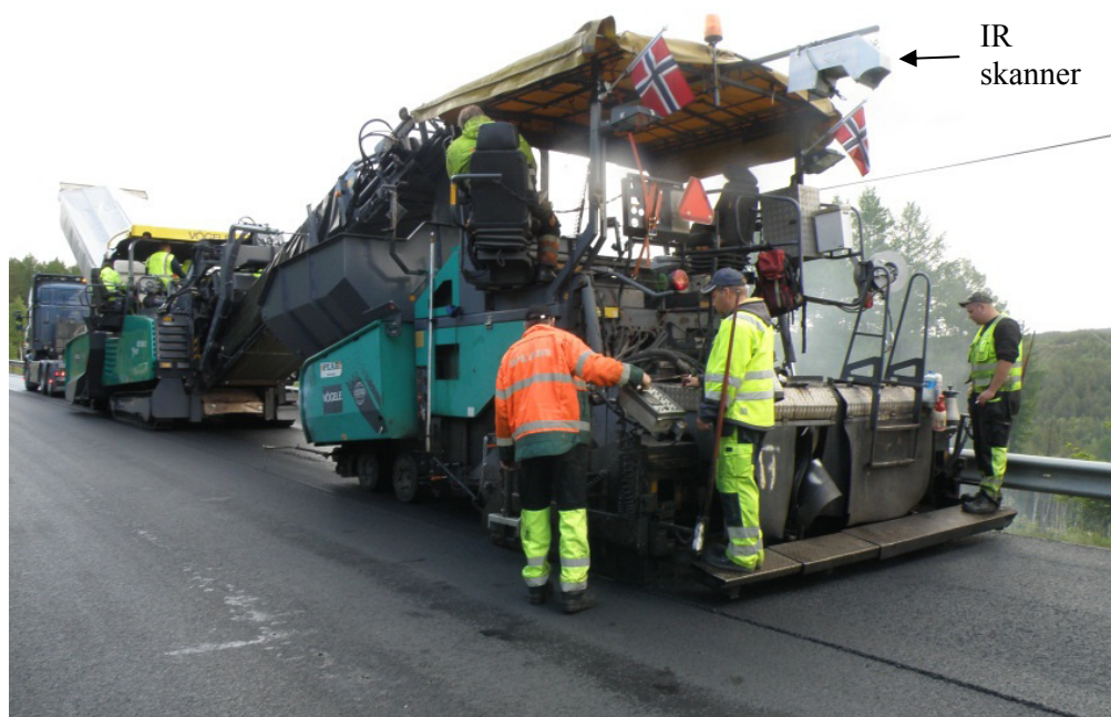
Figur 17: Bruk av IR-skanning under asfaltering på Oppdal
