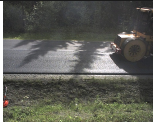
Kompaktering: 1. passering, Statisk vals Posisjon C.
