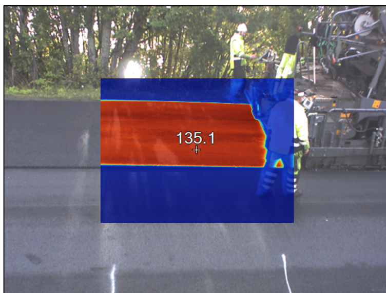
Figur 4: Dokumentasjon av temperatur ved bruk av varmekamera
