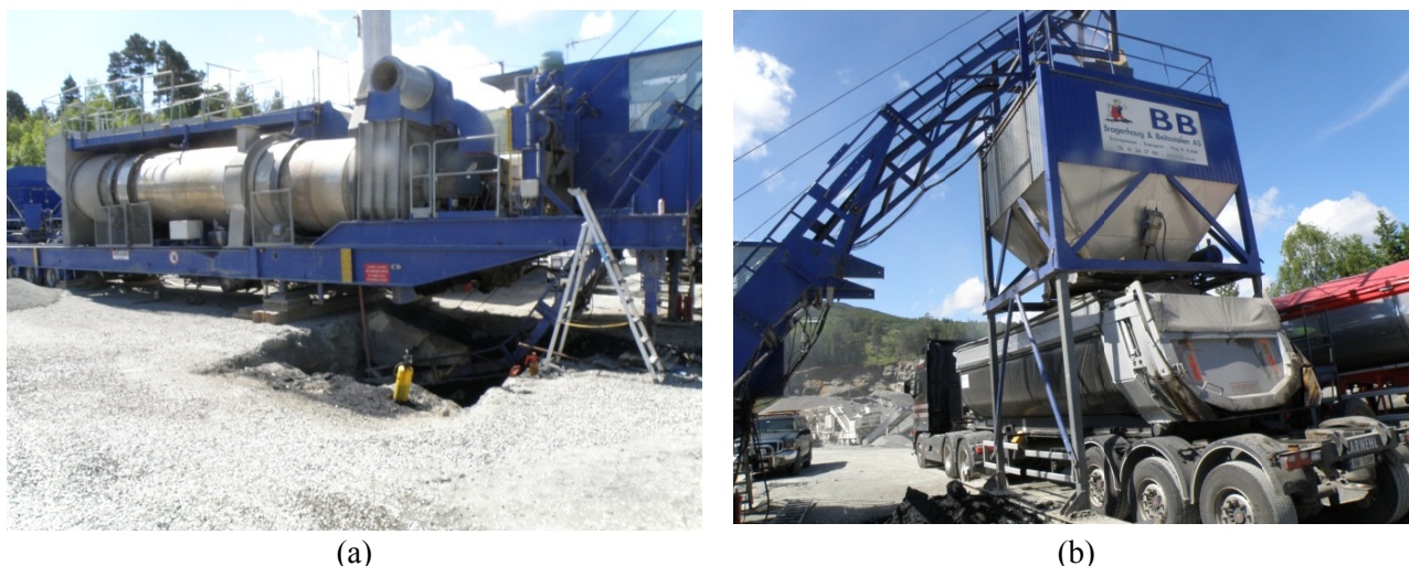
Figur 14: Asfaltproduksjon på Oppdal (a) Flyttbart asfaltverk og (b) Lasting av asfaltmasse i lastebil
