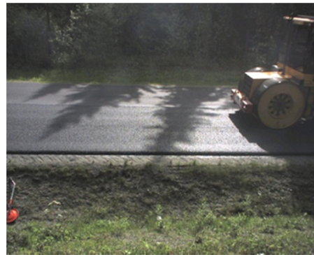
Statisk vals. Kompaktering: 1. passering. Posisjon C.
