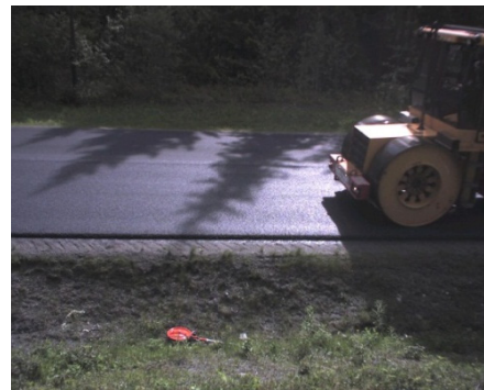
Statisk vals. Kompaktering nr. 11 (den siste) Posisjon A
