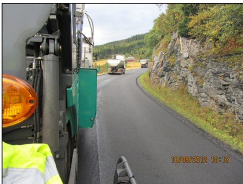
Figur 23: Lastebiler i under asfaltering på Melhus
