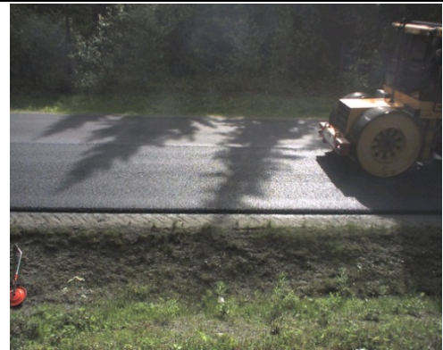
Kompaktering: 1. passering, Statisk vals Posisjon C.
