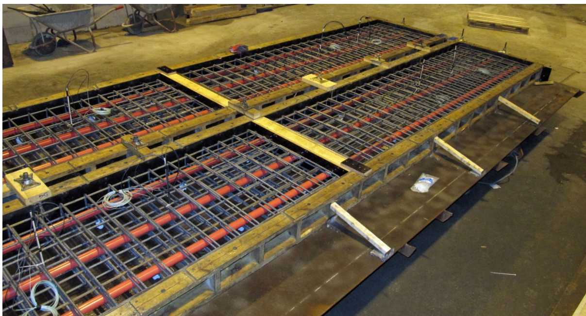
Figur 13 Kulvertelementer (K20) klare til støp
