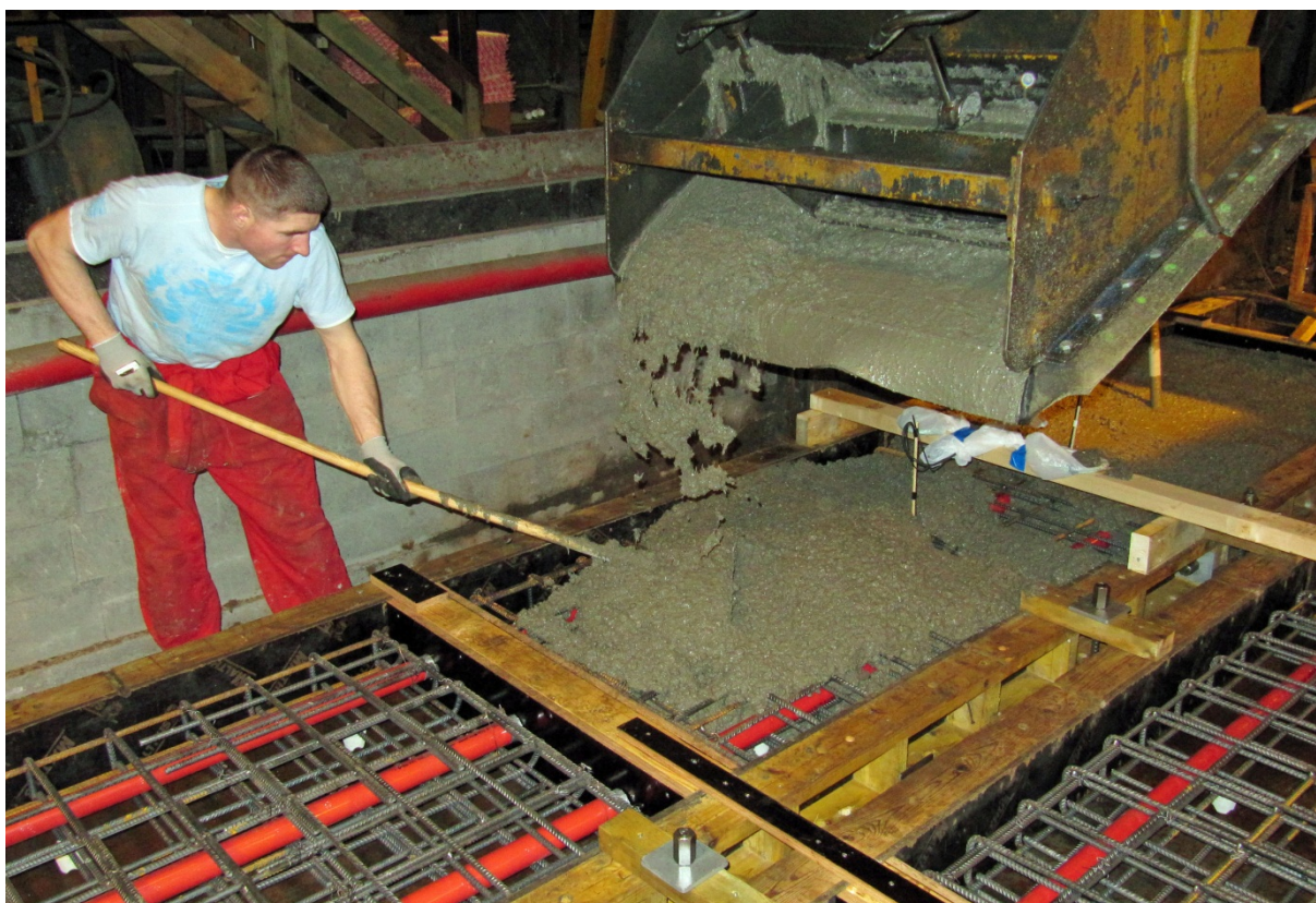
Figur 14 Støp av kulvertelementer (K20)
