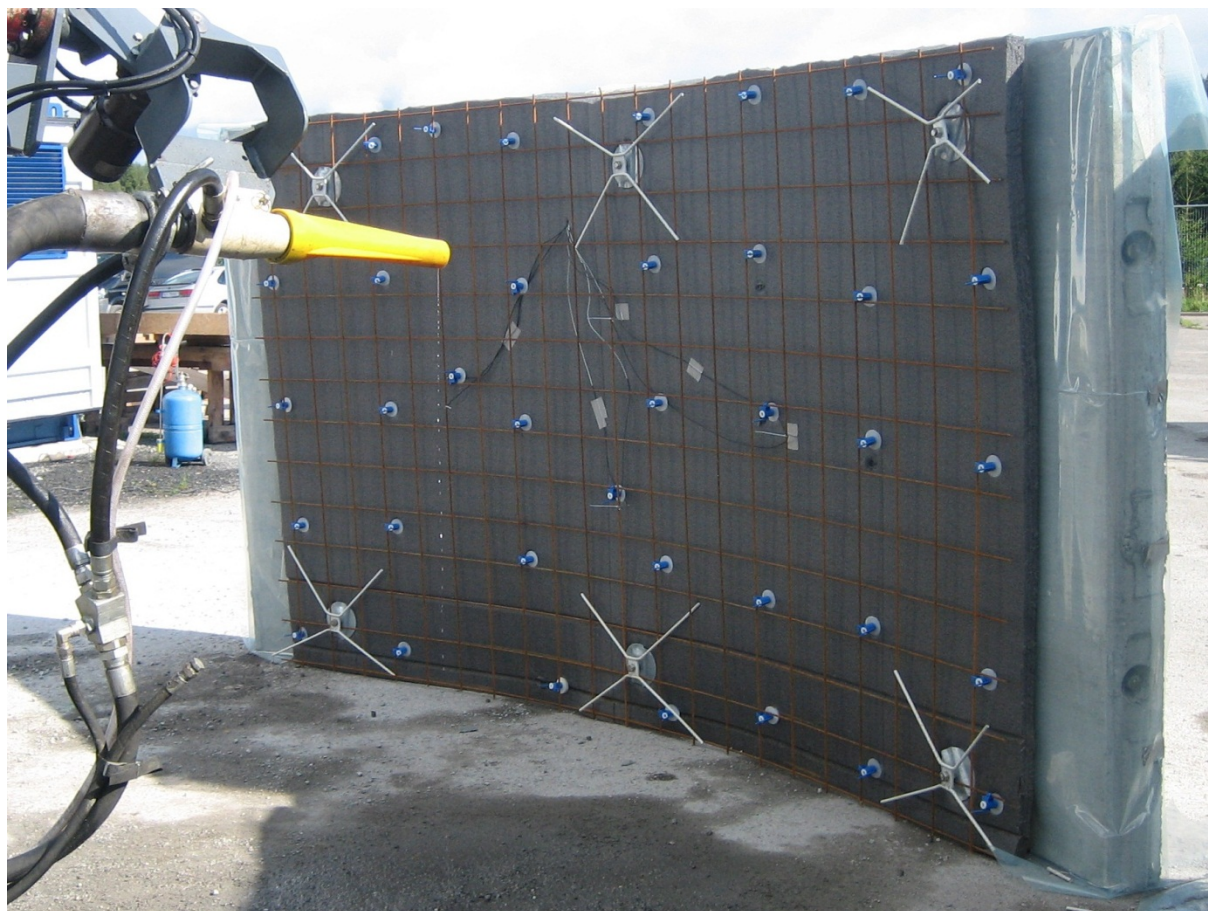
Figur 17 Krumt element før påføring av sprøytebetong
