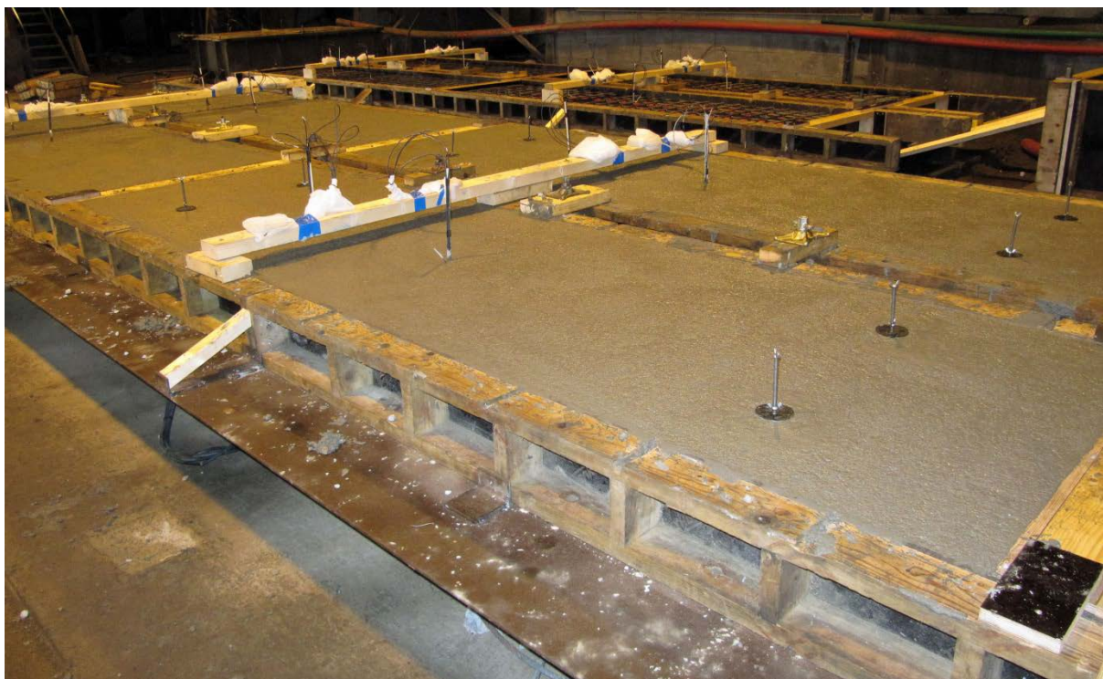
Figur 15 Kulvertelementer (K20) ferdig støpt
