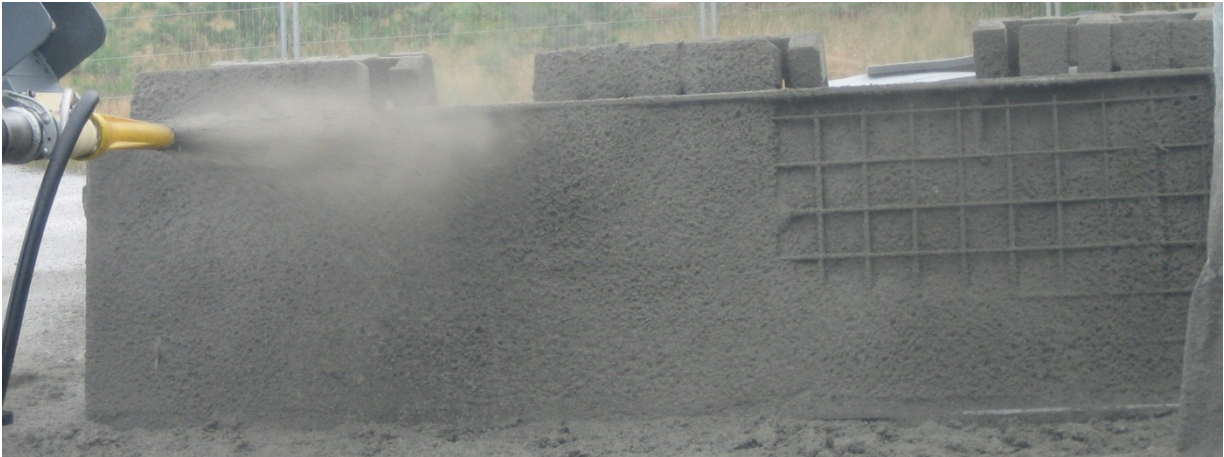
Figur 19 Sprøyting av et S15 element
