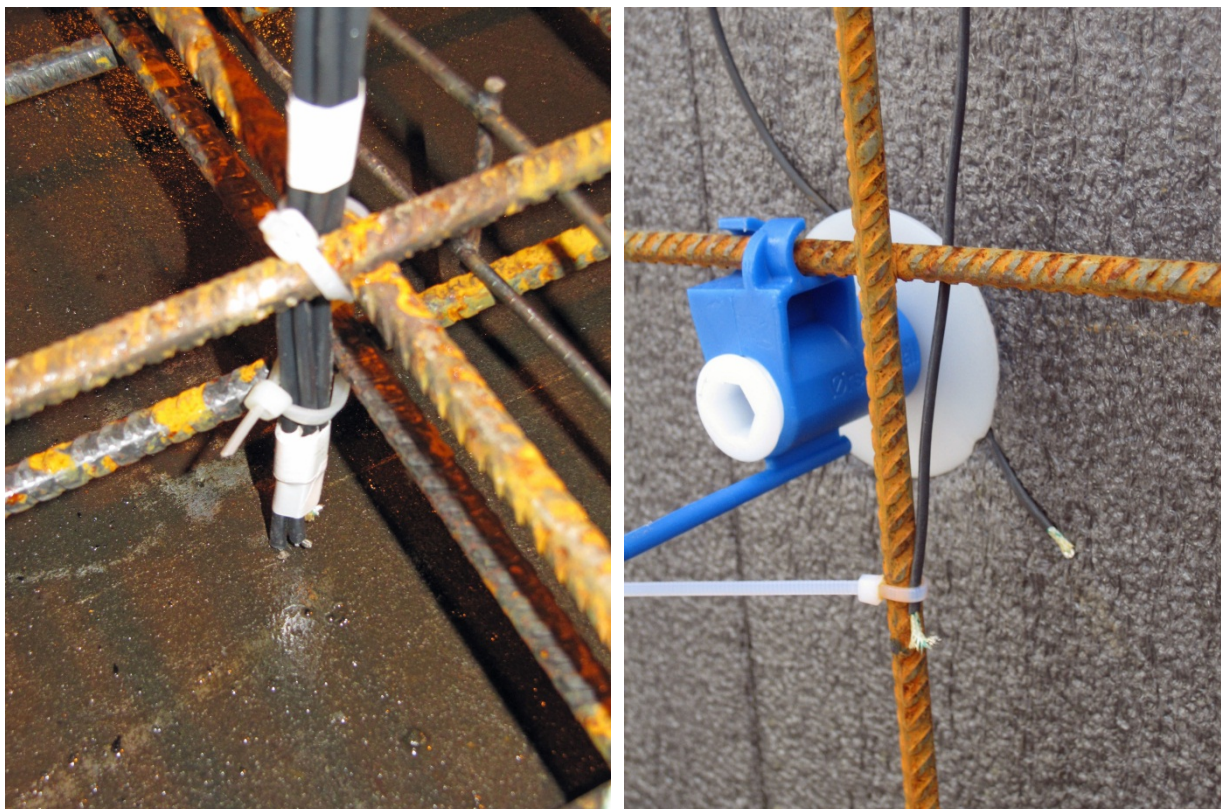
Figur 9 Ferdig monterte termotråder i testelement av konstruksjonsbetong før støping
