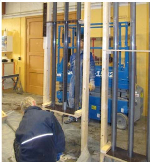
Figur 35 Gysing av kombinasjonsbolt installert i PVC-rør
