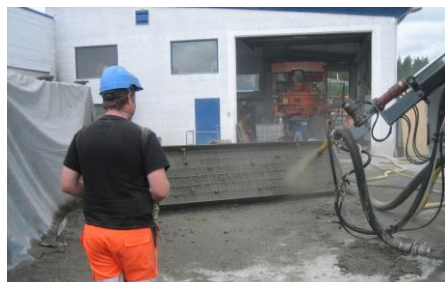
Produksjon av testelementer hos Mapeis Shotcrete Test Center
