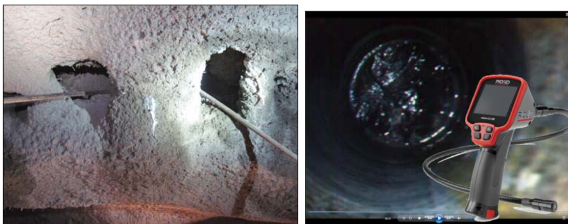
Figur 48 Ufullstendig innsprøytet bue og eksempel på borhullsbilde fra endoskopvideo.
