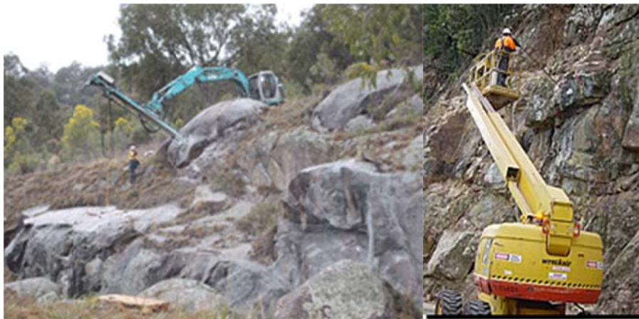
Figur 36 Sikring av bergblokker med bolter.
