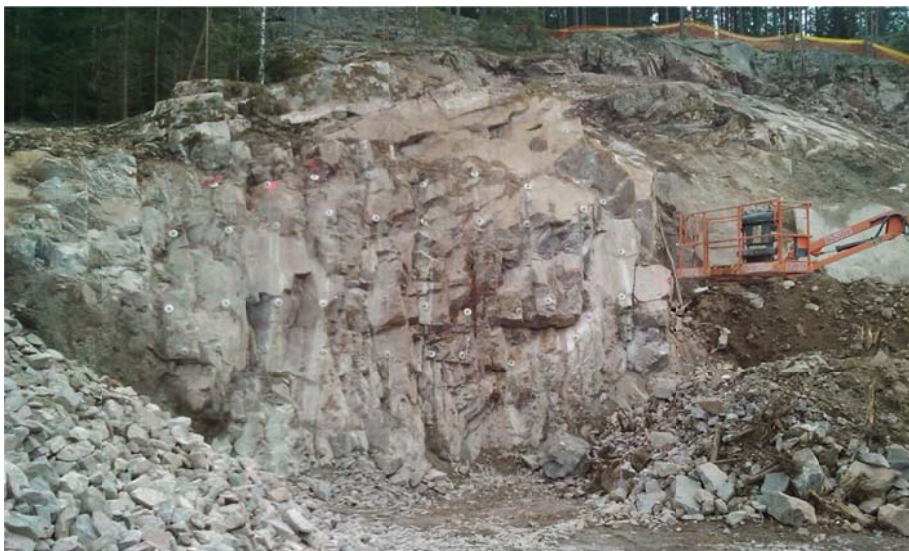
Figur 33 Bolting av blokk som ligger på en sleppe med svelleleire
