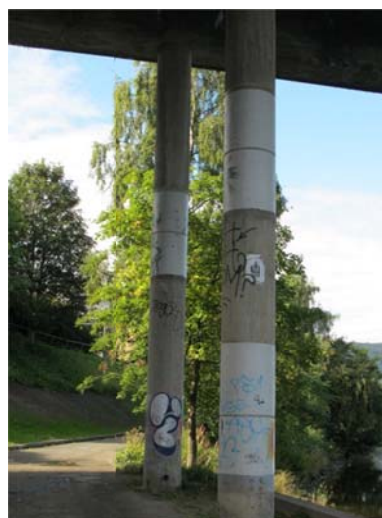
Figur 27 Forsøksfelt med karbonfiberomvikling. Foto: Eva Rodum, Statens vegvesen.
