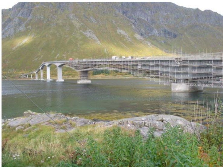
Figur 14 Gimsøystraumen bru – arbeid med katodisk beskyttelse (i stille og pent vær...)
