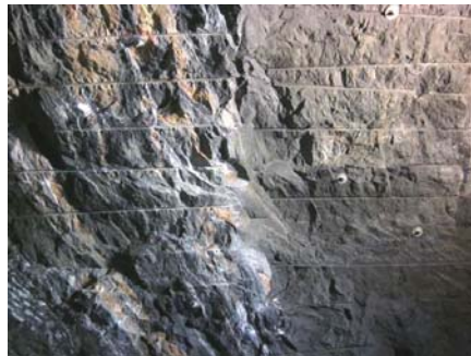
Nærbilde av hengen, gjenstående borpiper tyder på skånsom sprengning
