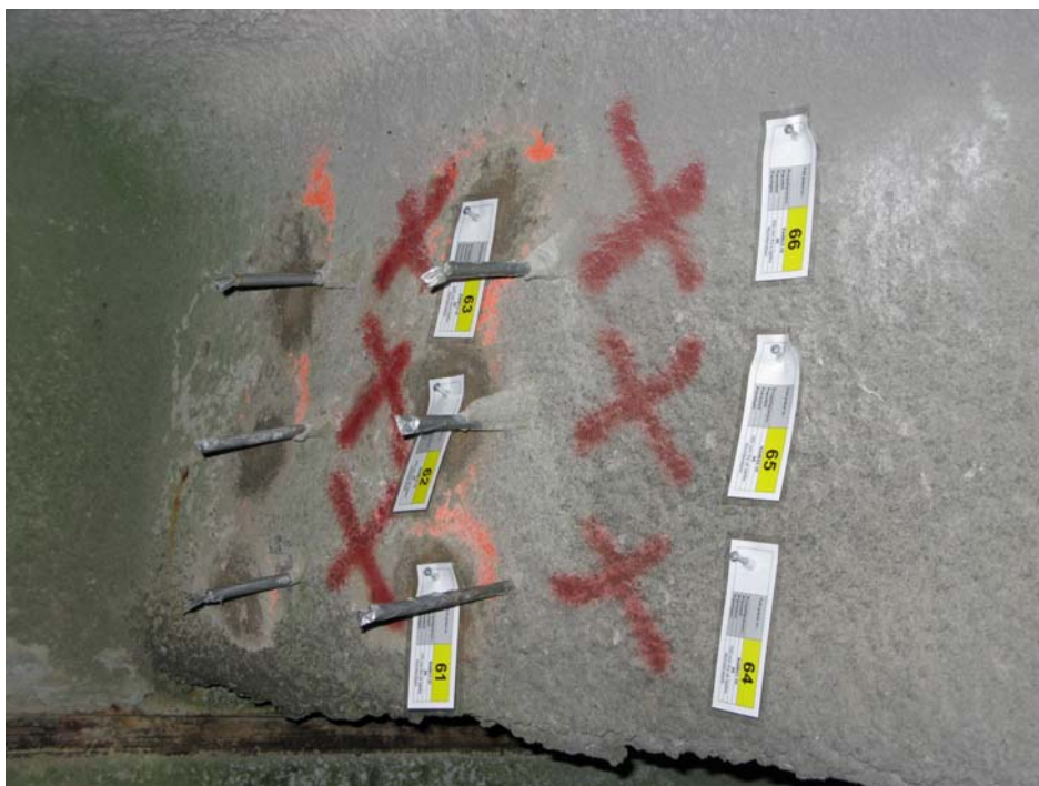
Figur 68 Foto tatt etter merking for prøveuttak. Røde kryss viser lokalitet av borkjerner på indre del av bjelke i akse 44.
