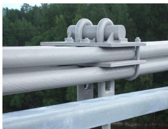
FIGUR 2 EKSEMPEL PÅ KORRODERT OVERFLATE PÅ HENGEBRUKABLER FØR OG ETTER TILTAK (VAMMA BRU PÅ FV 115 I ØSTFOLD)
