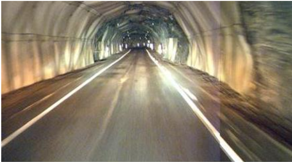
FIGUR 4 EKSEMPEL PÅ UBESKYTTEDE PLATER AV POLYETYLEN(PE) SKUM
