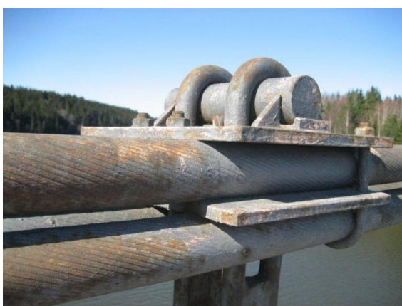
FIGUR 2 EKSEMPEL PÅ KORRODERT OVERFLATE PÅ HENGEBRUKABLER FØR OG ETTER TILTAK (VAMMA BRU PÅ FV 115 I ØSTFOLD)
