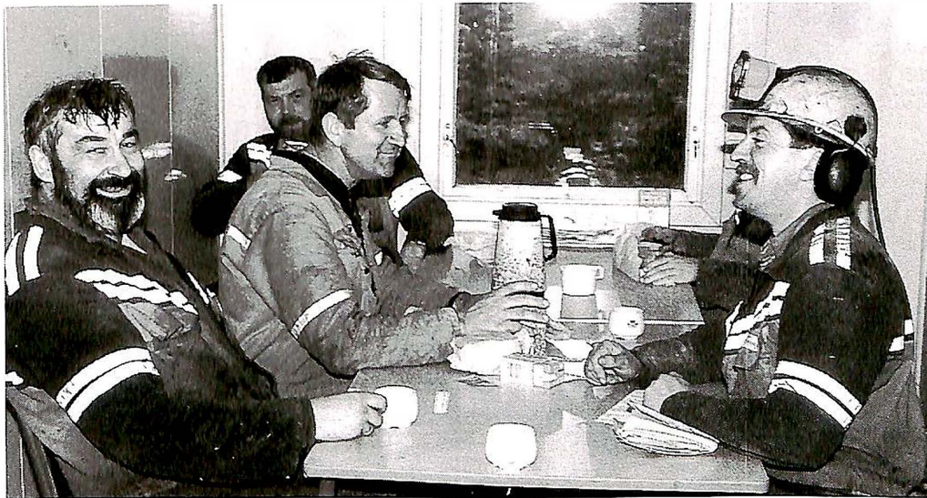
Fire av mannska som er i gang med Kolltveittunnelen. Frå venstre: Sigbjørn Smådal, Ingvald Sleire (bakerst), Normann Sleire og Gunnar Bernes. (Foto: Anne Britt Moen.)
