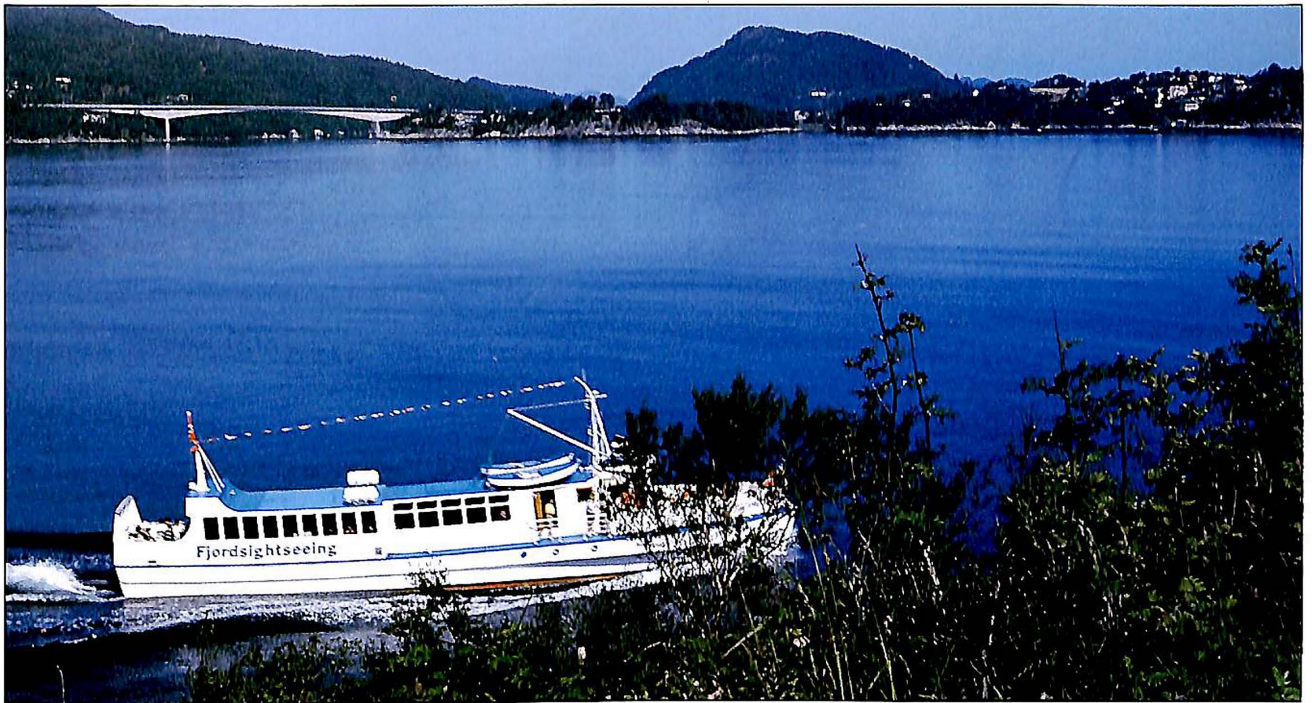
Frå det planlagte brufestet på Klauvaneset. Turbåten «White Lady» passerer i farvatnet der høgbrua vil bli strekt. I bakgrunnen til høgre Flatøy. Flytebrua vil «danda» omlag i høgre biletkant.
