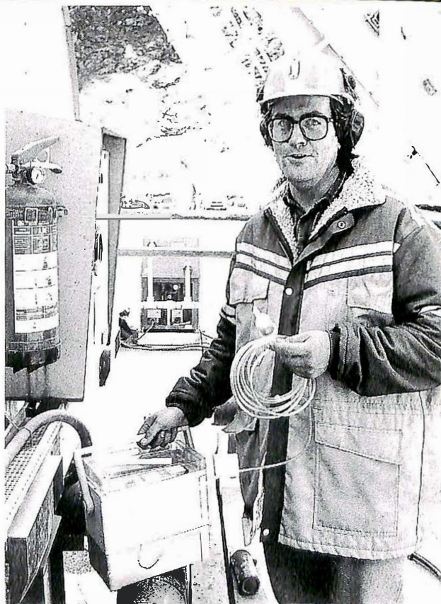
Assisterende verneleder Gunnar Gjæringen med det nye måleinstrumentet for kulloksyd og nitrogendioksyd.
