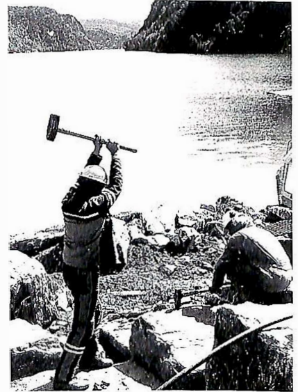
Etter at verket kom i drift har det vore tilpassingsarbeider på uteanlegget, m.a. bygging av tørrmur på tilkomstvegen.
