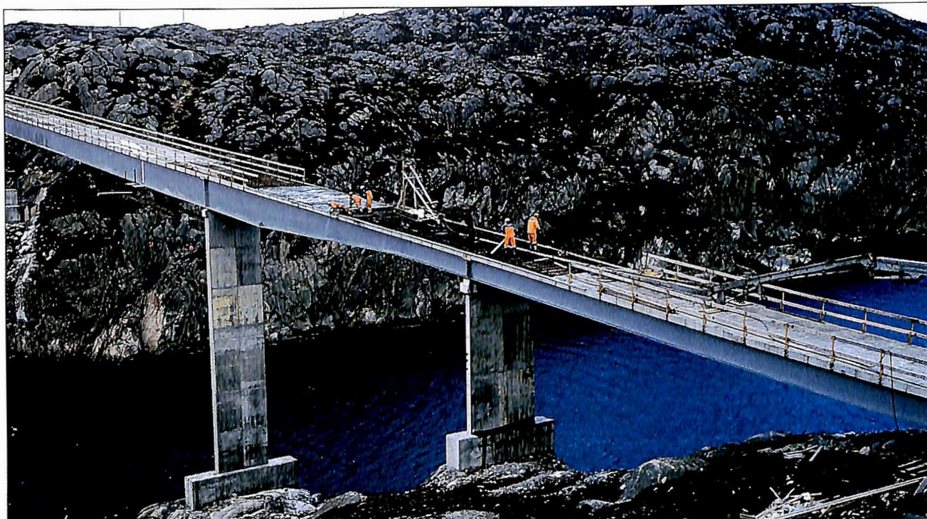
Innsjutt på dekkestøyp på Brandasundet bru, sett frå Selsøy mot Gissøy.
