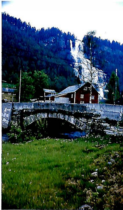
Tvinnebrua ligg ved den vakre Tvinnefossen, ein popul r plass i turistsesongen. Den nye vegplanen for parsellen gjev rom for ny campingplass i omr det. (Foto: Eirik R nvik.)
