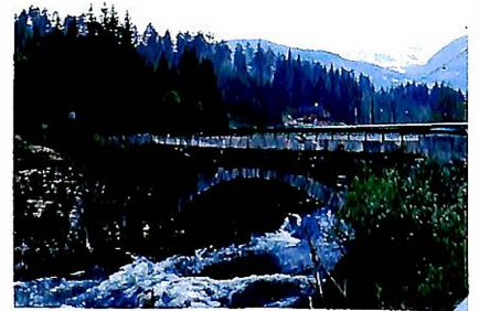
Ei ny 40 meter lang bru ved Skromle vil fjerna eit farleg ulukkespunkt og «standardsjokk». (Foto: Eirik R nvik.)
