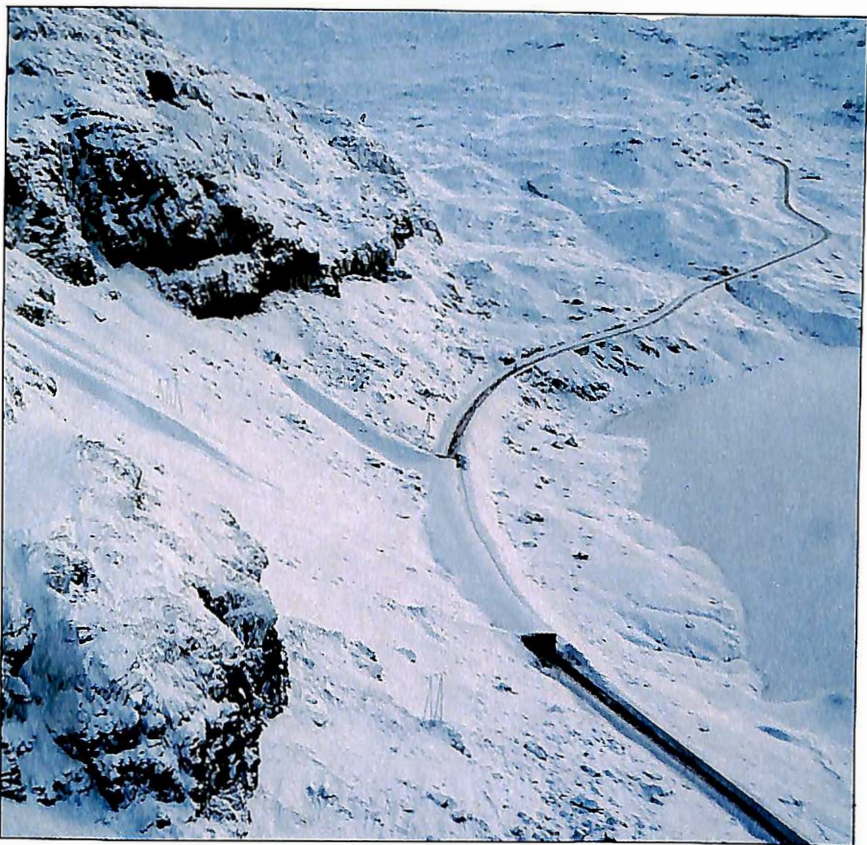
Oversikt over E 76 ved rasoverbygget i Svandalsflona, slik det tek seg ut frå helikopter, sett i austleg retning mot Midtlæger (øvt til høgre på biletet). Snøskjermen skal hindra ras vest for overbygninga, i framgrunnen på biletet. Det er vidare planar om utbygging av ledevollen som vi ser skuggen av opp frå austenden av rasoverbygget. I fjellsida 100 meter aust for rasoverbygget er det planar om å leggja ut sprengladningar til å skyta ned ras frå neste haust.
