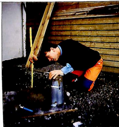
Kontrollingeniør Jomar Haktorsen måler betongkvalitet daglig mens støping pågår.
