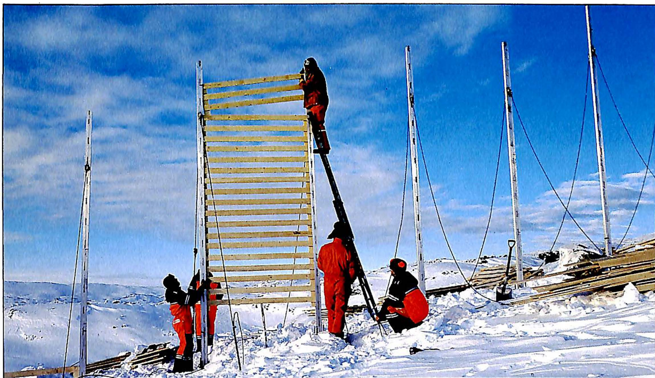
Stengene er festa, og montering av sjølve skjermdelane er i gang på Svandalsflonanuten.
