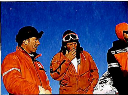
Tor Rønhovde (t.v.) og Johan Sandal frå vedlikehaldsområde R 5 leia arbeidet med montering av snøskjermen.
