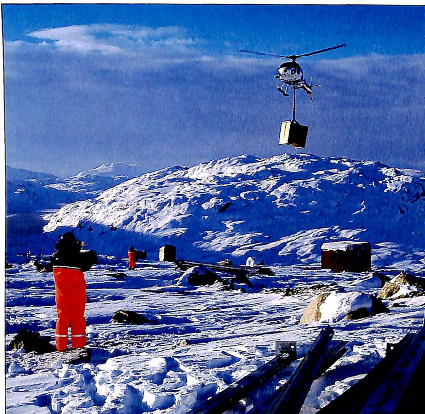
Materialane til snøskjermen blei løfta til fjells med helikopter.
