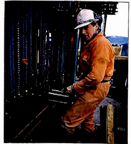
Armeringen bindes hele tiden i en halv meters forkant av betongstøpingen, etter hvert som tårnet reiser seg.
