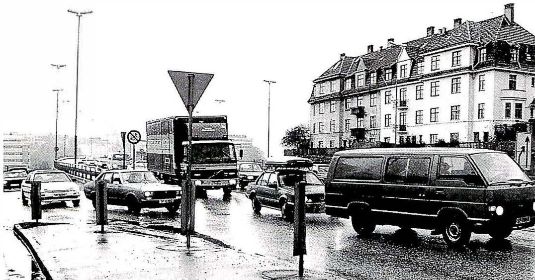
I påkøyringsrampen frå Gamle Nygårdsbro til E-68 skjer det ein del påkøyrslar bakfrå.
