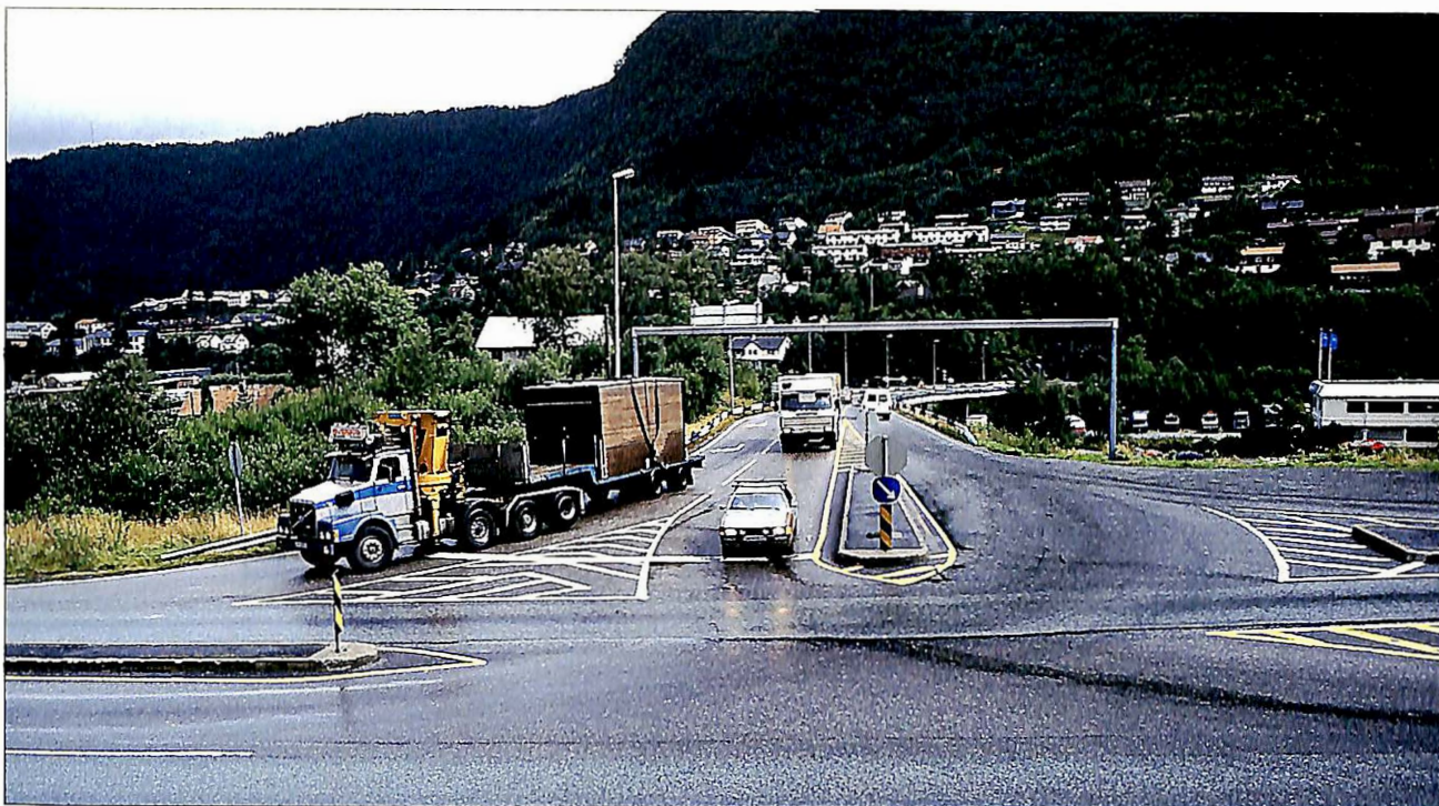
Krysset Rv 560 – E 68, ved avkjørselen til Arnanipatunnelen. Ved hjelp av innsparte vedlikeholdsmidler kan det ulykkesbelastede krysset bygges om til rundkjøring. (Foto: Erling Grønsdal).
