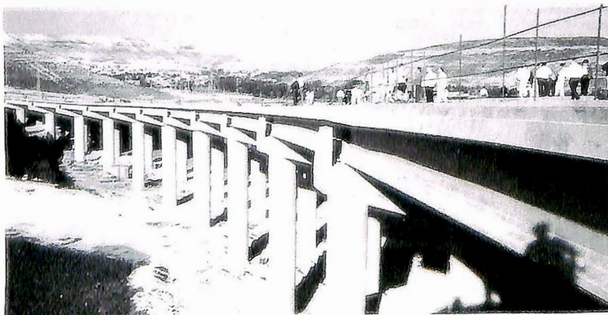
Viadukt på nyanlegget Aragon ekspressveg, mellom Madrid og Barcelona.
