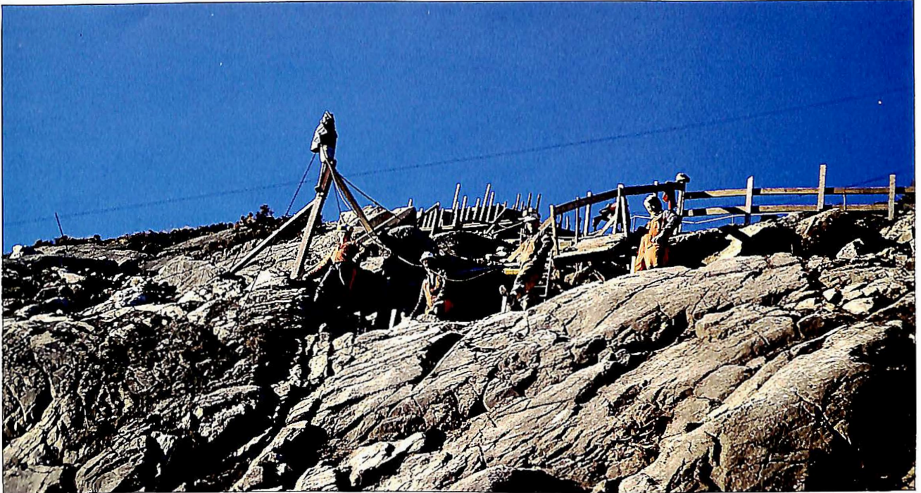
Vegvesen-mannskap på plataet på Gisøy, der brukaret skal byggjast. Frå venstre Jonny Helland, Asbjørn Halleraker, Sigmund Bøe og Arnfinn Tesdal.
