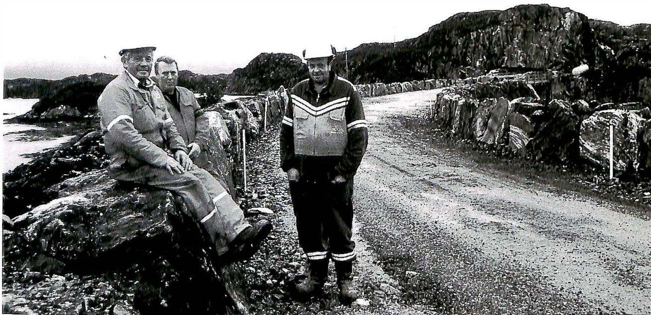
Tre av dei som har bygt rekkverk i naturstein på Øyanevegen. Frå v.: Gardar Monsen, maskinkøyrar Kjell Grindheim og Arne Hindenes.
