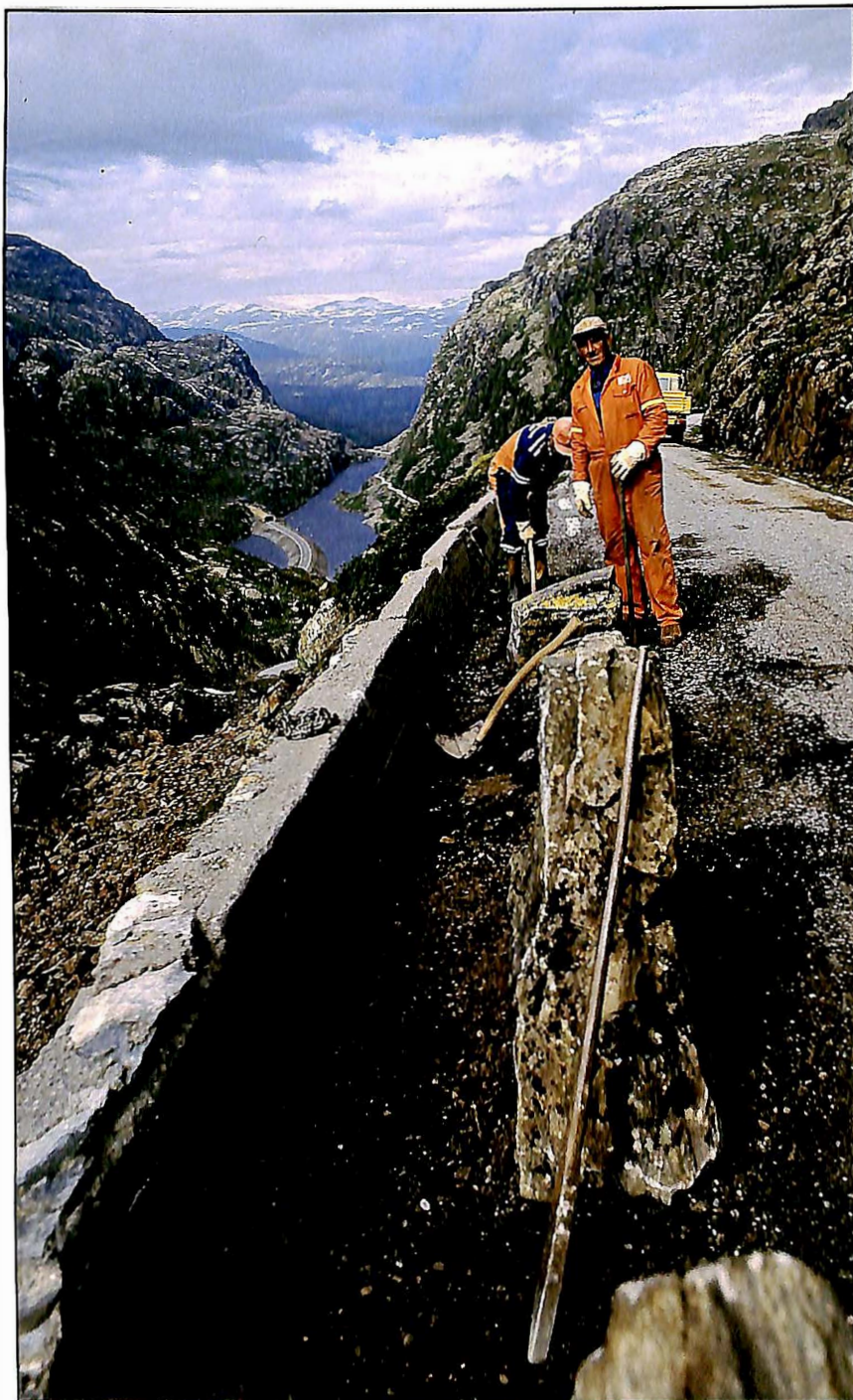
Innretting av rekkja med stabbesteinar skjer med presist augemål. Svein Seim har vore borti slikt arbeid før, med istandsetting av gamlevegen i Måbødalen.
