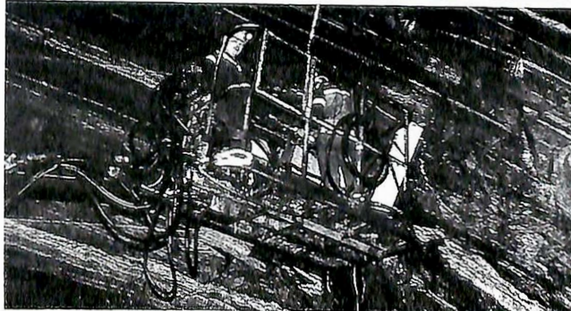
Over: Tunnelbas Jostein Flatekval gjer klar til sprenging av gjennomslagsalva i Hyvingtunnelen.
