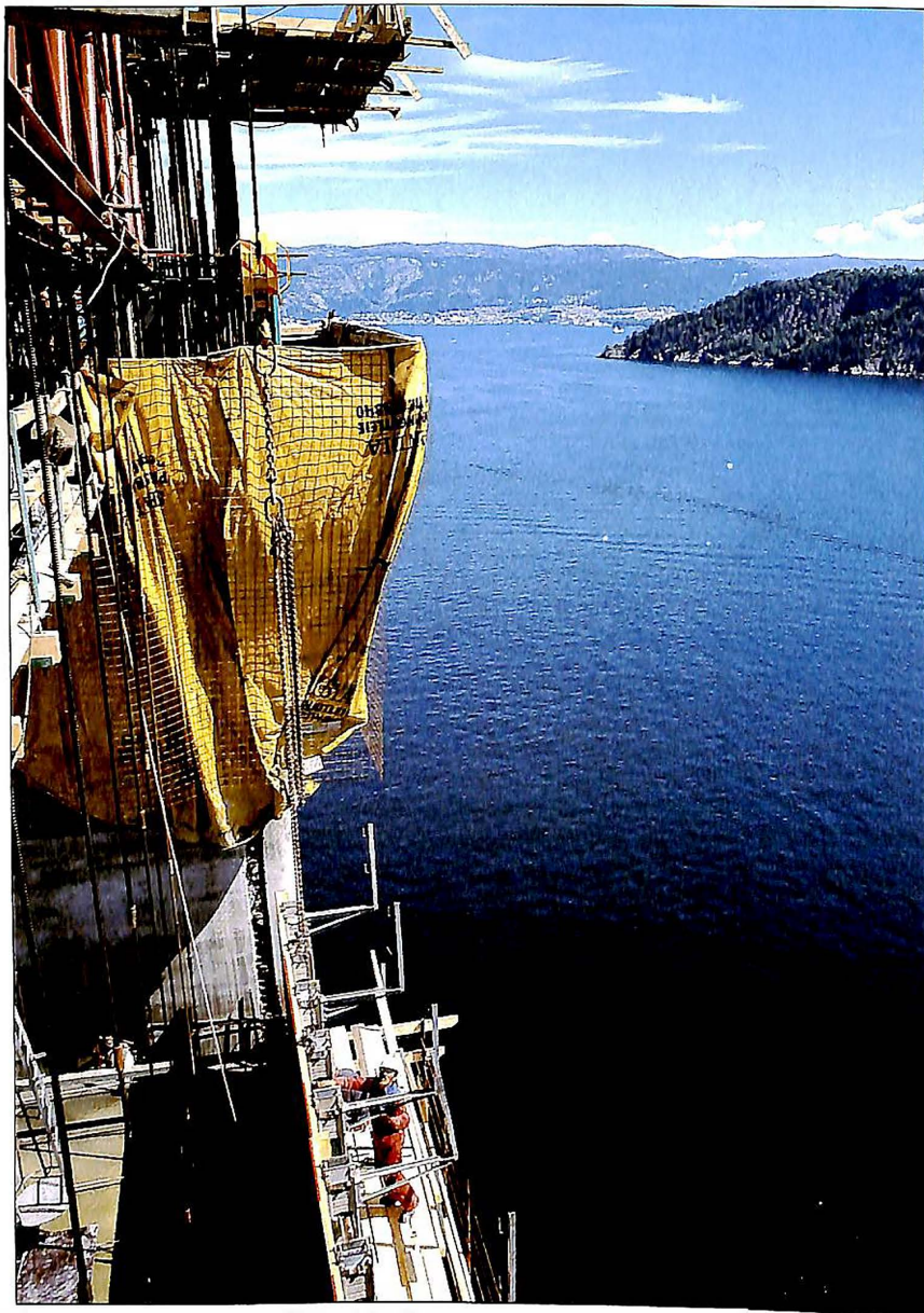
Samferdslenemnda kjem til Hordaland, og skal m.a. sjå på askøybruprosjektet, der første brutårnet nærmar seg fullføring.
