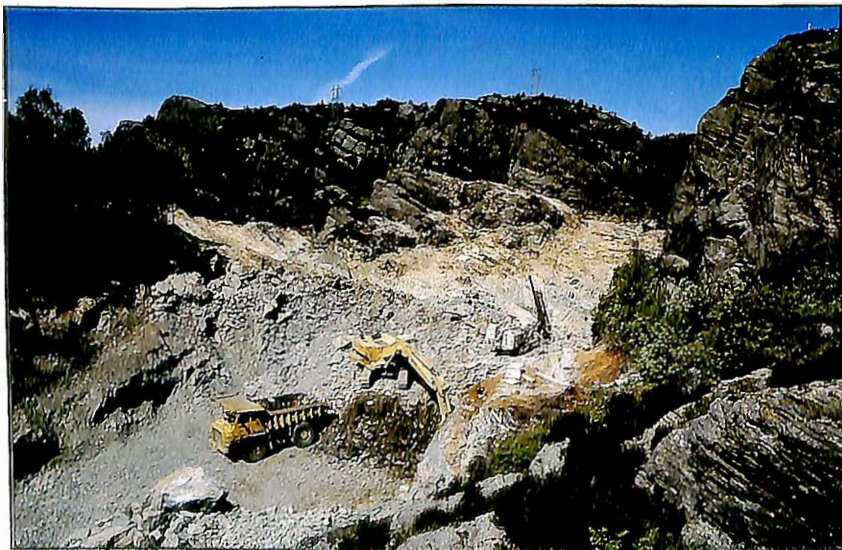
Arbeid med sprenging og masseflytting for rampe nord for Storeklubben viadukt.
