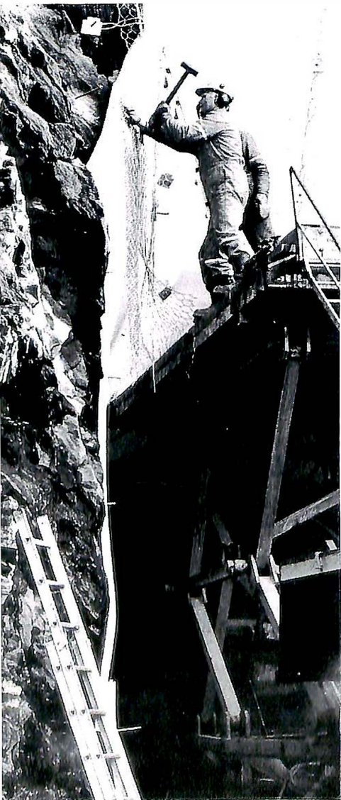
Snubling og fall er ei av dei mest typiske av arbeidsulukkene i vegarbeidsdrifta.
