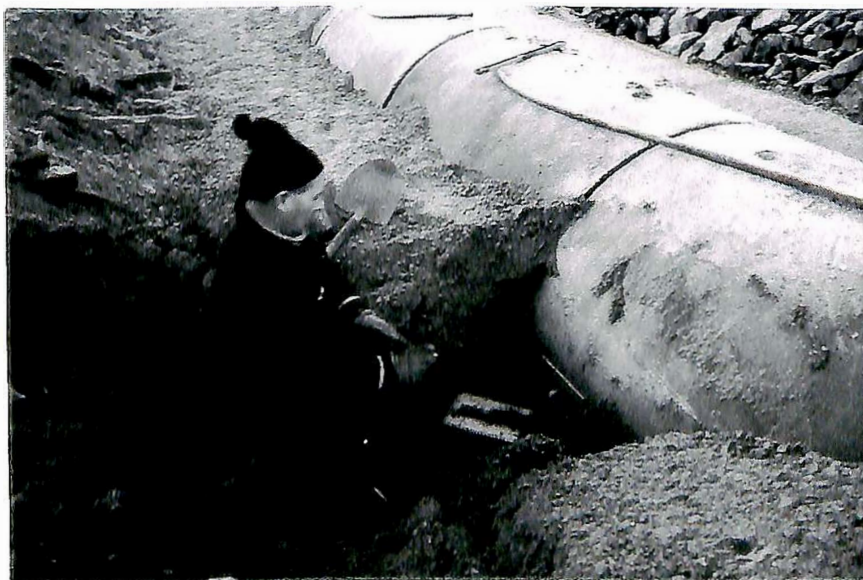
Installering av trykkceller.
