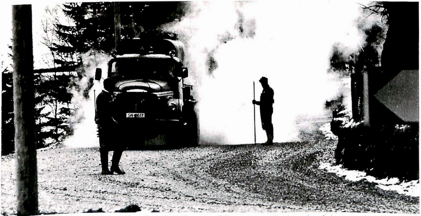
Maskinprosjektet vil vonleg gje betre rom for meir marknadstilpassa maskininvesteringar, t.d. auka satsing på eige utstyr til dekkelegging. (Arkivfoto: Thorstein Haugen).
