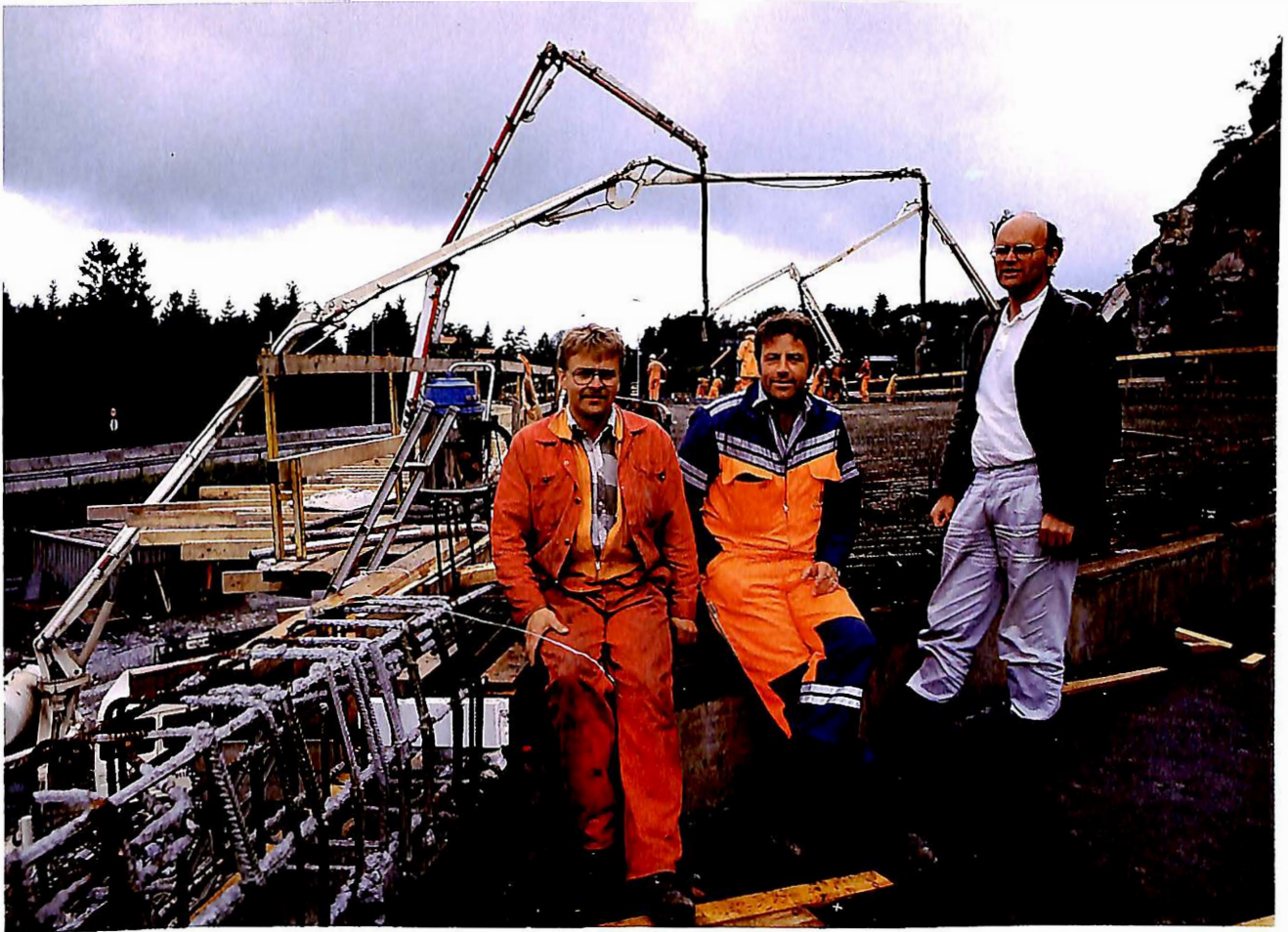
Nøkkelpersonar under bygging av viaduktene på nordre innfartsåre, med 4 betongpumpar i sving på Storbotn-anlegget i bakgrunnen. Frå venstre Jon Henning Strandos, Selmer-Furuholmen, og Vegvesenets eigne Magnar Teigen og Helge Giljarhus.
