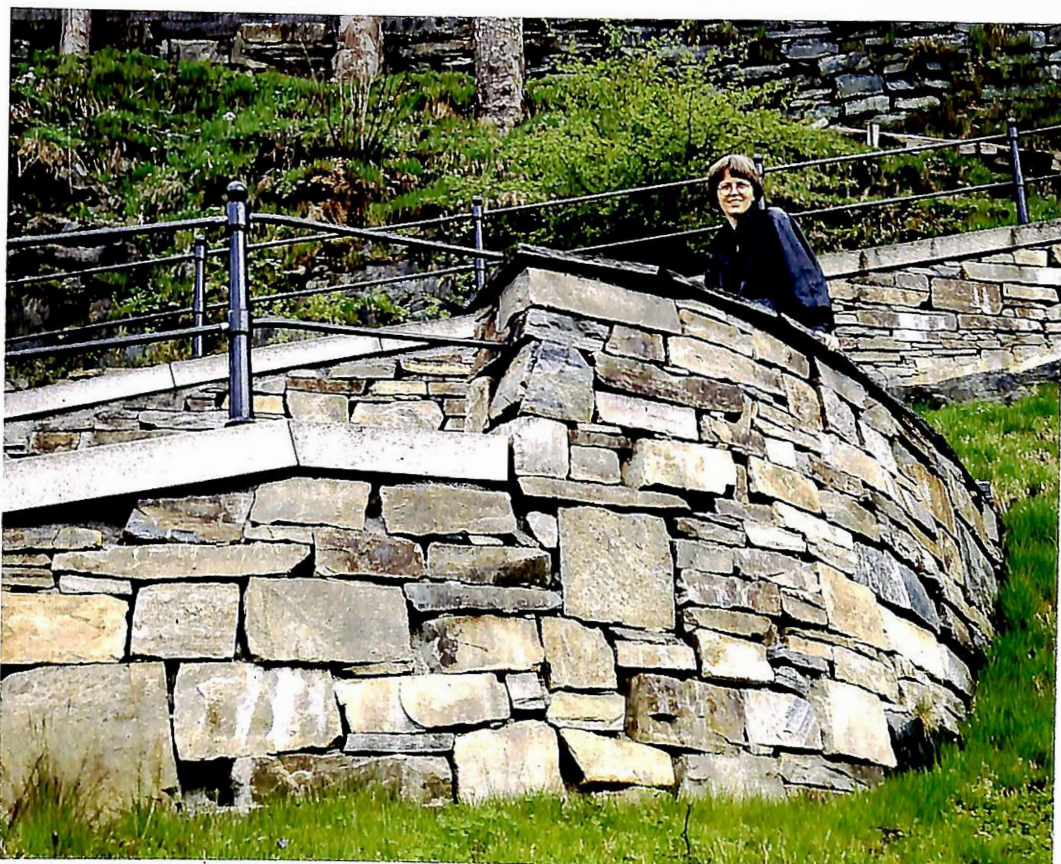
Gangveganlegget i Forskjønnelsen i Bergen er vel verd å vise fram som et pent prosjekt i Vegvesenets regi, sier Tone Høyland Stople. Det spesielle parkanlegget ble gjenoppbygget av Statens vegvesen Hordaland fordi tunnelanlegget rett under (Fløyfjellstunnelene) gjorde skade på de gamle trappene på Kalfaret.
