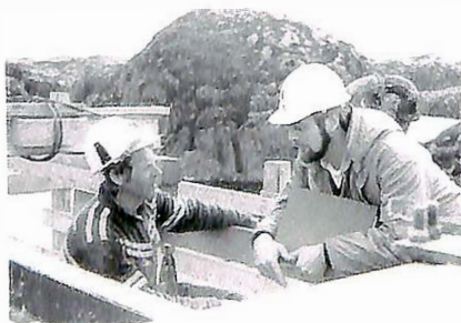
Arbeidsformann Dagfinn Måge (t.v.) og anleggsleiar Sigve A. H. Martinsen i samtale på toppen av den 20 meter høge brutårnforskalinga.
