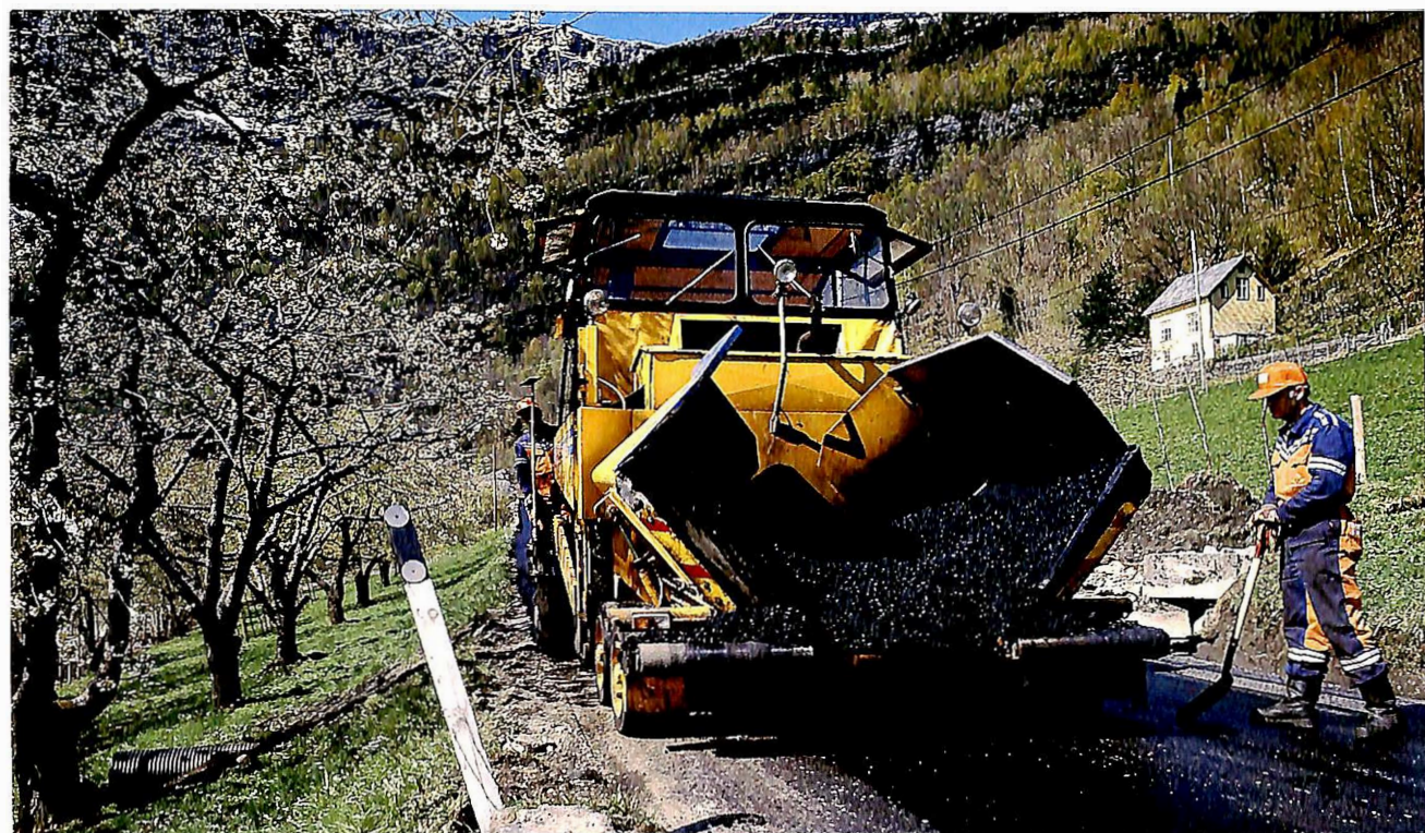
Målinger på årets asfaltdekker viser en halvering av hulrommet. Bildet er tatt under asfaltlegging på E68 ved Lussand i Hardanger.
