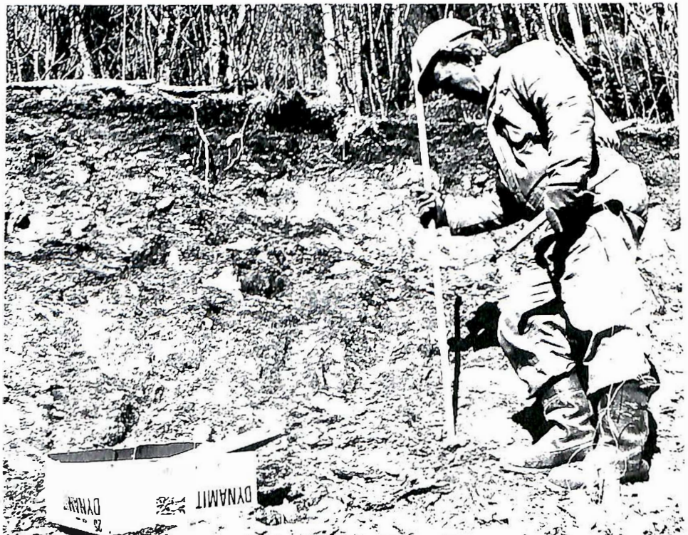
Et grovere mønster for dynamitthull gir reduserte kostnader.
