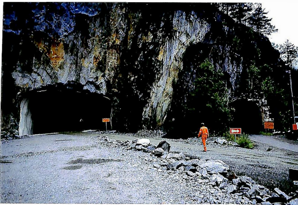
Den nye Væle-tunnelen (t.v.) er ei vidareføring av eit eldre masseuttak for NSB. Noverande riksveggtunnel på veggen Evanger-Bolstad til høgre. (Foto: Erling Grønsdal.)
