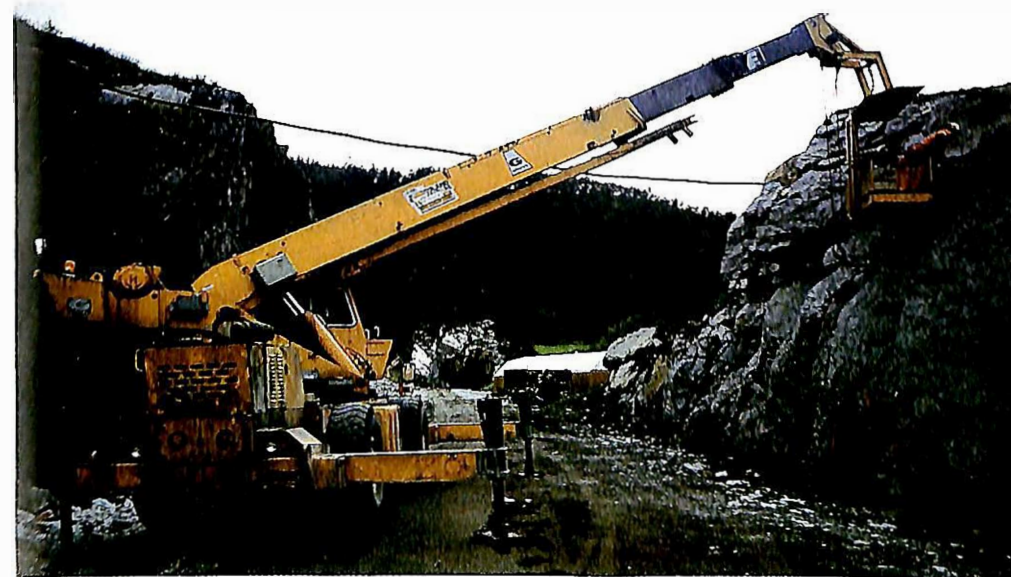
Rensking av fjellskjæring på Hernes blir gjort frå korga til mobilkranen. (Foto: Erling Grønsdal).
