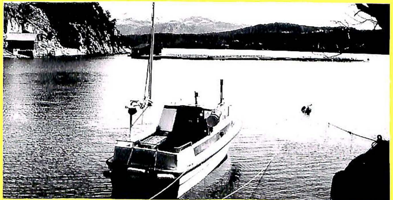
Sjarken «Toffen» av Lønningdal har vore med på anleggsarbeidet forbi Rødsliane. Ein god del skog har hamna direkte i fjorden under sprengingsarbeidet. Ikkje minst av omsyn til merane hos Evos, forsøksstasjonen for fiskeoppdrett, i bakgrunnen på biletet, har vore viktig å «fiske» opp krattskog frå sjøen. (Foto: Erling Grønsdal).
