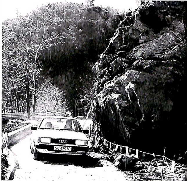
Fylkesveg 137 er først og fremst lokalveg for bygdene lengst aust og nord i Os kommune, men gjennomgangstrafikken aust-vest i Midthordland, om Rødsliane, er aukande. (Foto: Erling Grønsdal).
