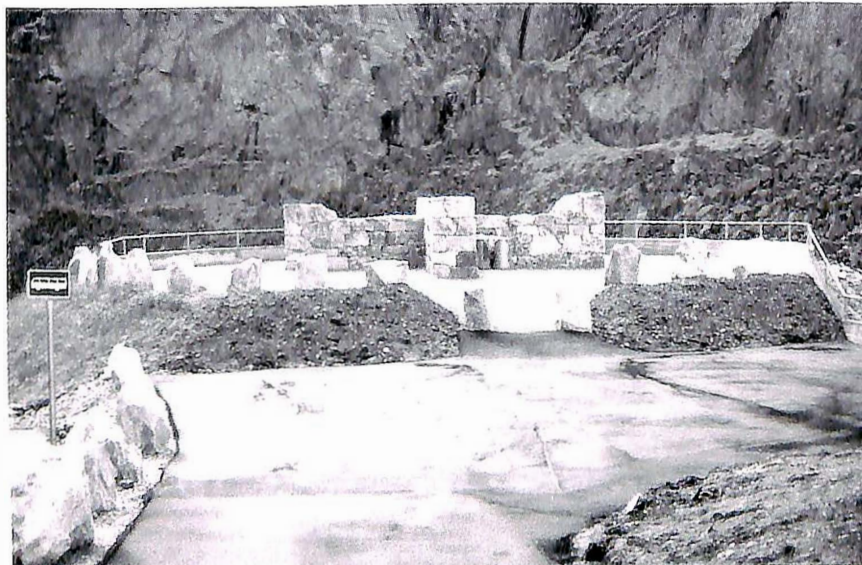
Det skal byggjast tak over to av rasteplassane i Måbødalen.
