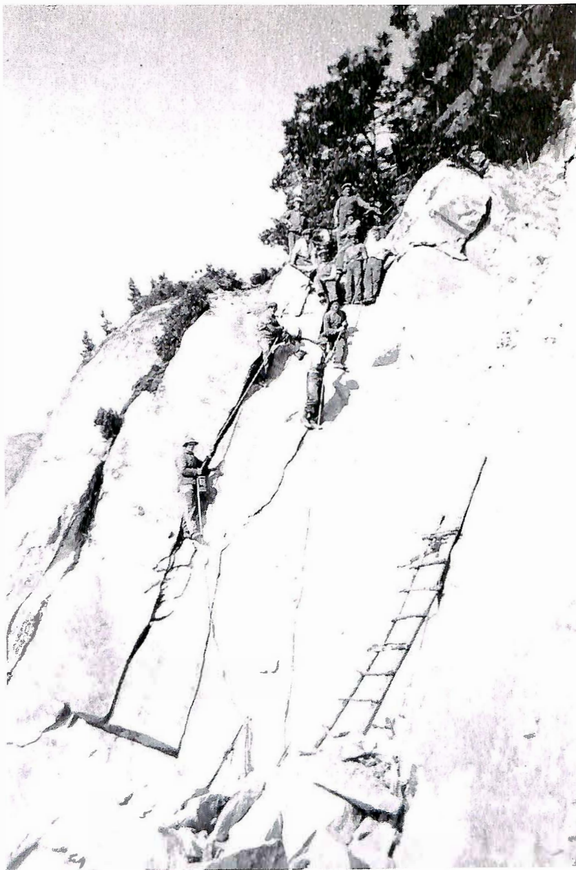
Det er nerver av stål hos desse karane som byggjer veg i Lussandberget. De ser riktig så avslappa ut i stupet, med fjorden 90 meter nedanfor.
