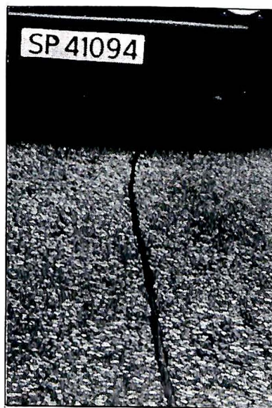
En induktiv sløyfe i veibanen gir signal til styringsenheten om at et kjøretøy er i anmarsj.
