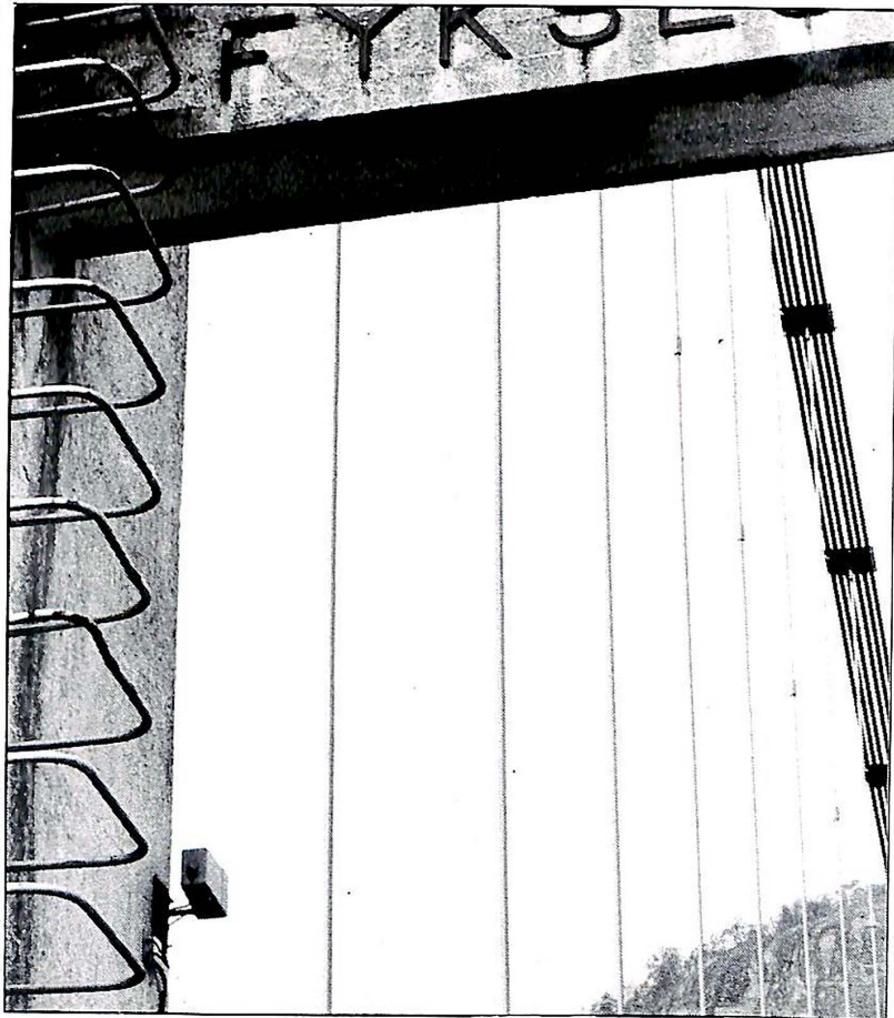
Radaren registrerer om det er kjøretøyer på bruene. Hvis ikke ...
